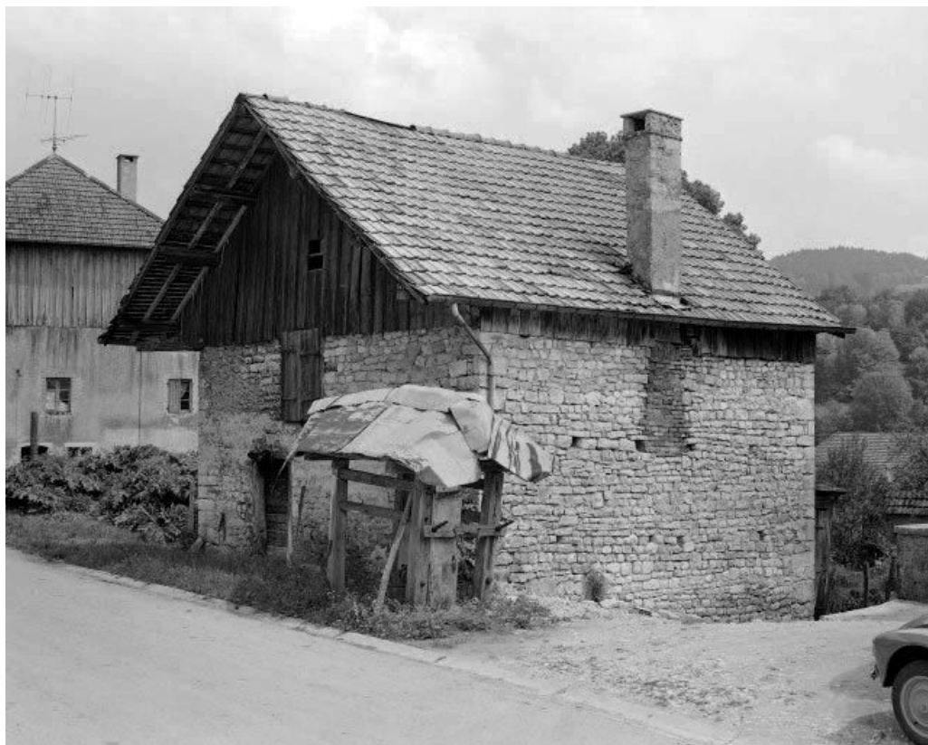
Le bâtiment de la forge : vue de trois quarts droit.
