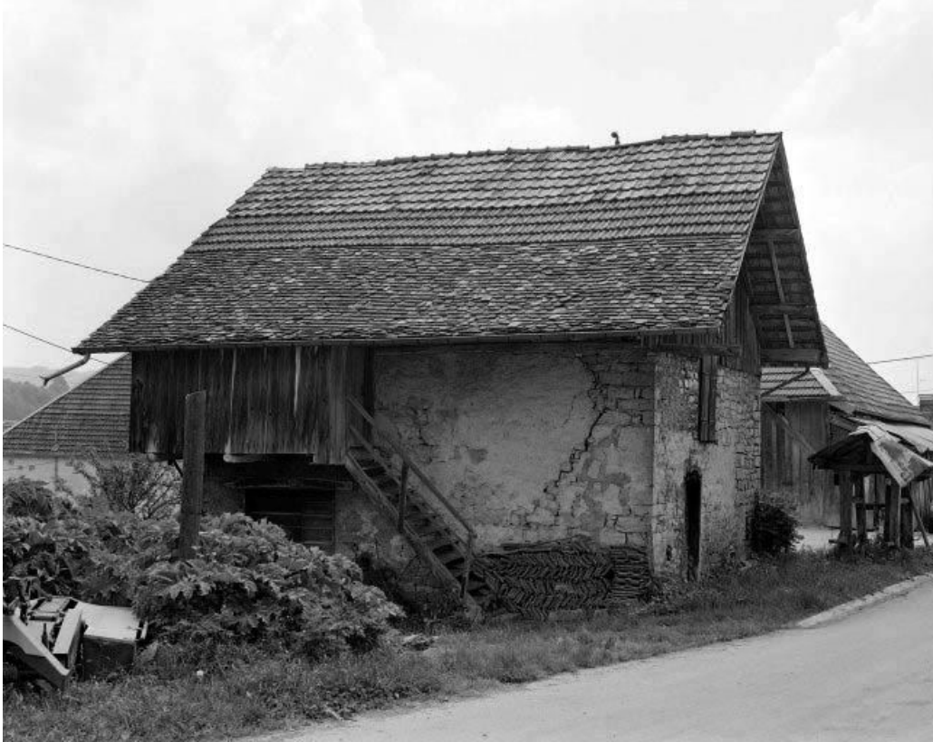
Le bâtiment de la forge : vue de trois quarts gauche.
