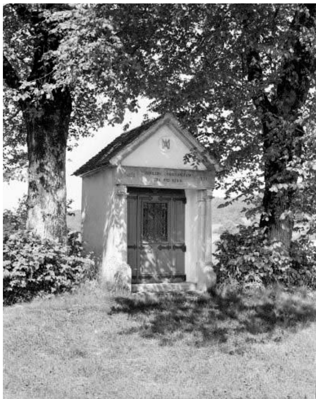
Vue de trois quarts gauche. 25, Aubonne rue des Chalets
