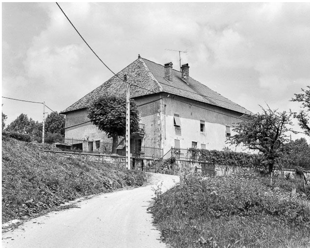
Façades antérieure et latérale gauche. 25, Aubonne
