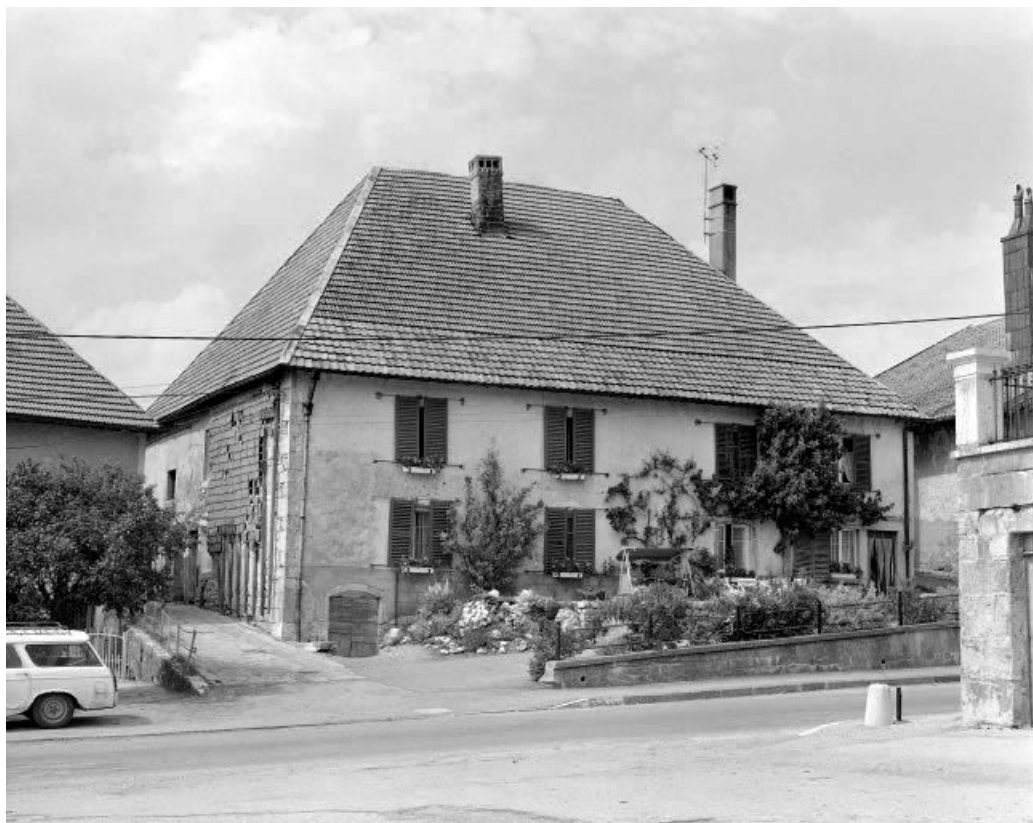
Façades antérieure et latérale gauche.
