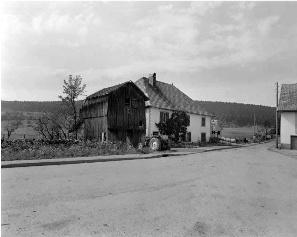
Vue d'ensemble. 25, Arc-sous-Cicon
