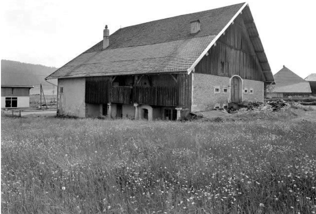
Façades postérieure et latérale droite.
