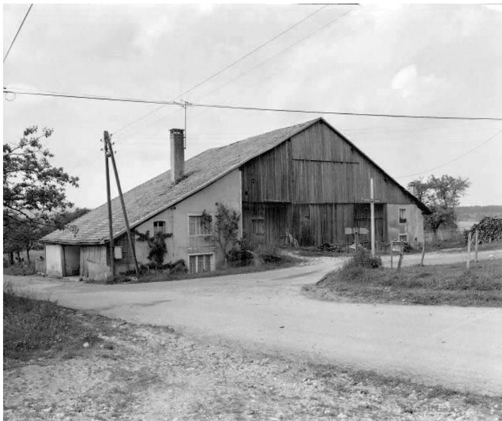
Vue d'ensemble. 25, Arc-sous-Cicon
