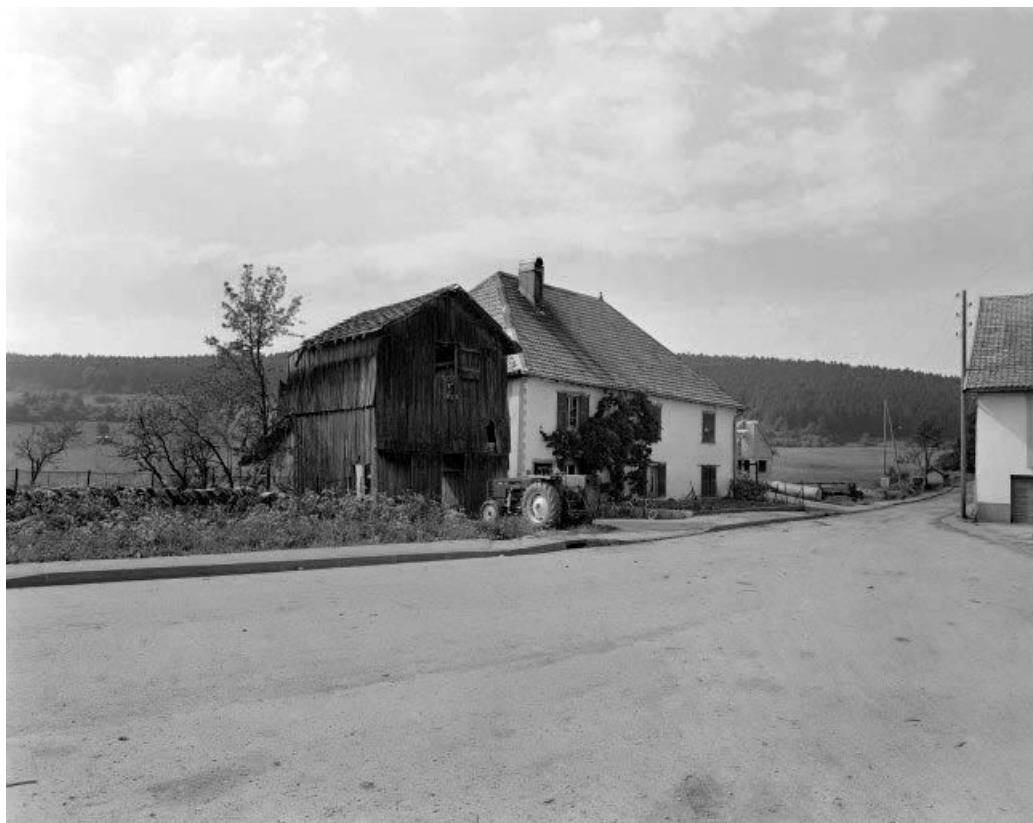
Vue d'ensemble. 25, Arc-sous-Cicon
