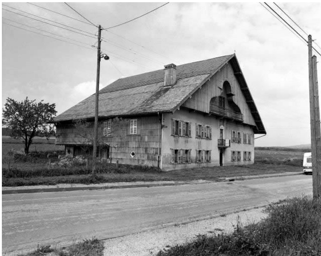
Façades antérieure et latérale gauche.. 25, Arc-sous-Cicon
