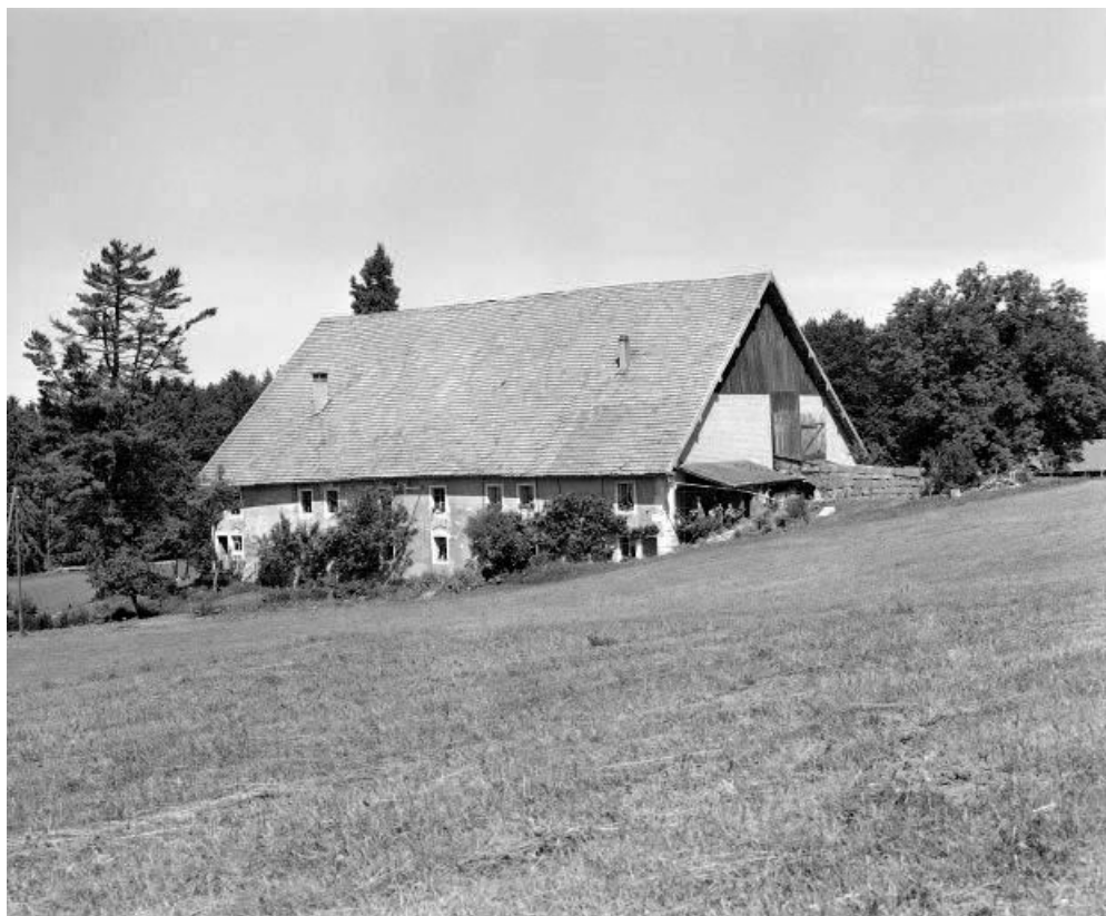
Façades antérieure et latérale droite.
