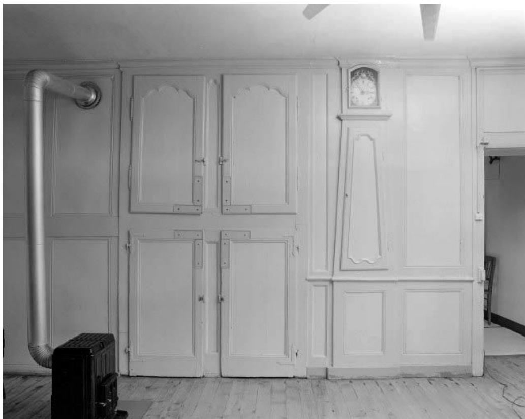
Le poêle : portes de placards et horloge encastrée.
