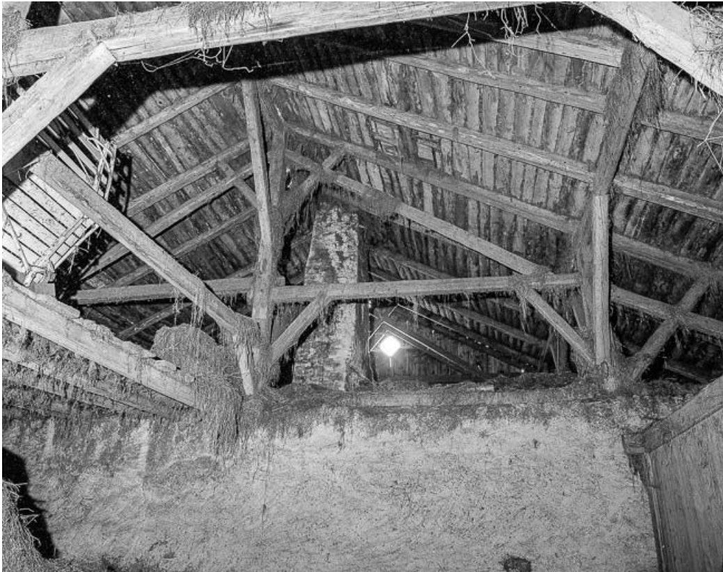
Charpente : vue d'ensemble.
