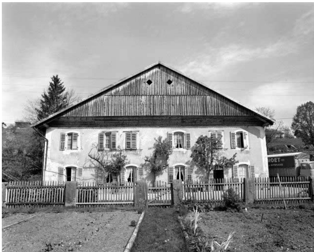
Facade antérieure et clôture du jardin-potager.
