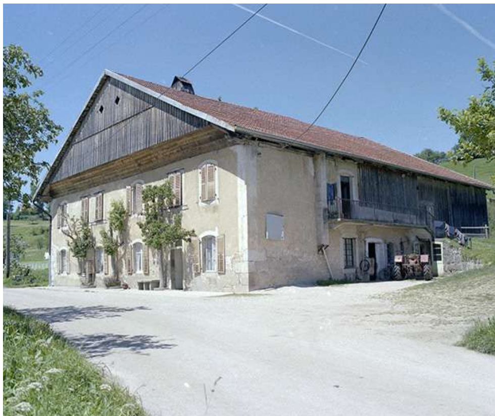
Façades antérieure et latérale droite.
