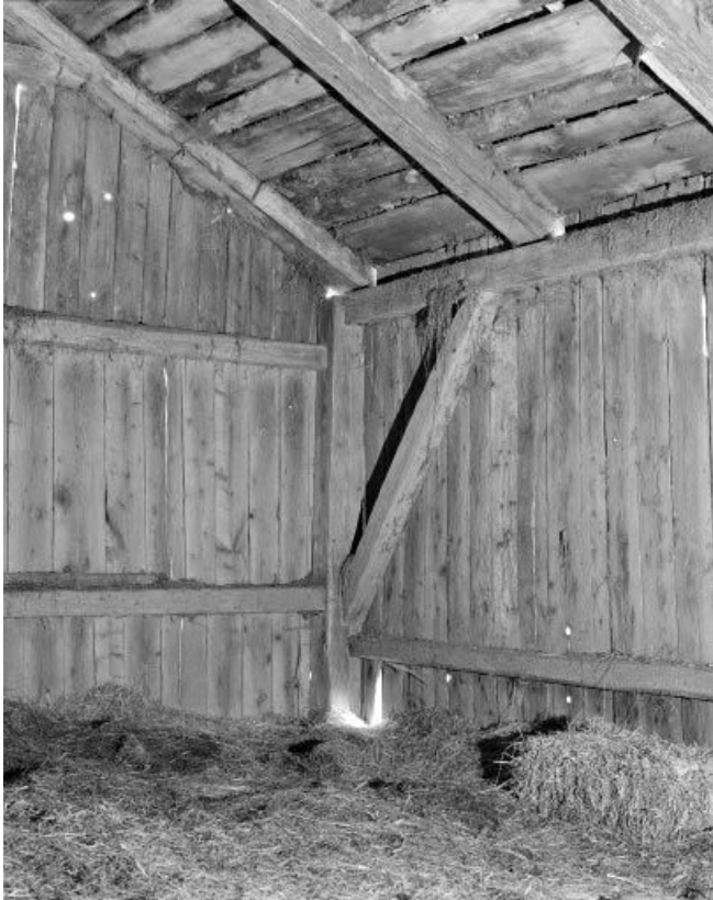
Détail de charpente : angle arrière droit. 25, Arçon rue du Canal
