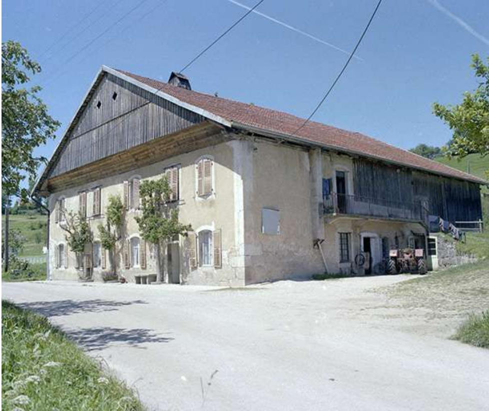
Façades antérieure et latérale droite.
