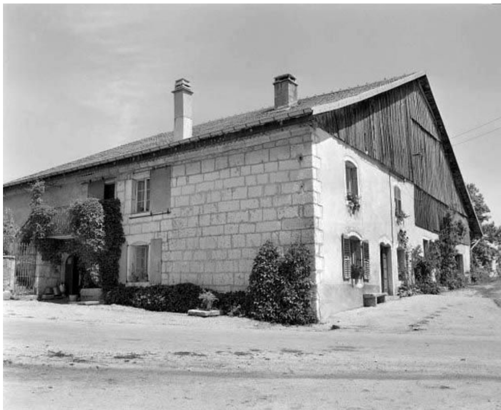
Facades antérieure et latérale gauche. 25, Arçon
