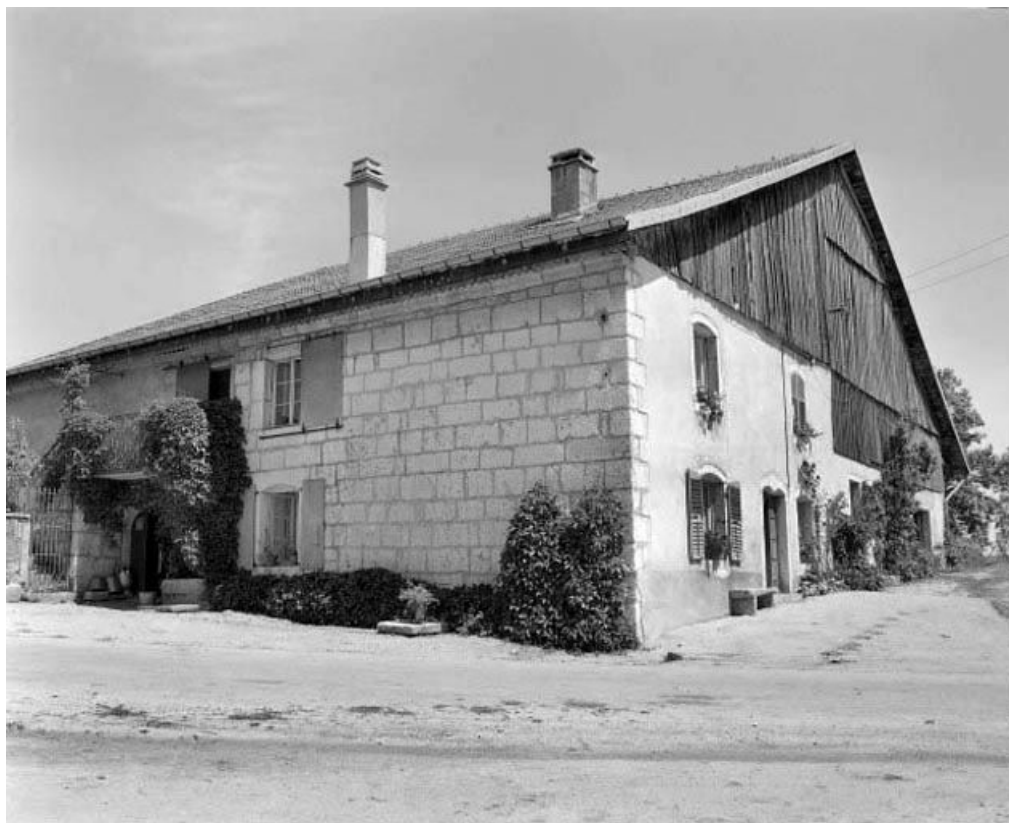
Facades antérieure et latérale gauche. 25, Arçon
