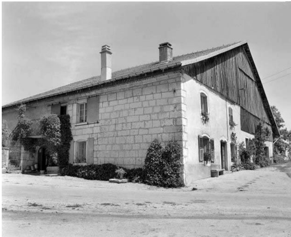
Facades antérieure et latérale gauche. 25, Arçon
