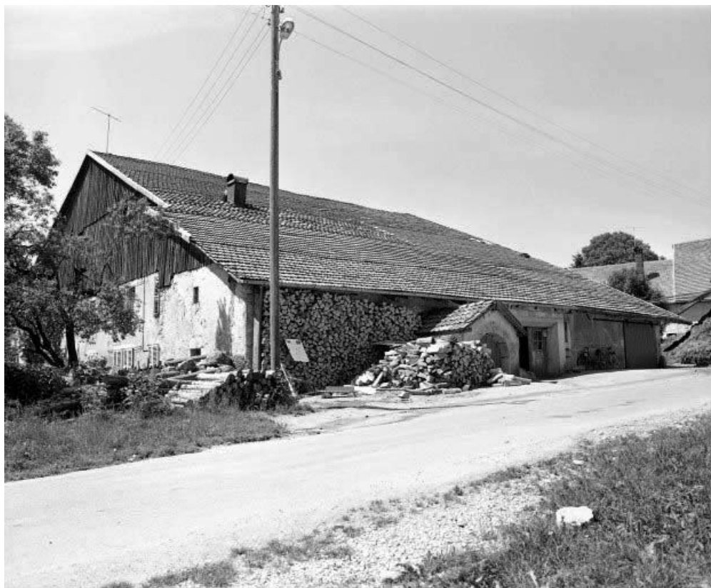
Facades antérieure et latérale droite. 25, Arçon
