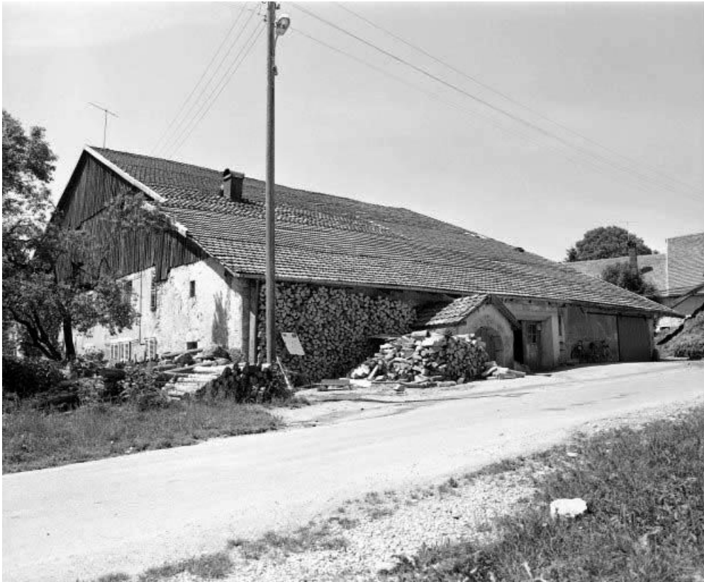
Facades antérieure et latérale droite. 25, Arçon
