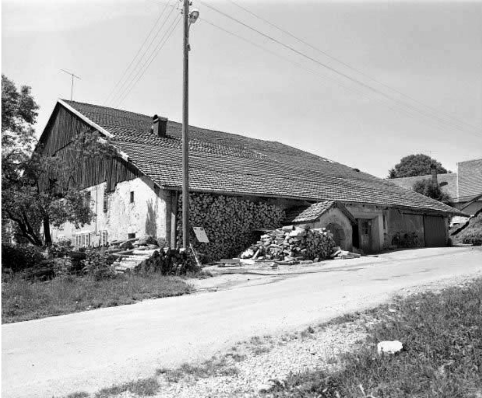
Facades antérieure et latérale droite. 25, Arçon
