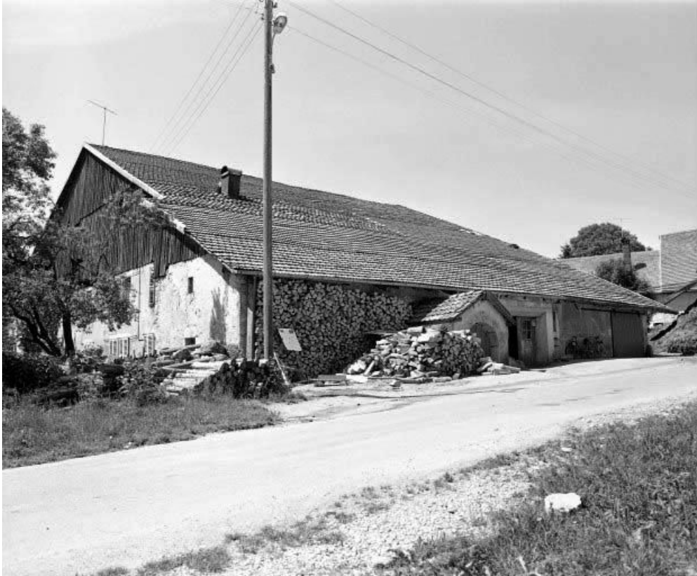
Facades antérieure et latérale droite. 25, Arçon
