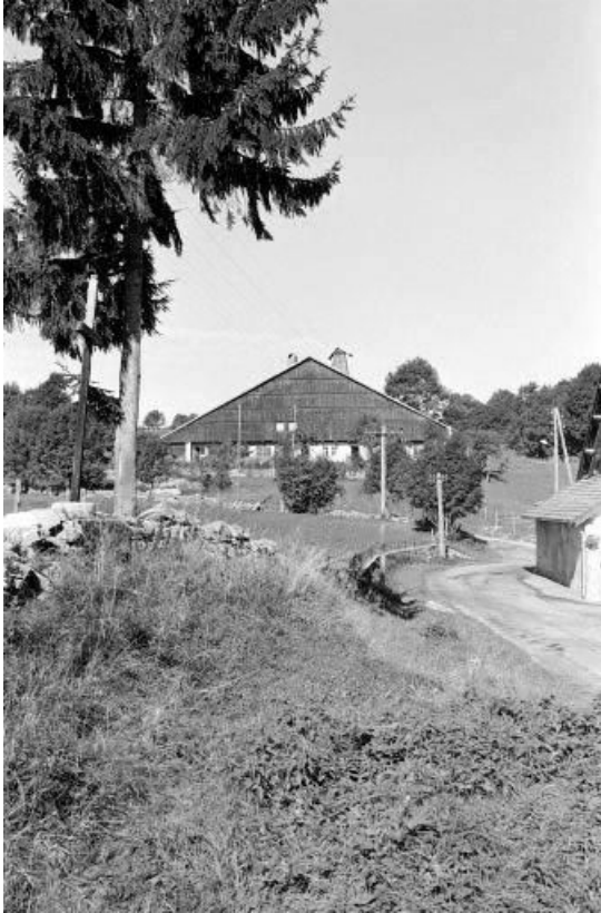
Ferme : vue générale.
