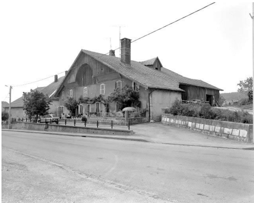
Façades antérieure et latérale droite.
