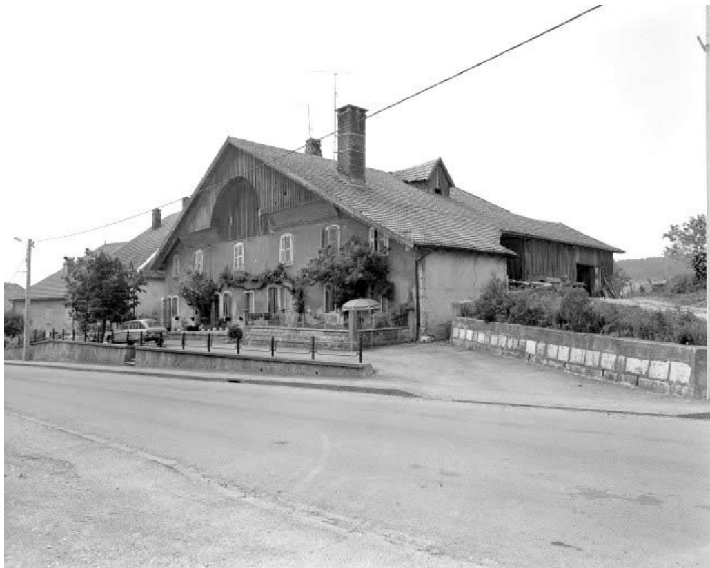
Façades antérieure et latérale droite.
