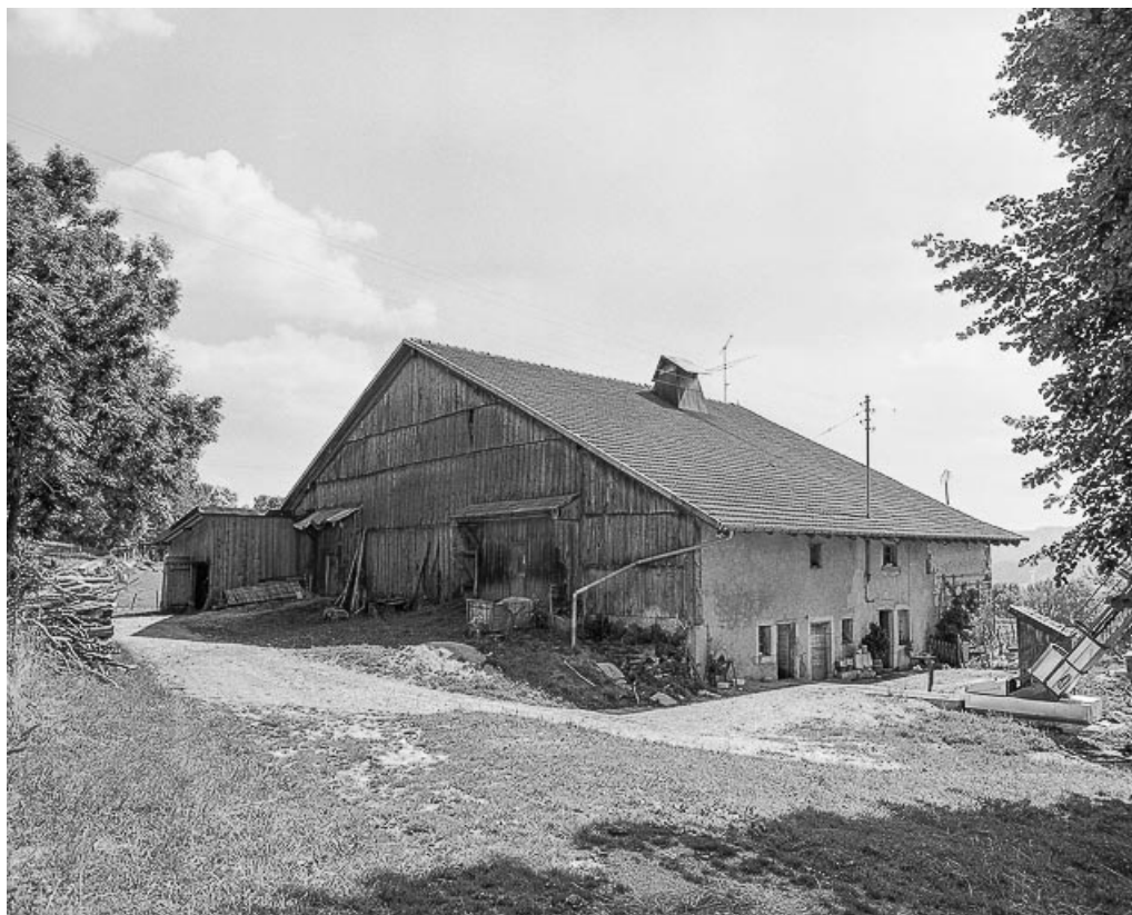
Ferme située au lieu-dit Pré Noë : façades postérieure et latérale gauche. 25, Villers-le-Lac
