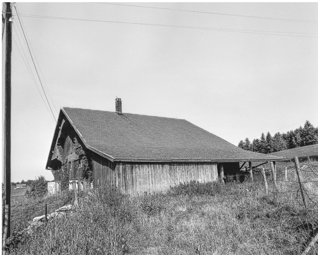
Ferme située au lieu-dit Sur la Roche : façade latérale droite. 25, Villers-le-Lac
