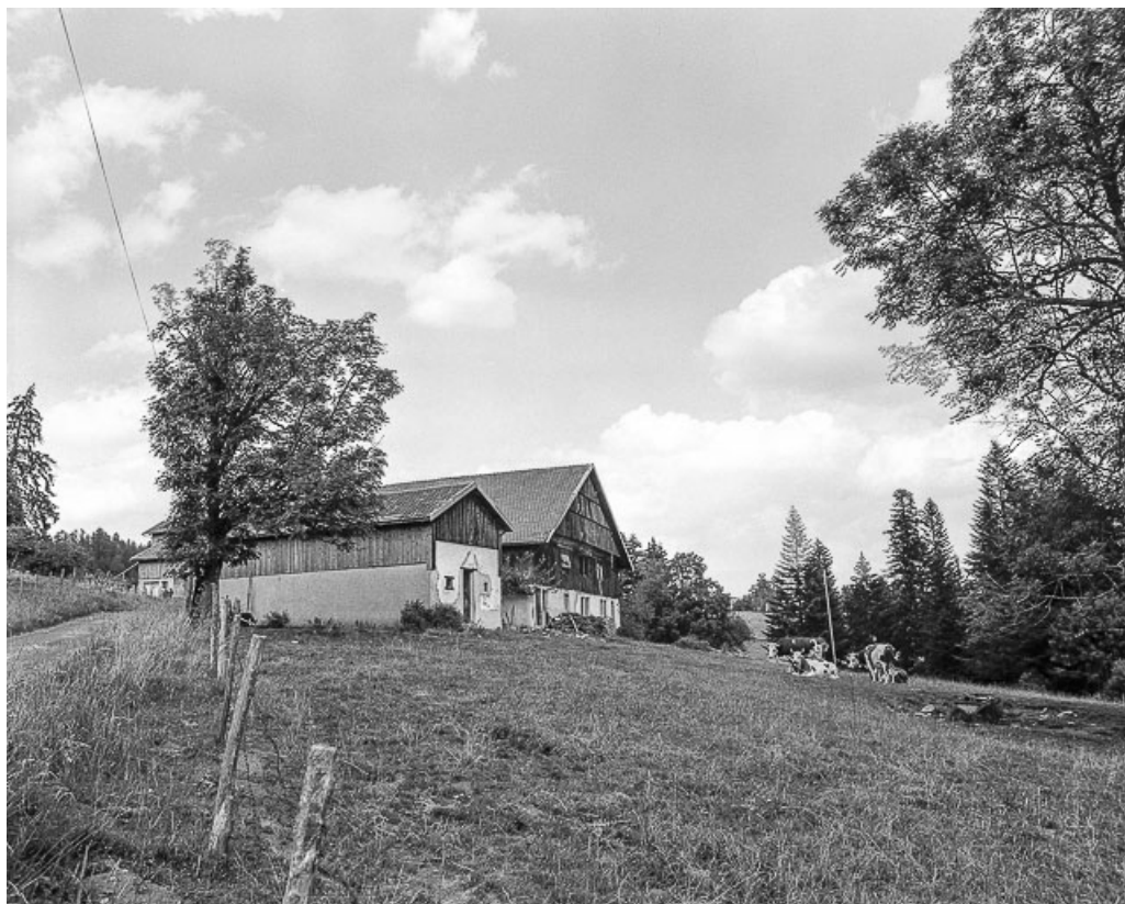
Ferme située au lieu-dit Grand Cerneux : vue d'ensemble. 25, Villers-le-Lac
