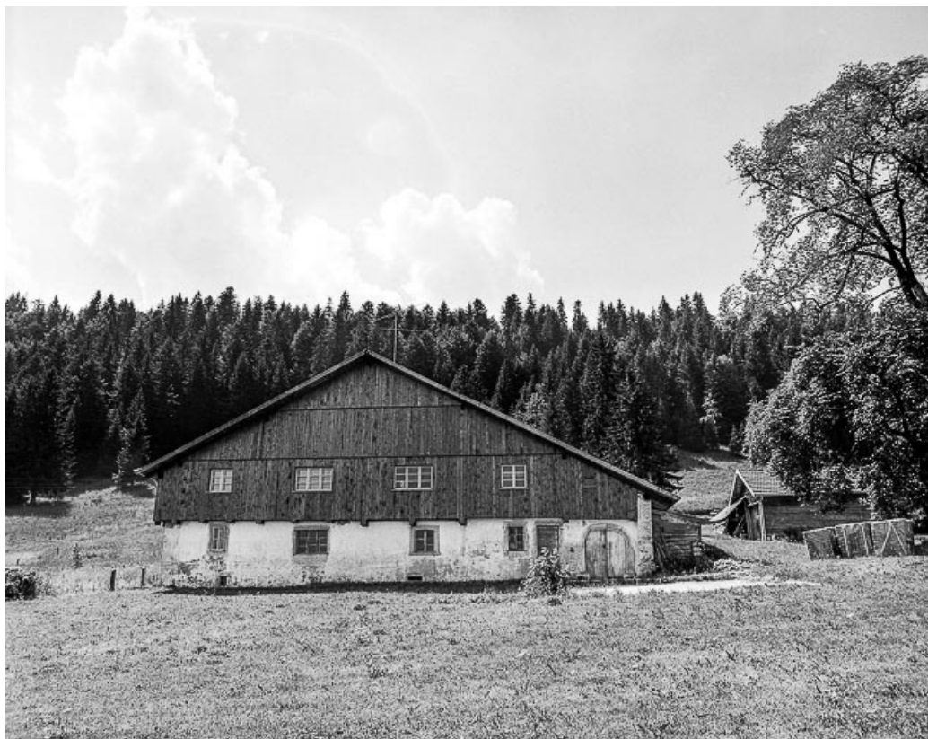
Ferme située au lieu-dit Ronde Sommette : façade antérieure. 25, Villers-le-Lac
