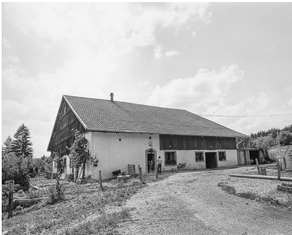
Ferme située au lieu-dit Cerneux Billard, cadastrée A2 : façade antérieure et latérale gauche. 25, Villers-le-Lac
