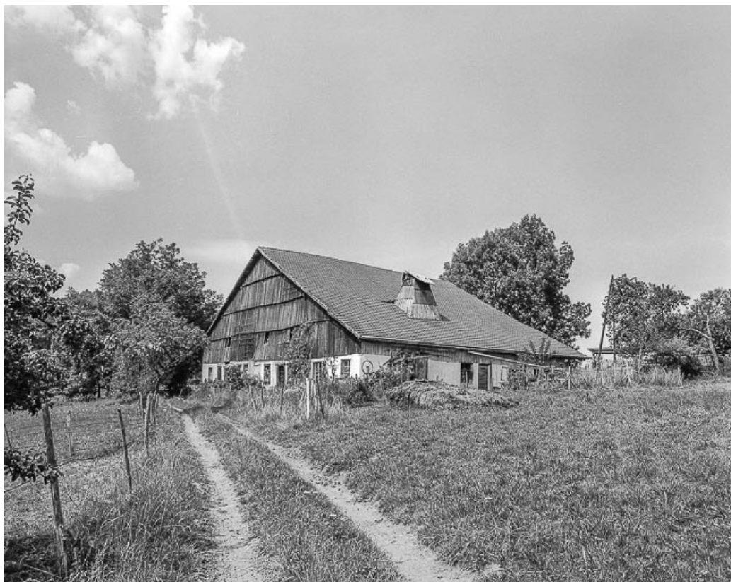
Ferme située au lieu-dit Le Prélot : façades antérieure et latérale droite. 25, Villers-le-Lac
