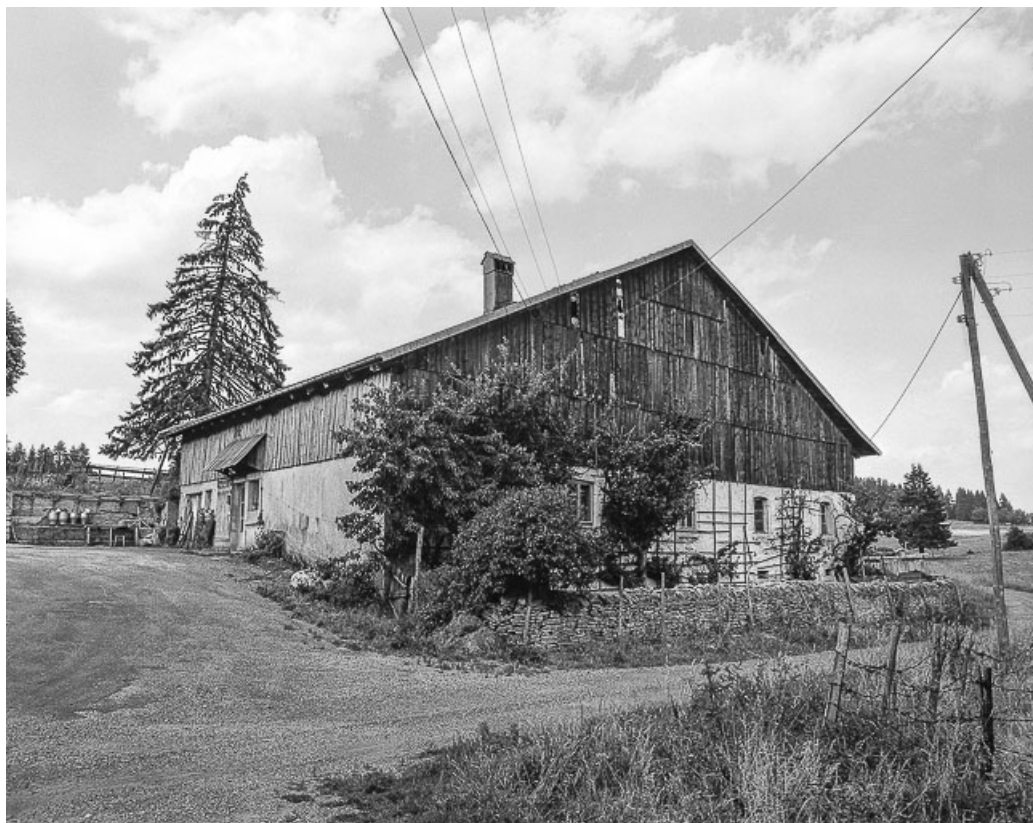
ferme située au lieu-dit Grand Cerneux : façade antérieure et latérale gauche. 25, Villers-le-Lac
