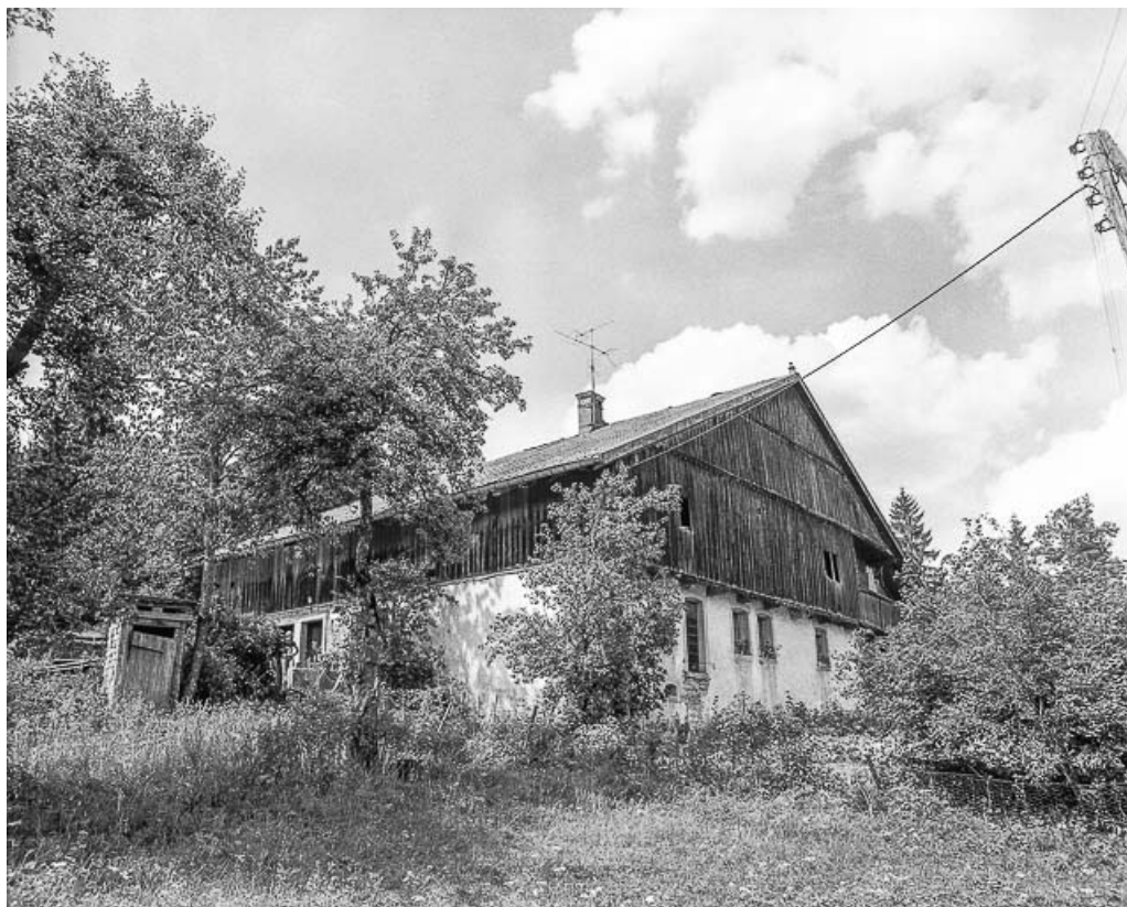
ferme située au lieu-dit Chez Prenel : Façades antérieure et latérale gauche. 25, Villers-le-Lac
