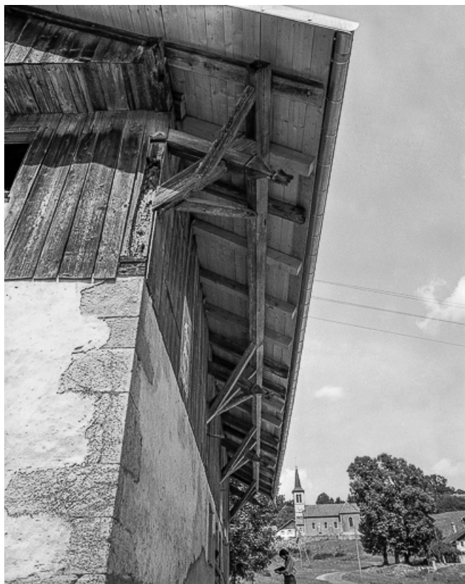
Ferme située au lieu-dit Le Pissoux : extrémité des arbalétriers. 25, Villers-le-Lac
