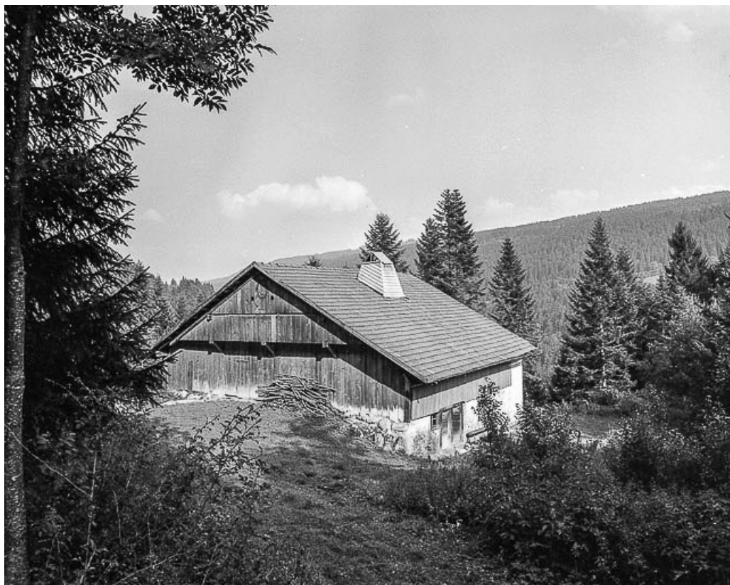
Ferme située au lieu-dit A Gourdavi : façade postérieure et latérale gauche. 25, Villers-le-Lac
