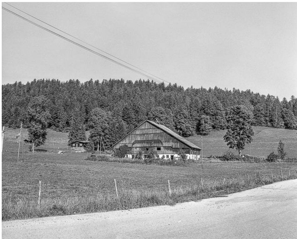
Ferme située au lieu-dit Le Chauffaud : vue d'ensemble. 25, Villers-le-Lac
