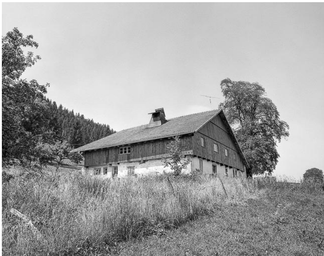
Ferme située au lieu-dit Ronde Sommette : façades antérieure et latérale gauche. 25, Villers-le-Lac
