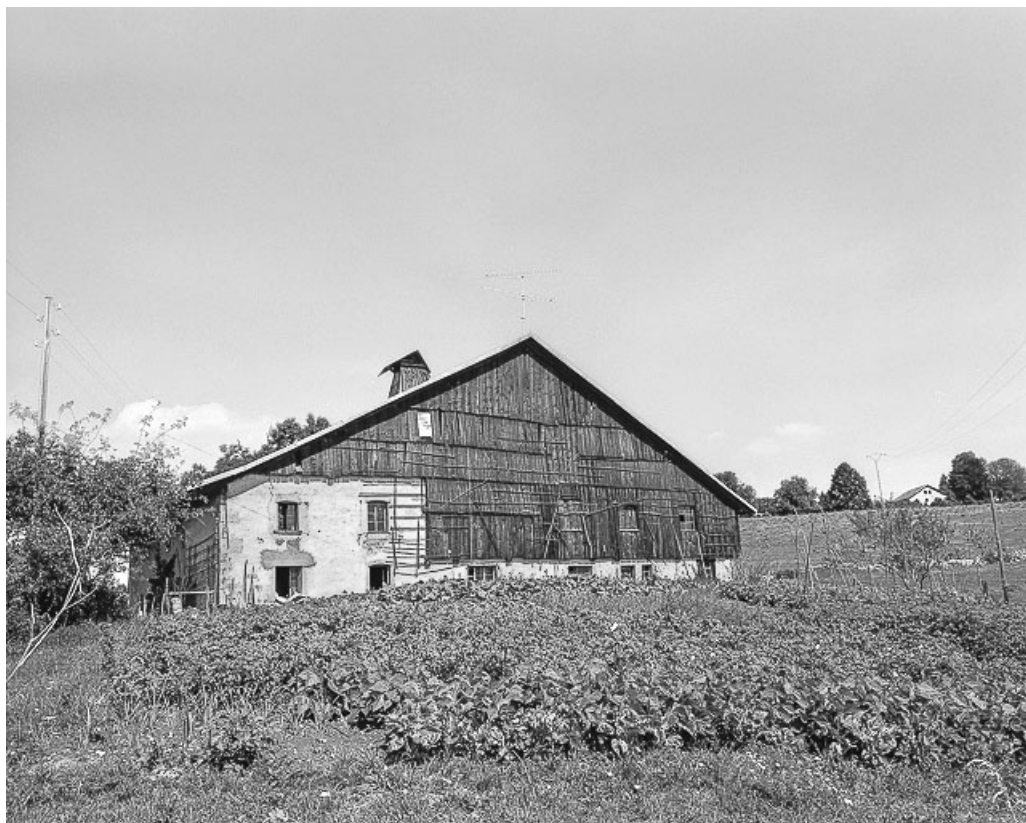
Ferme située au lieu-dit Pré Noë : façade antérieure. 25, Villers-le-Lac
