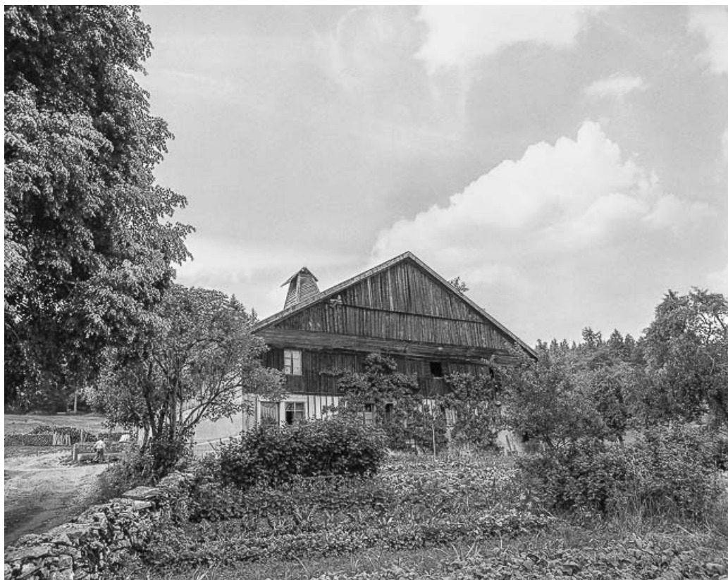
Ferme située au lieu-dit Chez Prenel : vue d'ensemble. 25, Villers-le-Lac
