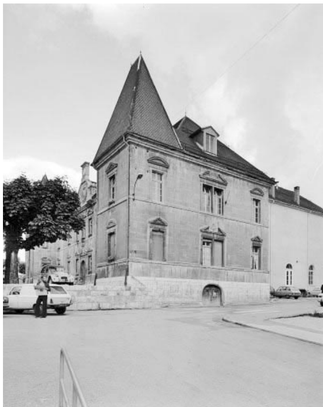
Façade latérale droite.
