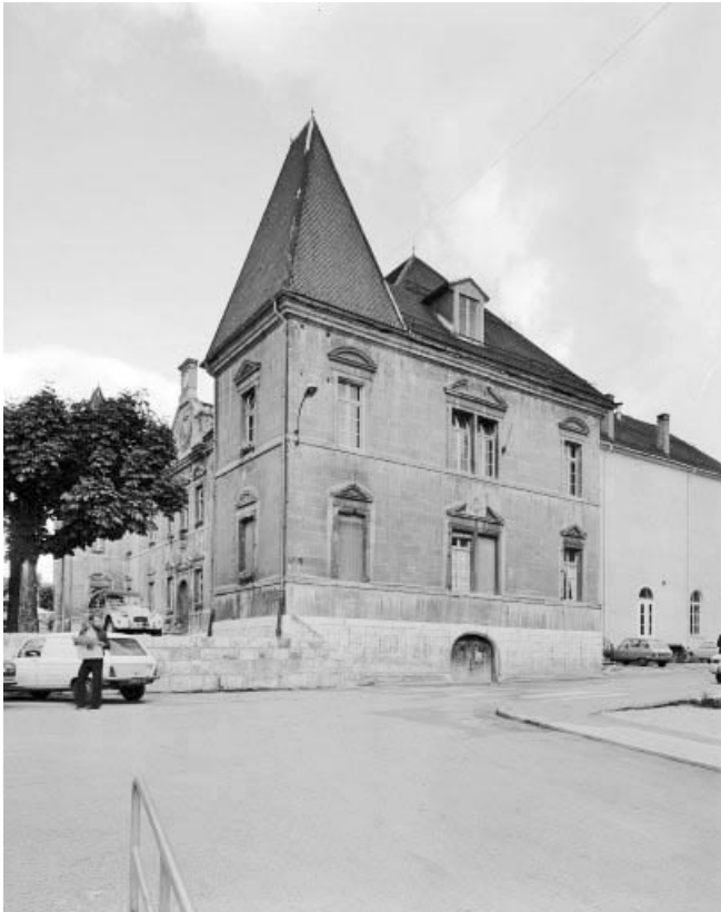
Façade latérale droite.
