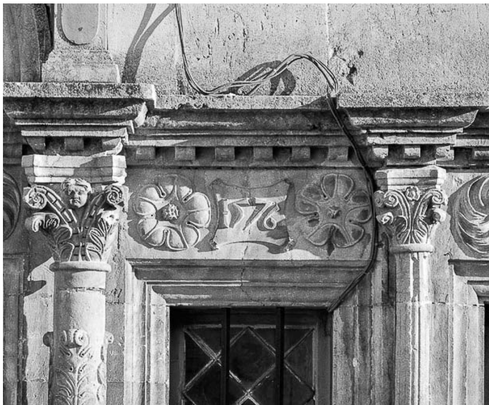
Linteau de fenêtre du rez-de-chaussée.
