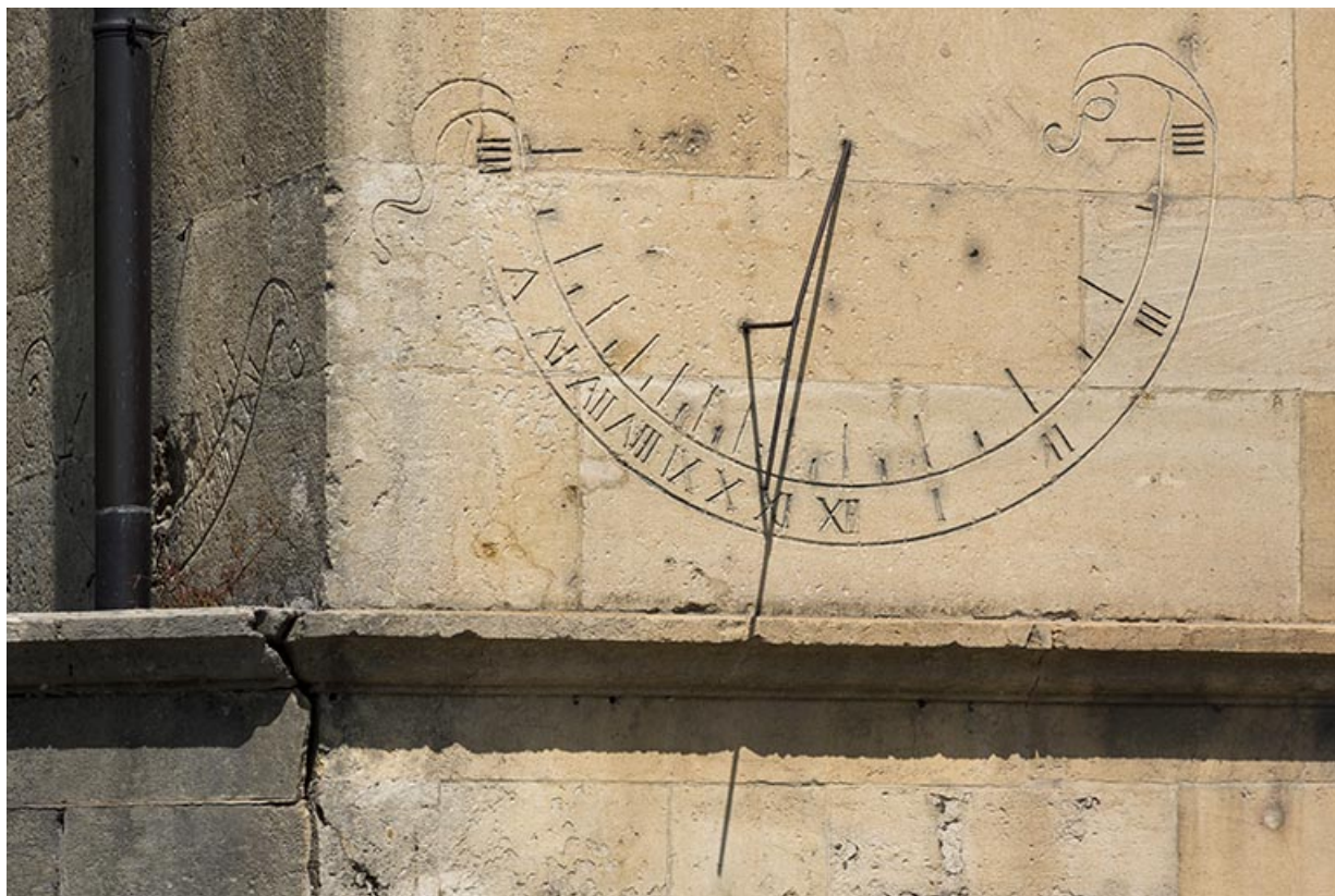
Façade sur rue : cadrans solaires.
