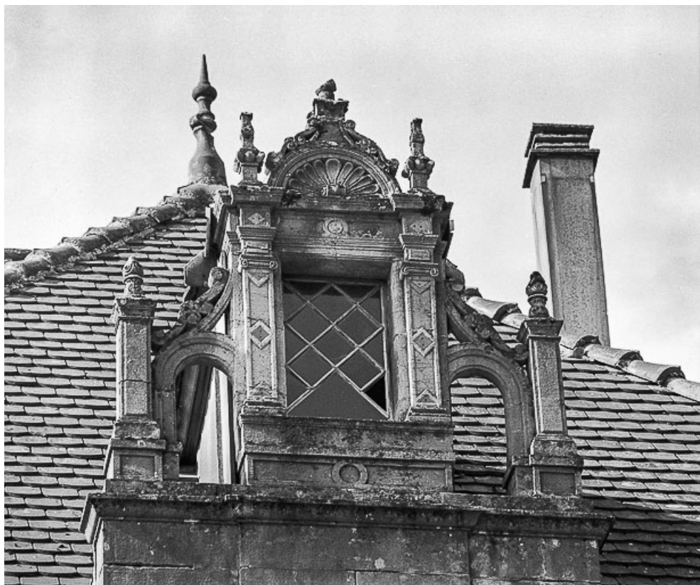
Façade latérale : lucarne.
