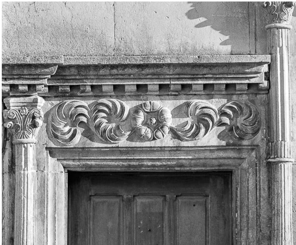
Linteau de fenêtre du rez-de-chaussée.
