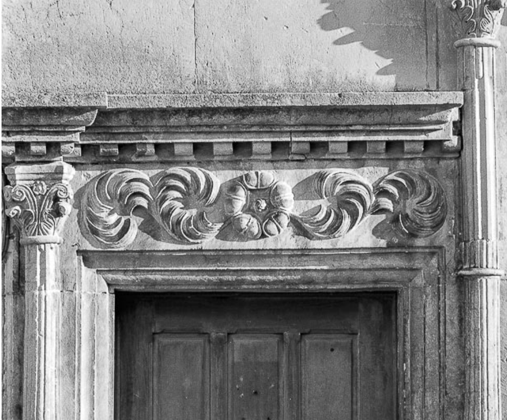
Linteau de fenêtre du rez-de-chaussée.
