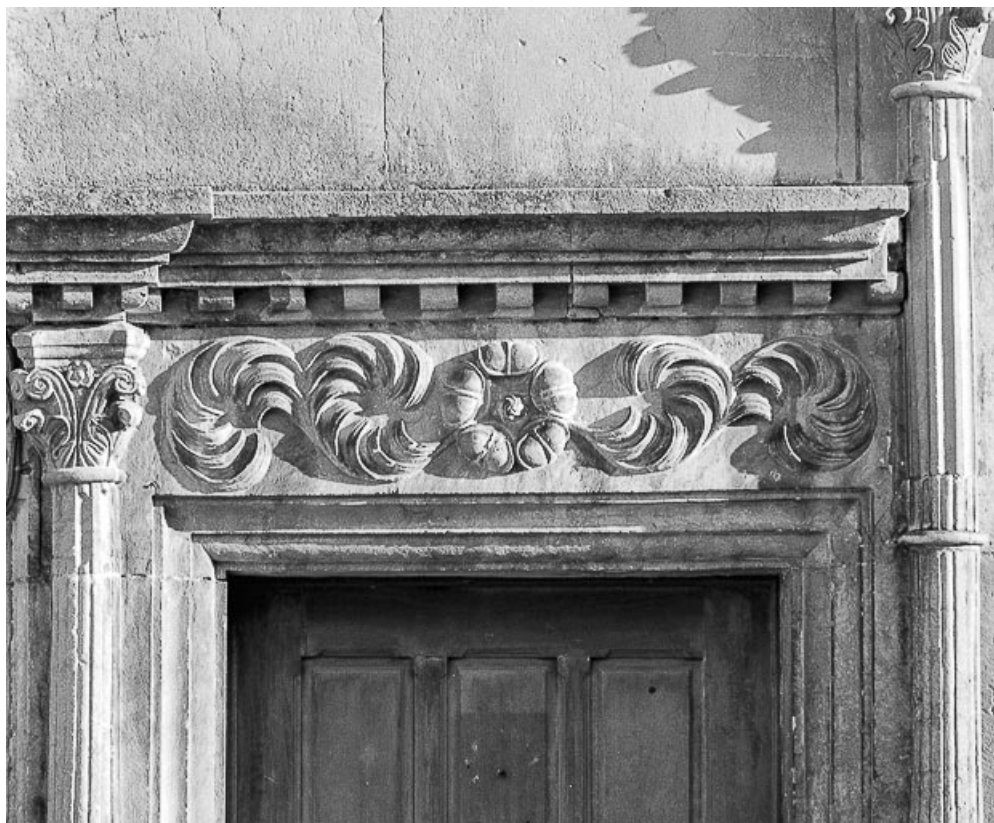
Linteau de fenêtre du rez-de-chaussée.
