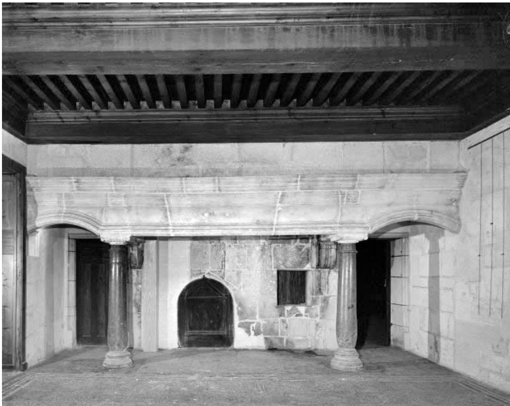
Intérieur : cheminée à manteau, le couvrement repose sur deux colonnes.
