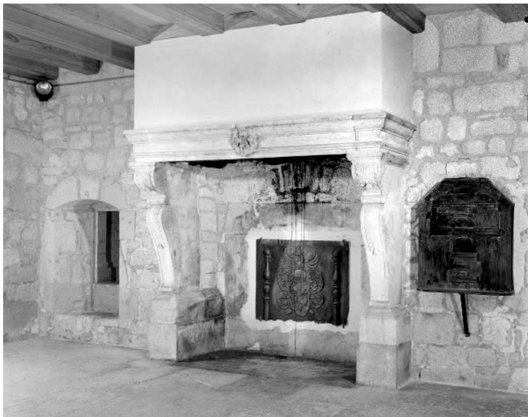
Intérieur : cheminée à manteau, le couverture repose sur deux piedroits.
