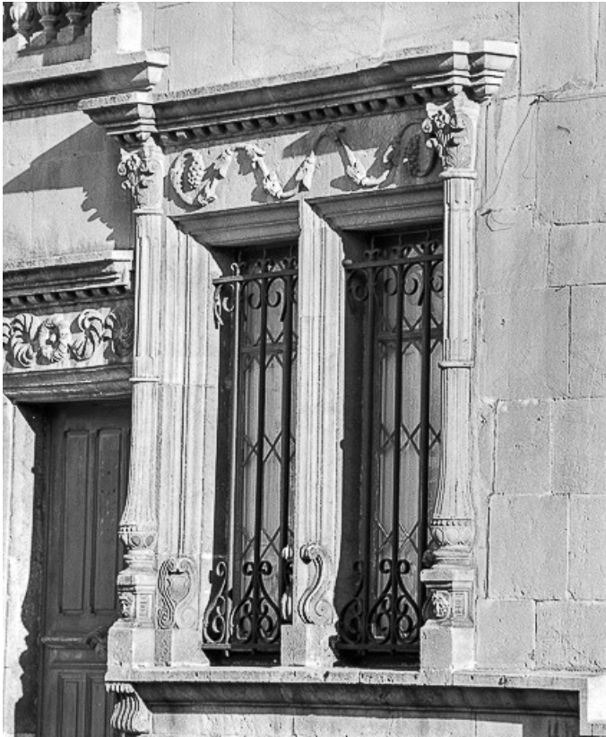
Façade sur cour. Détail : fenêtre du rez-de-chaussée.
