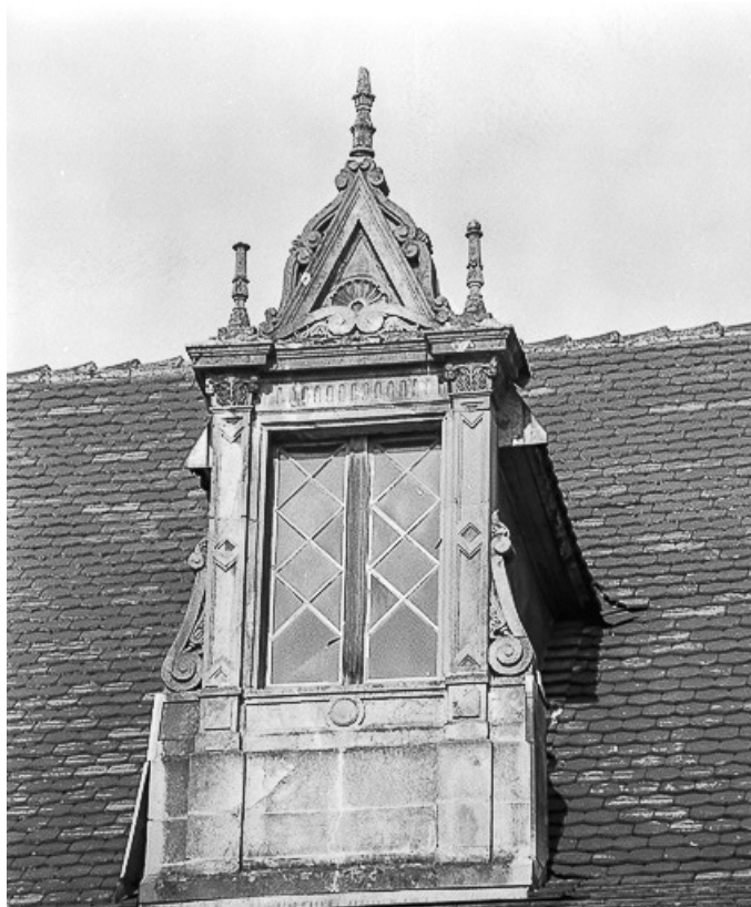
Façade sur rue. Détail : lucarne.
