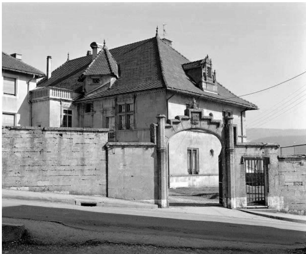
Portail d'entrée et façade sur cour.
