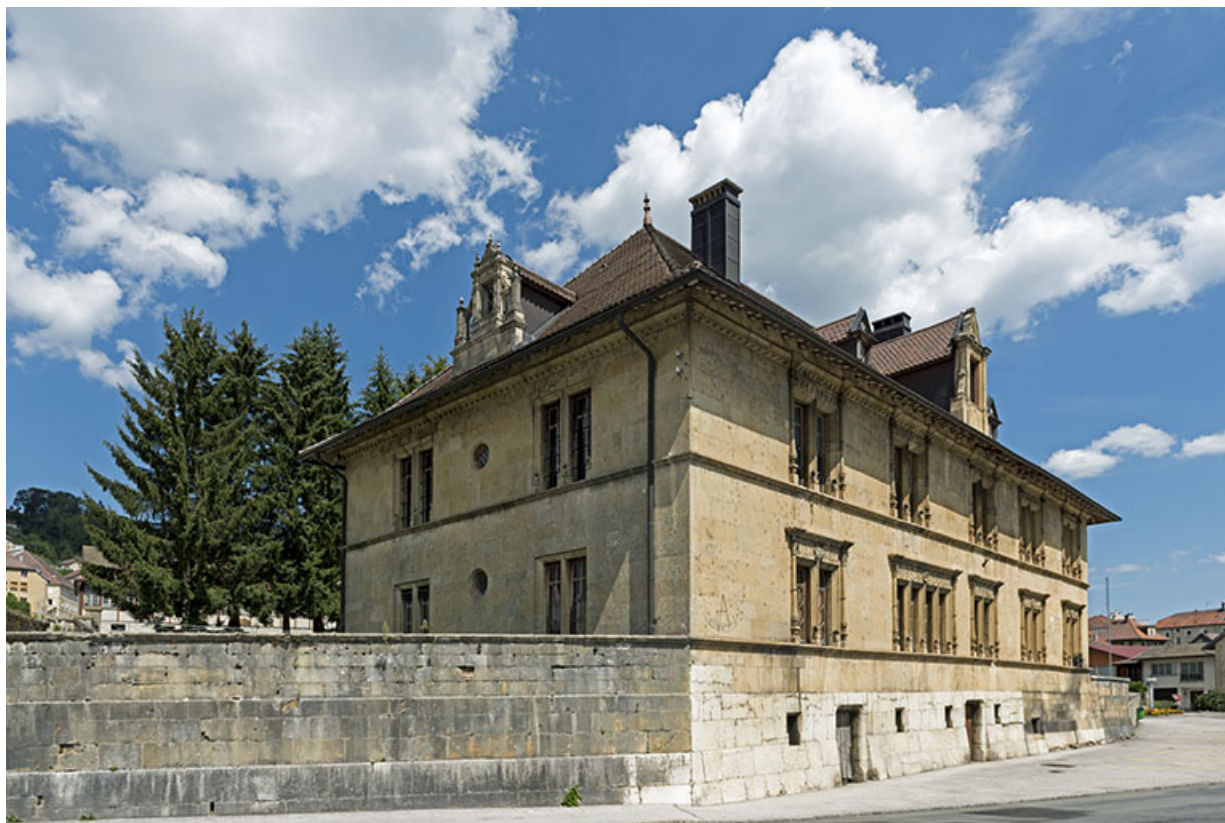
Vue d'ensemble depuis la rue, au sud.
