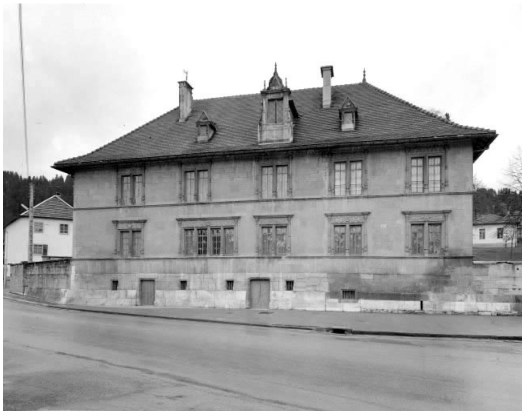
Façade sur rue : vue d'ensemble.
