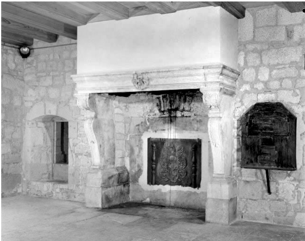
Intérieur : cheminée à manteau, le couvrement repose sur deux piedroits.
