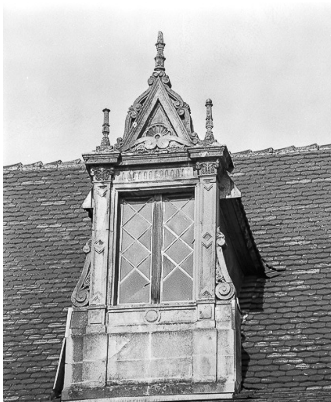
Façade sur rue. Détail : lucarne.
