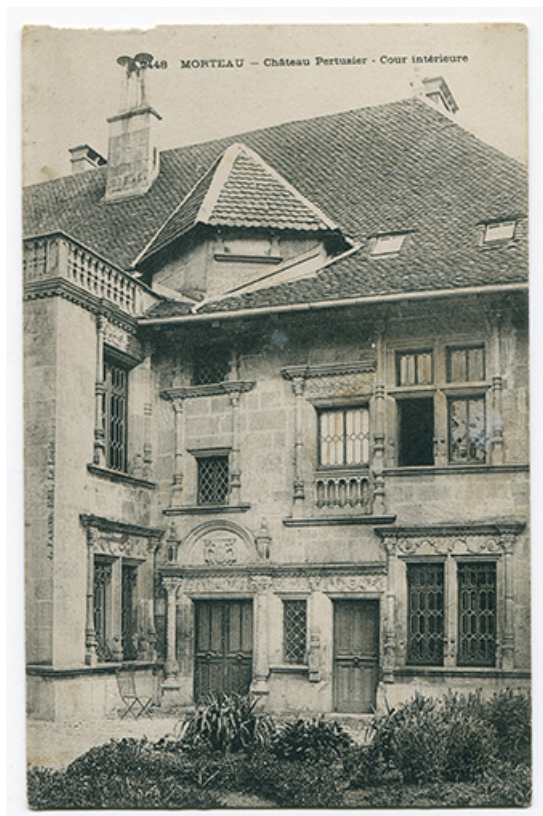
2448 Morteau - Château Pertusier - Cour intérieure, 4e quart 19e siècle. 25, Morteau, 17 rue de la Glapigney
