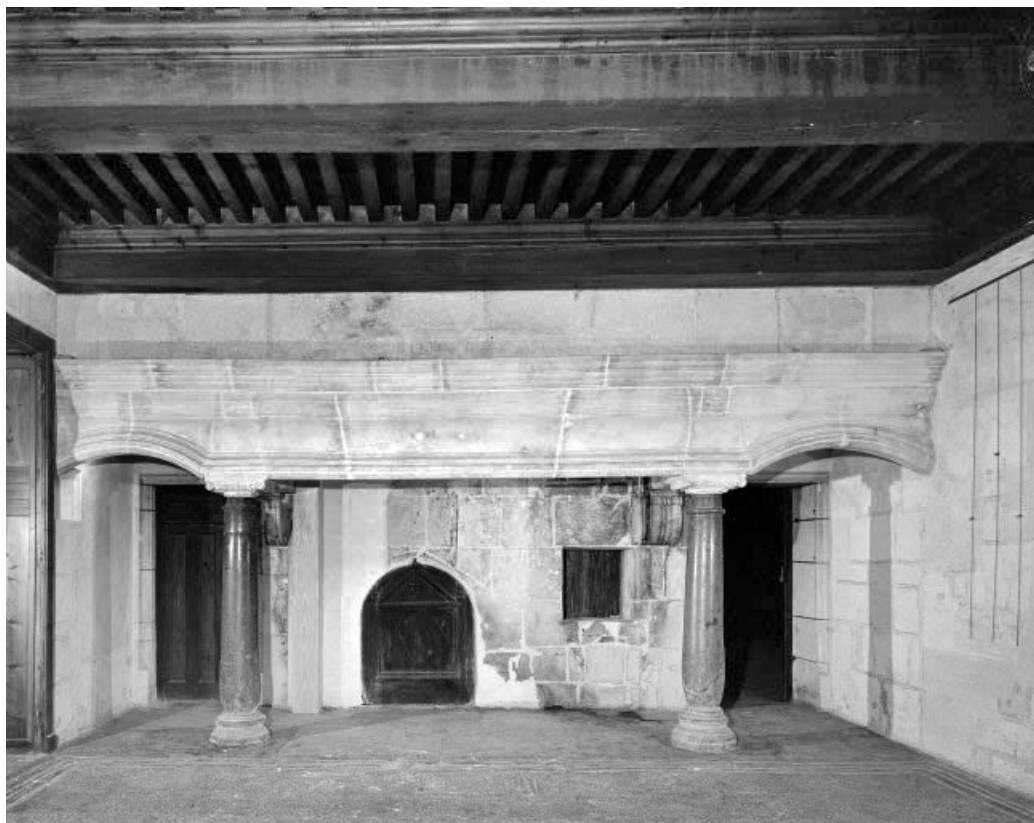
Intérieur : cheminée à manteau, le couverture repose sur deux colonnes.
