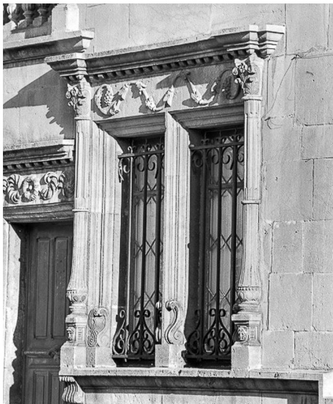
Façade sur cour. Détail : fenêtre du rez-de-chaussée.
