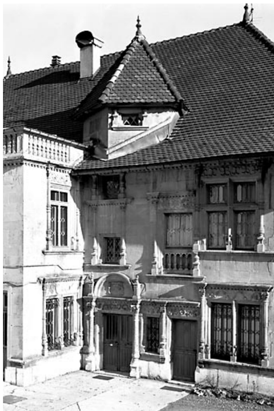
Façade sur cour.
