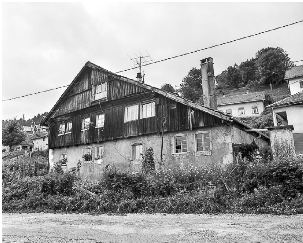
Ferme rue Sainte-Marie : façade postérieure 25, Morteau
