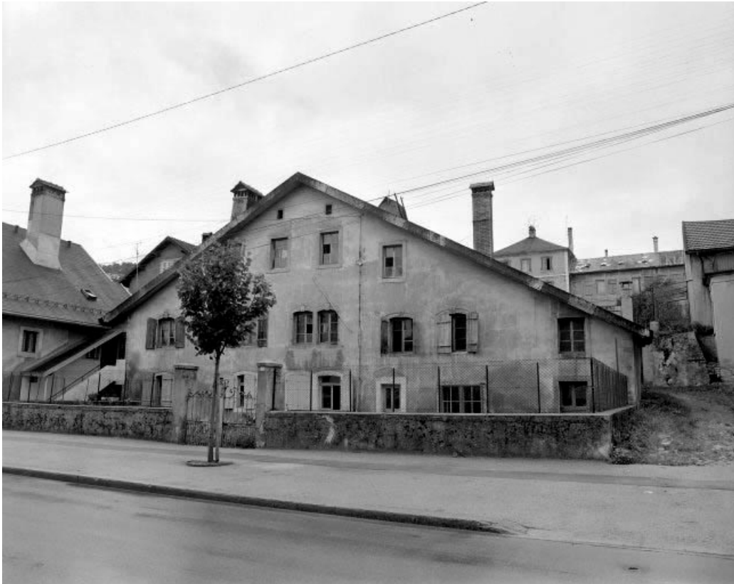
Ferme : façade antérieure.
