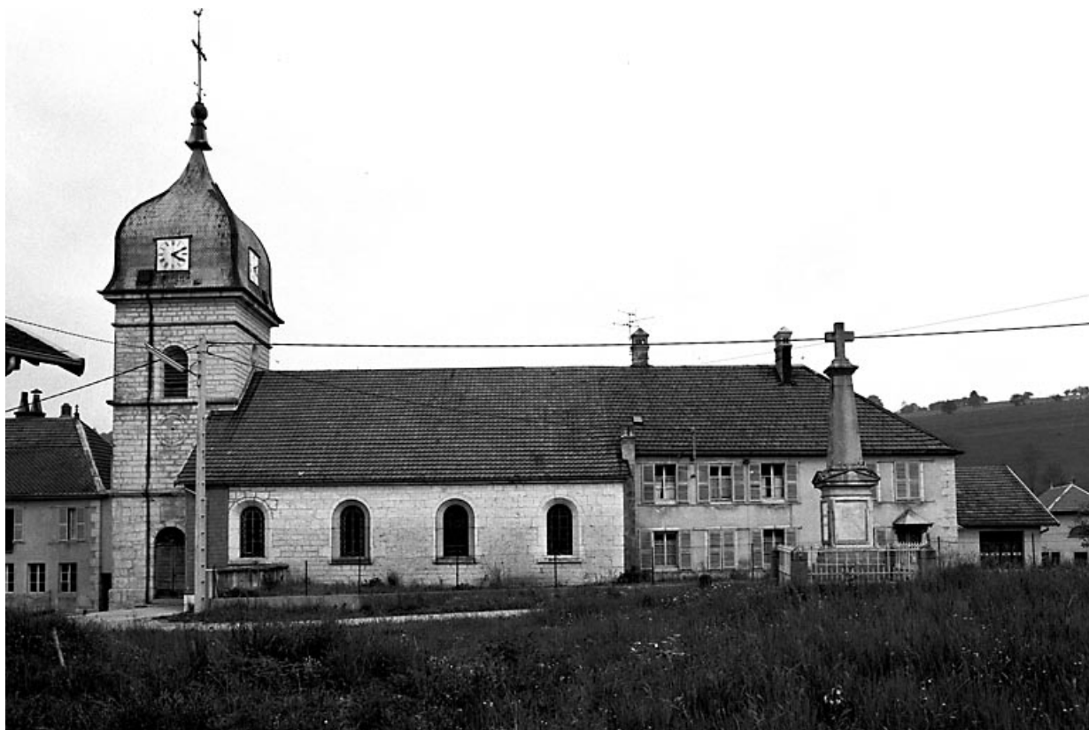
Façade latérale droite.
