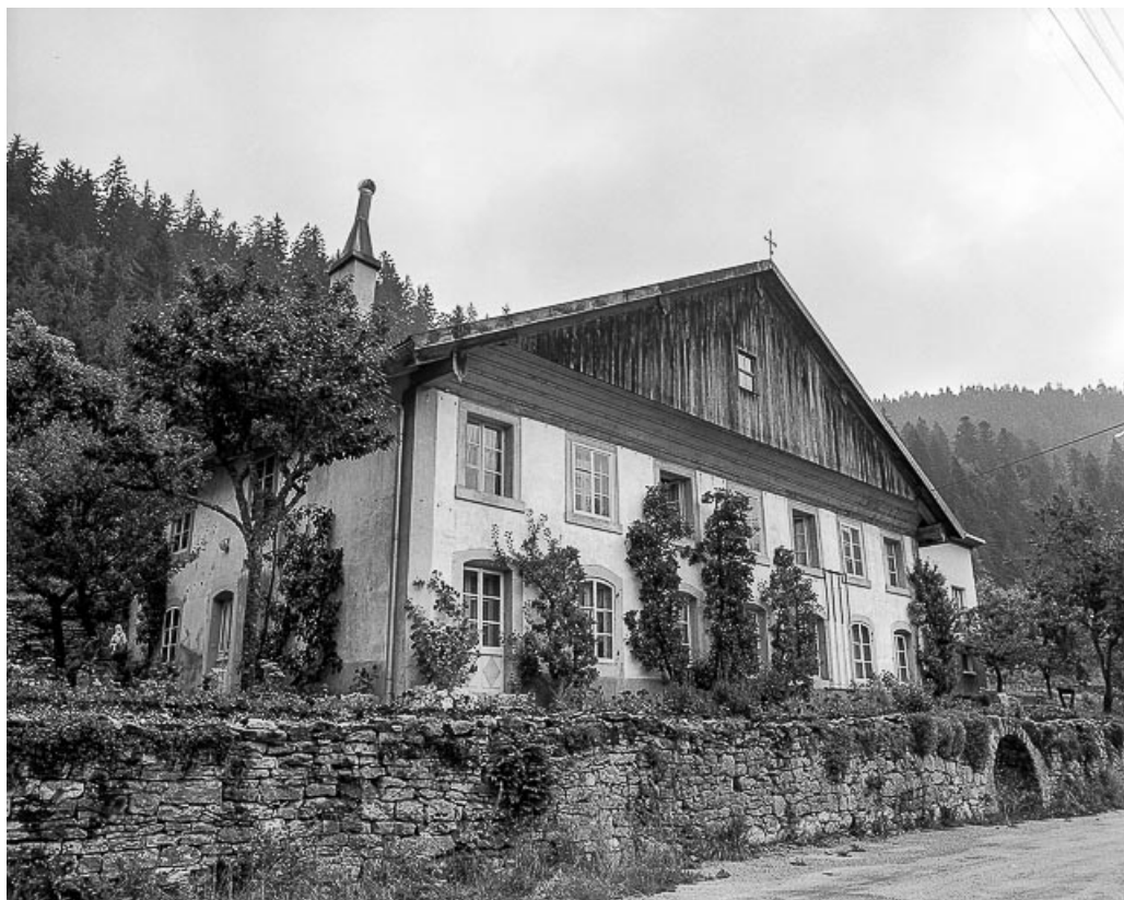
Montlebon, lieu-dit Derrière le Mont : vue d'ensemble.
