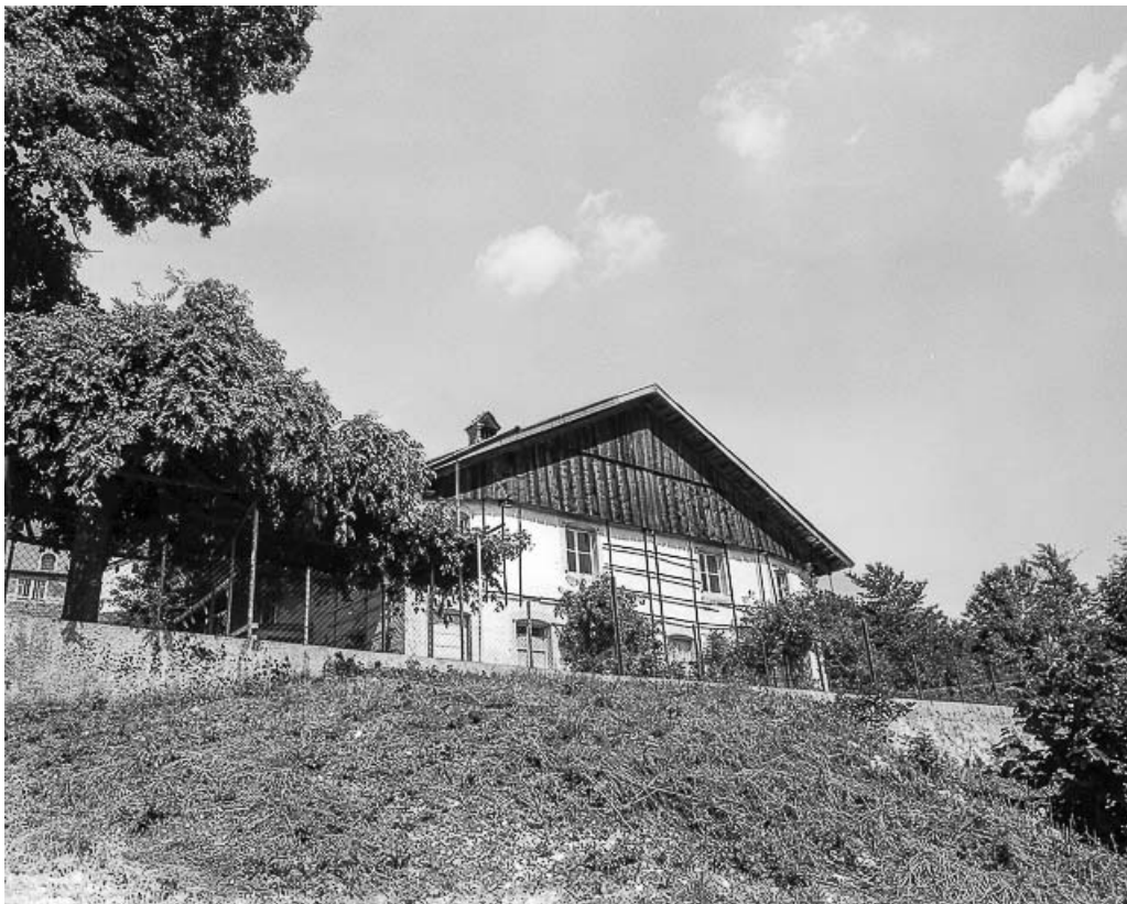
Villers-le-Lac, lieu-dit Le Pissoux : vue d'ensemble.
