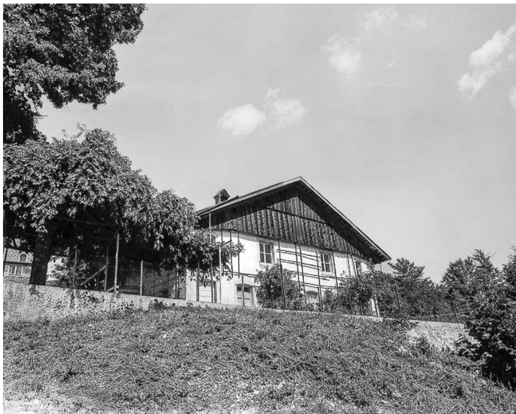
Villers-le-Lac, lieu-dit Le Pissoux : vue d'ensemble.
