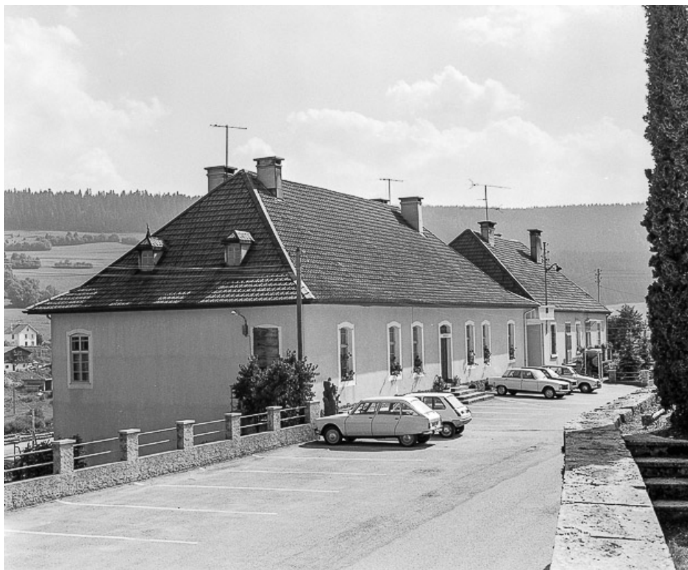
Grand'Combe-Châteleu : vue d'ensemble du presbytère.
