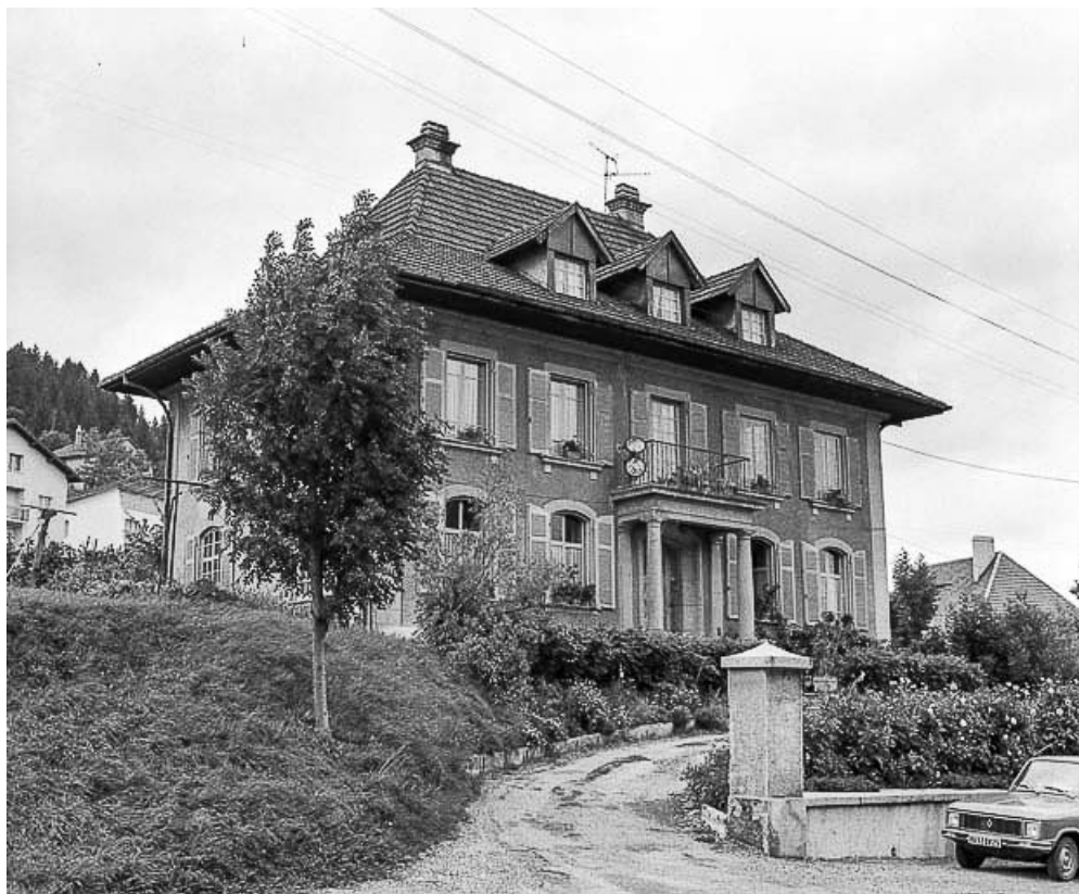
Morteau, rue de l'Eglise : vue d'ensemble.
