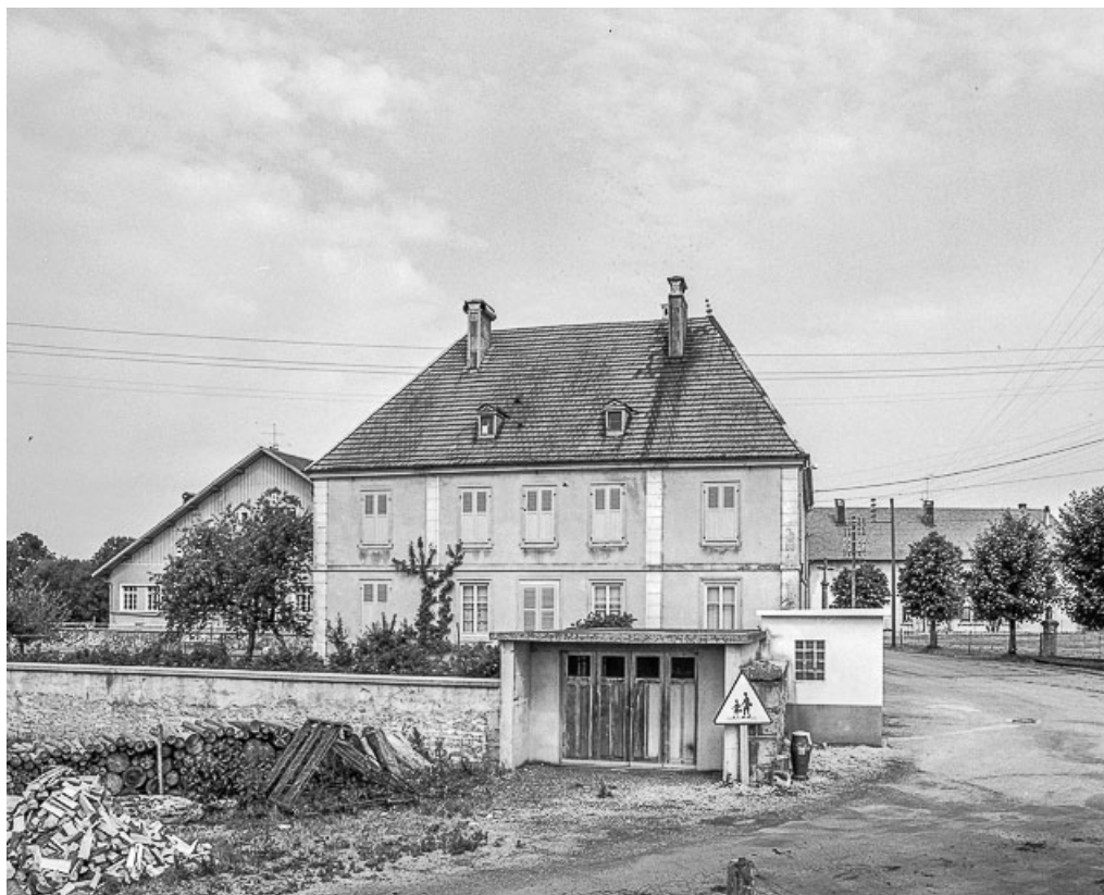
Les Combes, lieu-dit La Motte : vue d'ensemble du presbytère.
