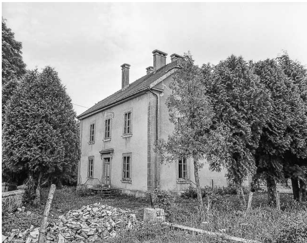
Montlebon, lieu-dit Les Fontenottes : vue d'ensemble.
