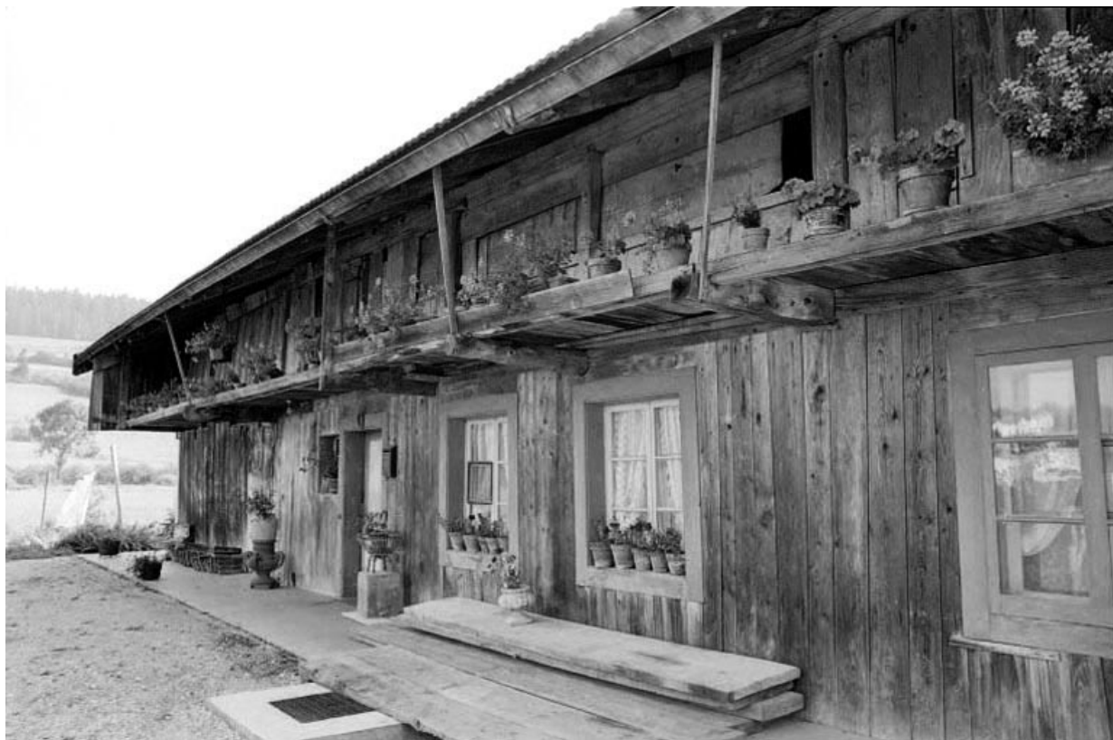
Ferme 5 : façade latérale.
