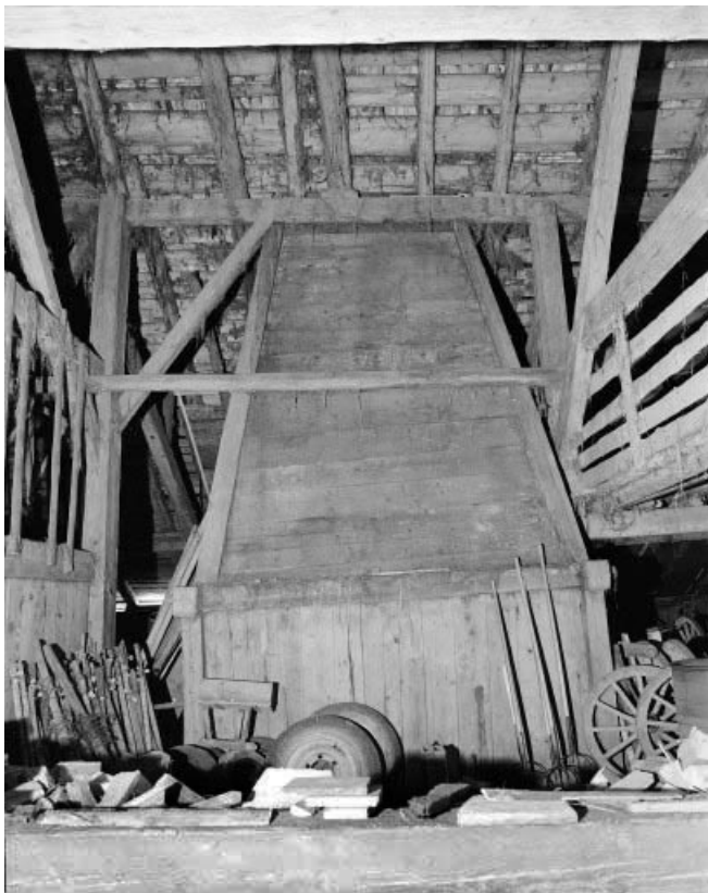
Intérieur : le petit "tué" vu depuis la grange.
