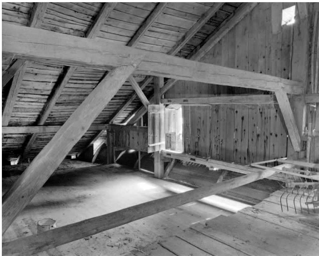
Charpente et lambreques antérieure à surplomb cintré.
