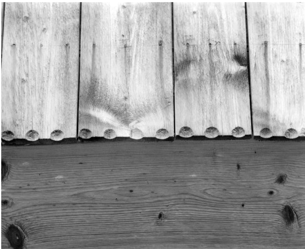
Détail : extrémité inférieure des planches de la lambrechure de la façade.
