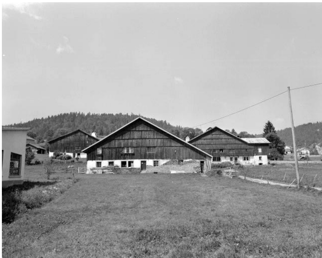
Les Cordiers, fermes 7-8-9 : vue depuis le Sud Est.
