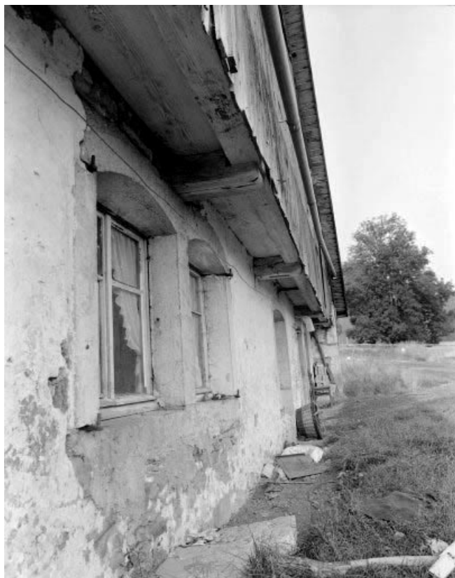
Extérieur : façade antérieure, détail : surplomb de la lambrechure.
