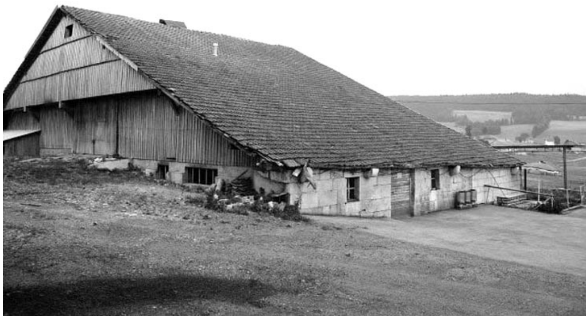
Facades postérieure et latérale gauche.
