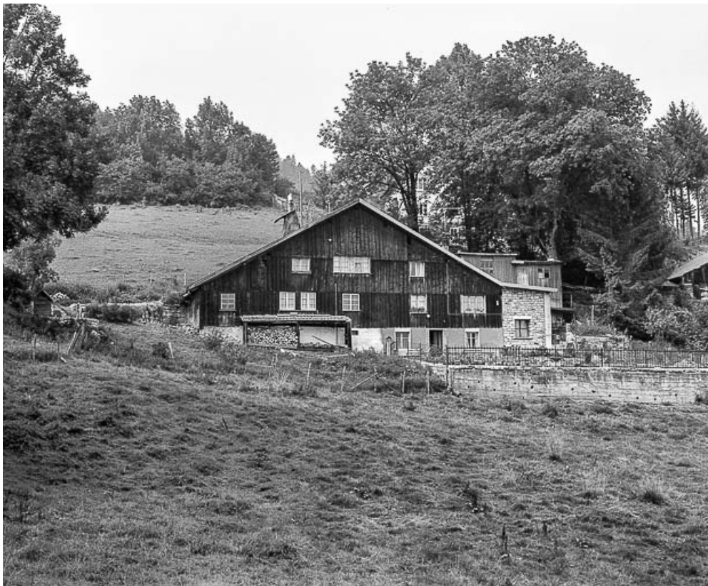
Grand'Combe Châteleur : façade antérieure.
