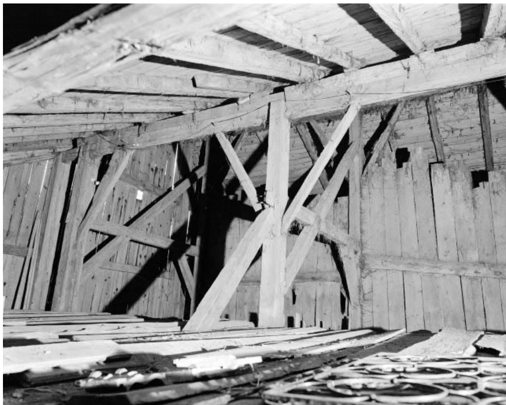
Intérieur : combles, fermes de charpente postérieures.
