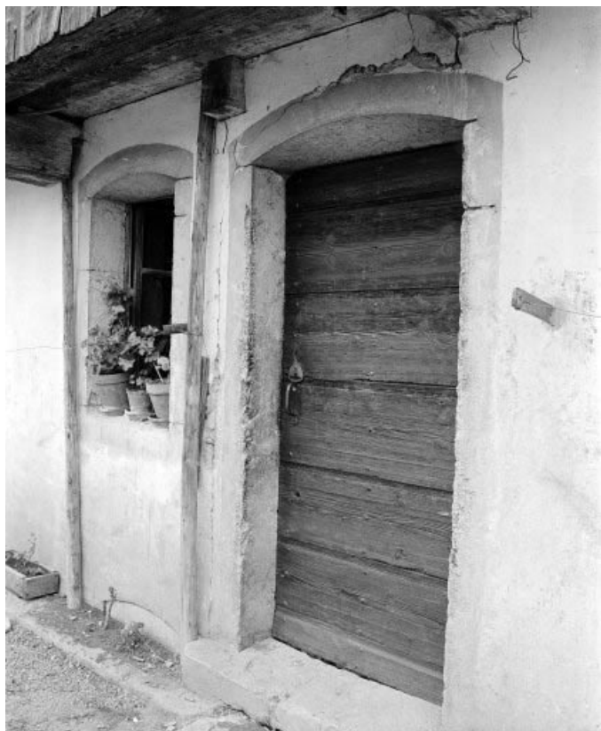
1ère ferme : : porte d'entrée
