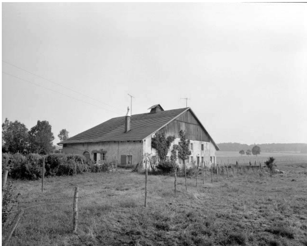
Façades antérieure et latérale gauche.
