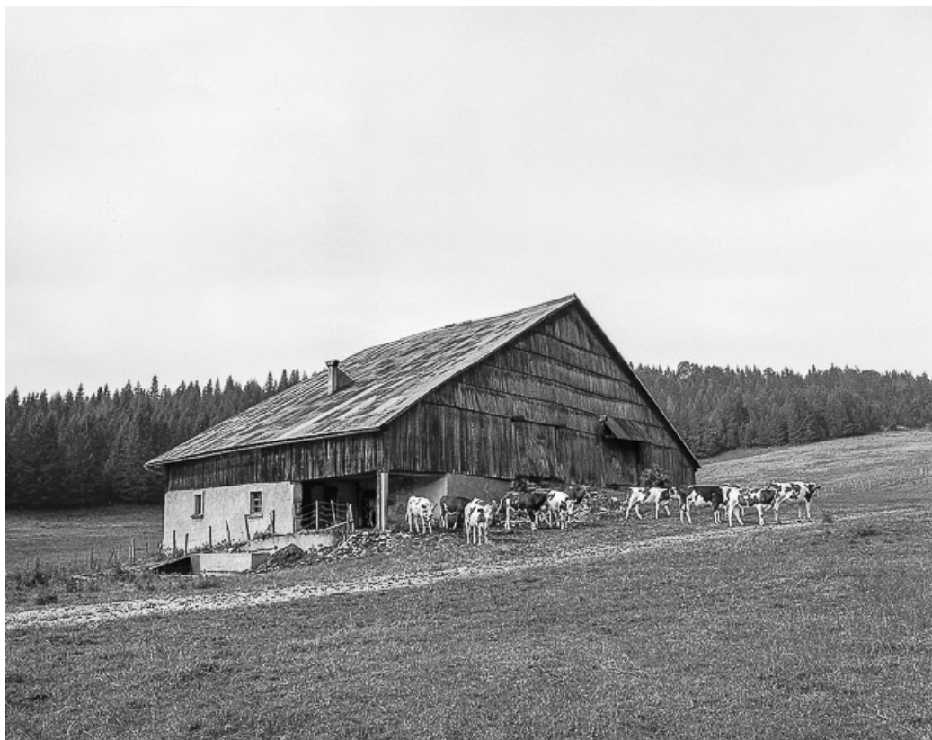
Ferme située au lieu-dit Les Charmottes : façade postérieure. 25, Montlebon
