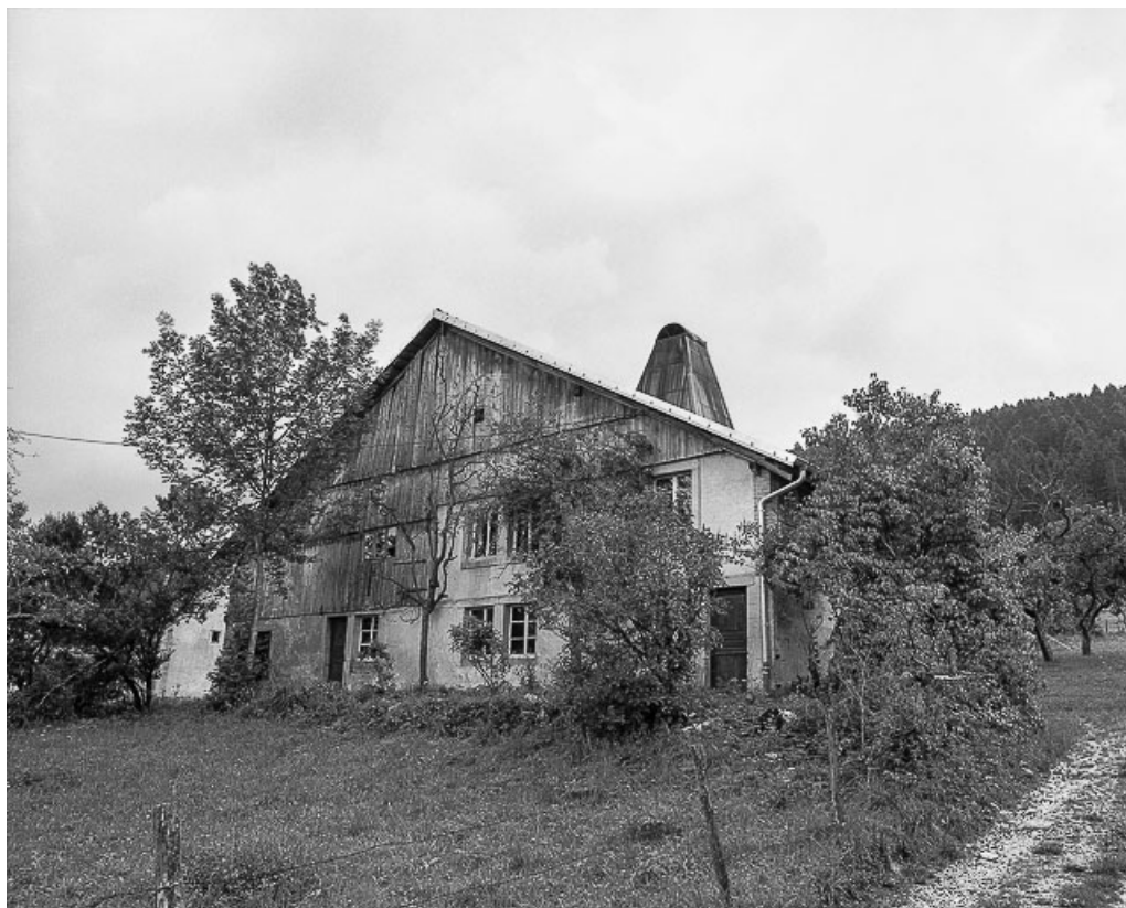
Façade antérieure. 25, Montlebon
