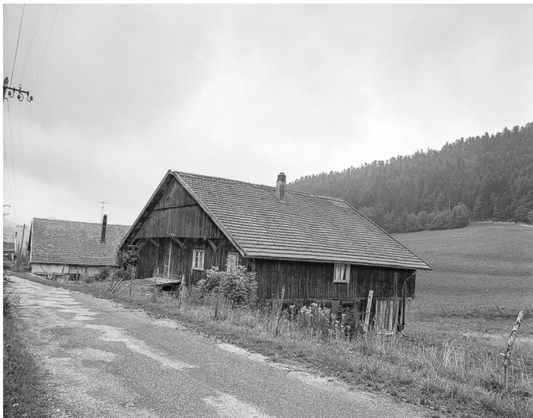
Façade antérieure. 25, Montlebon
