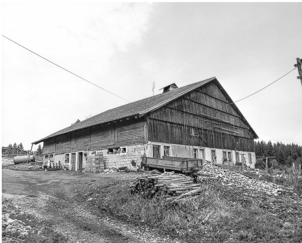
Façades antérieure et latérale. 25, Montlebon
