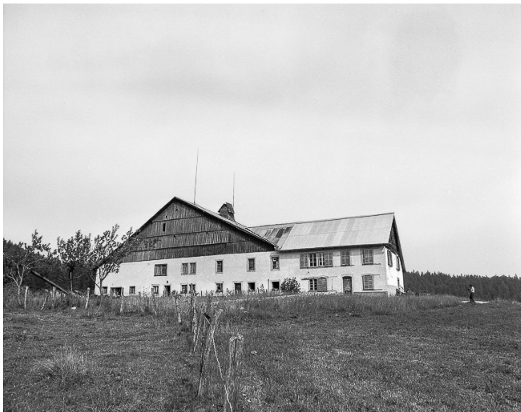
Ferme située au lieu-dit Les Charmottes : façade antérieure. 25, Montlebon
