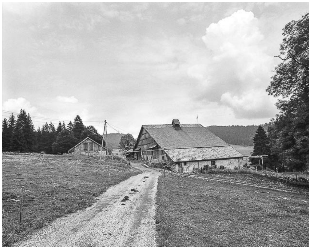
Façades postérieure et latérale. 25, Montlebon
