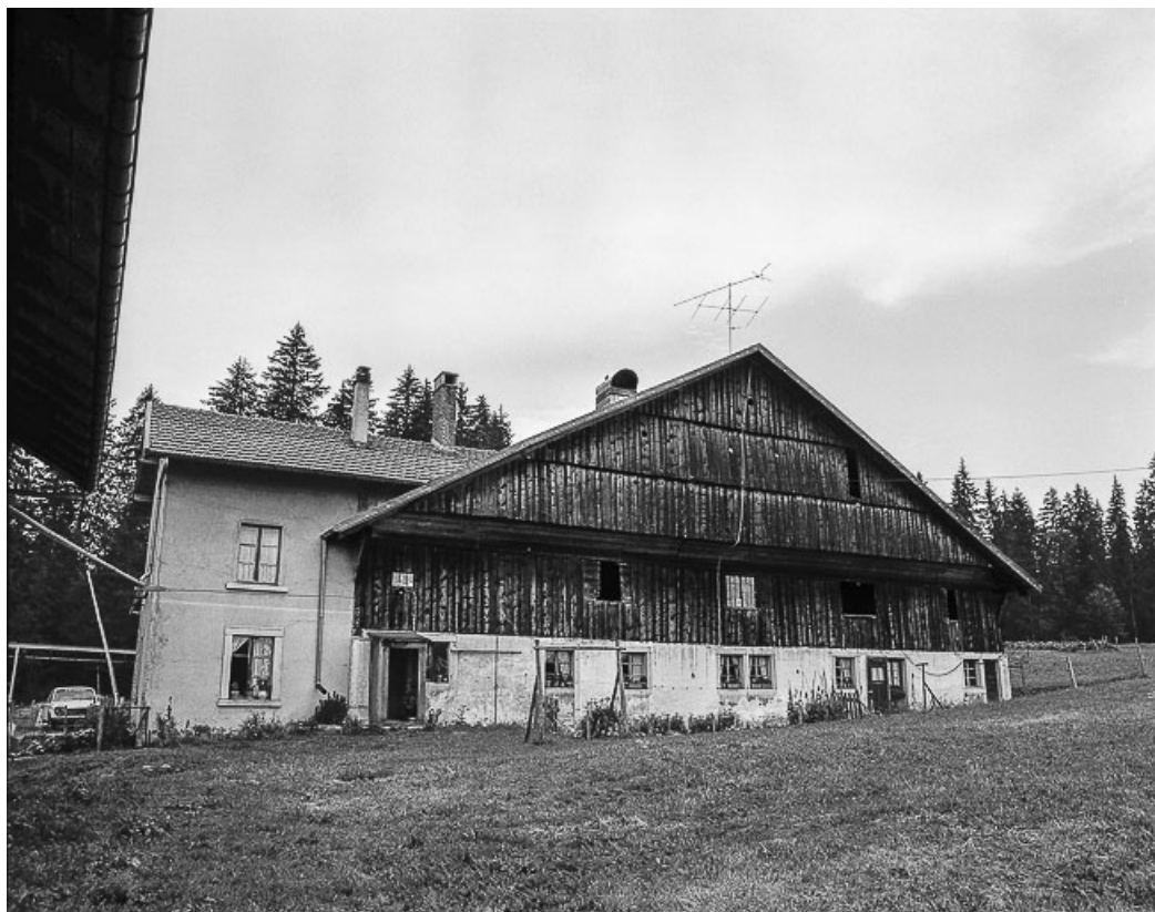
Façade antérieure. 25, Montlebon
