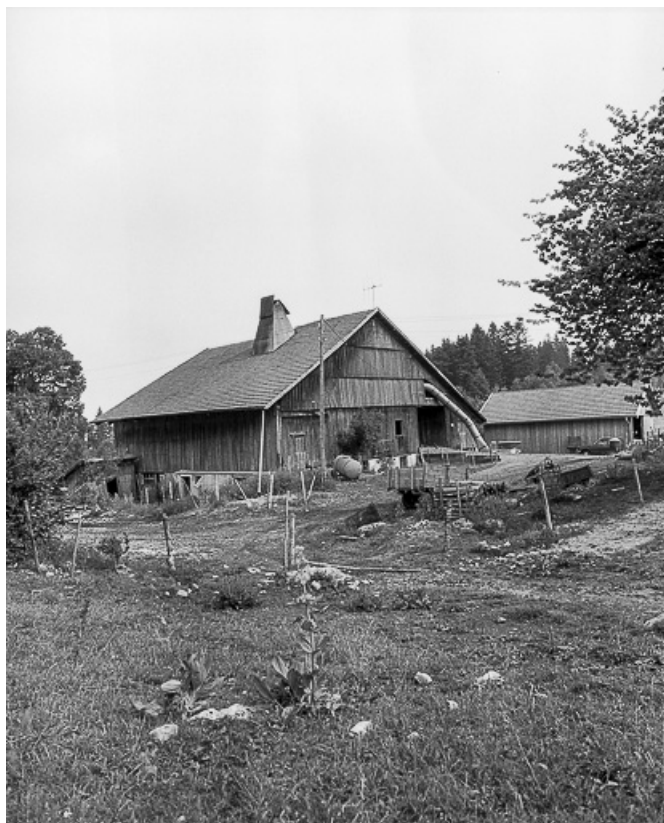
Ferme située au lieu-dit La Couleusse : vue d'ensemble 25, Montlebon
