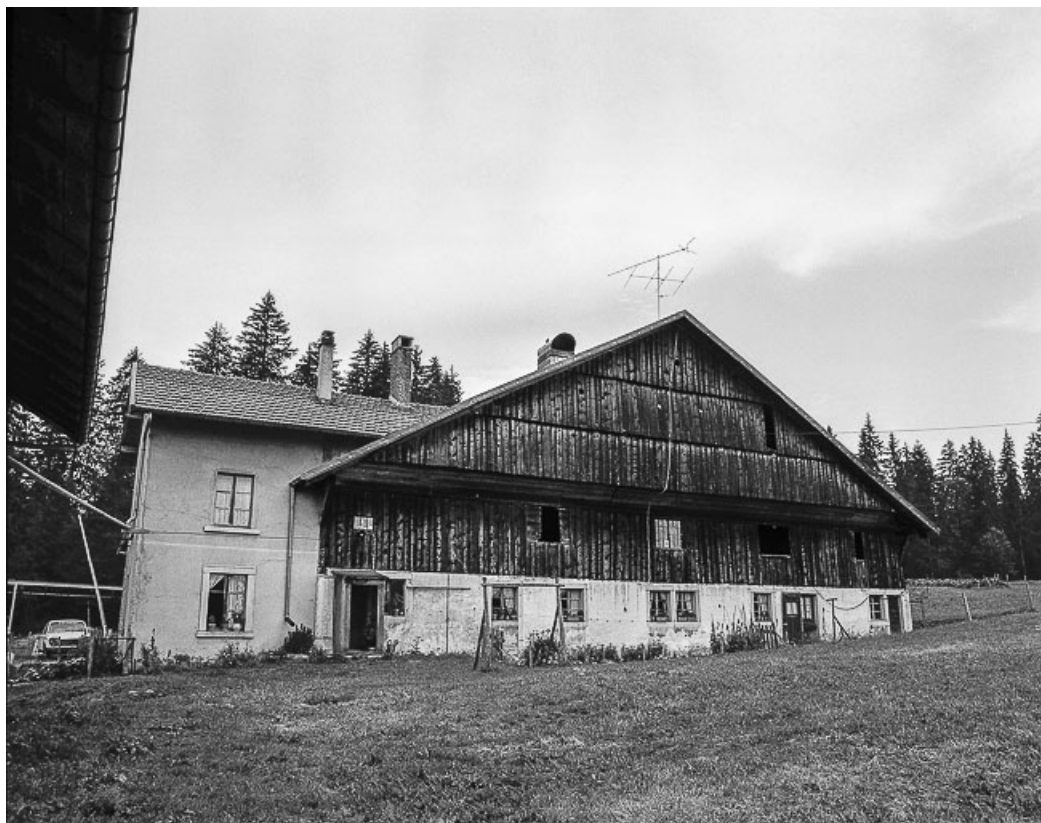
Façade antérieure. 25, Montlebon
