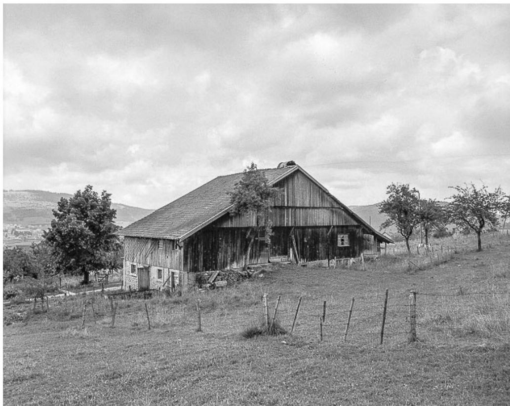
Façades postérieure et latérale droite. 25, Montlebon
