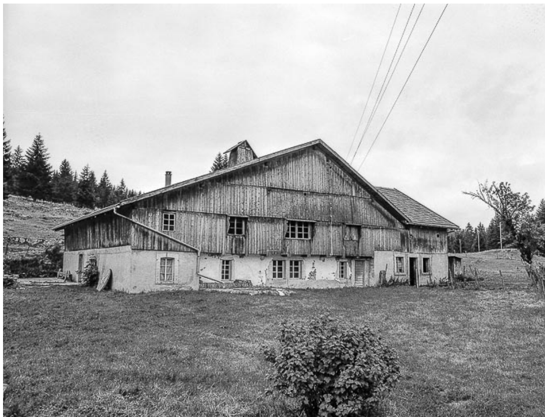
Façade antérieure. 25, Montlebon
