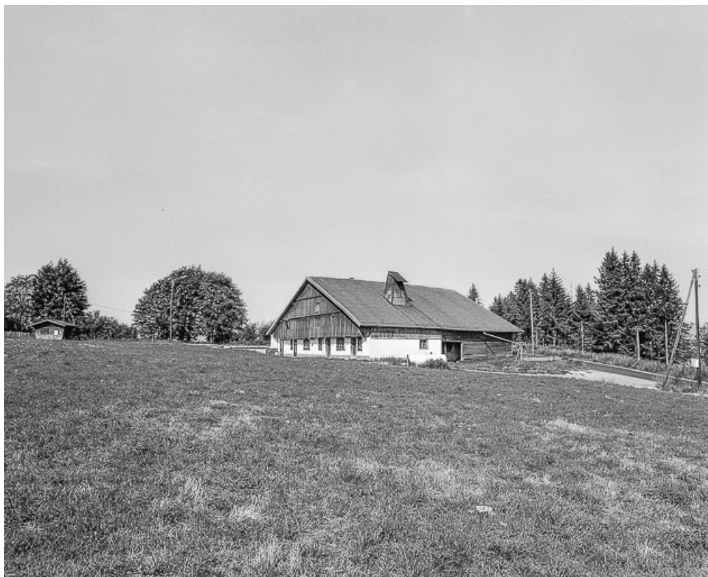
Façades antérieure et latérale droite. 25, Montlebon
