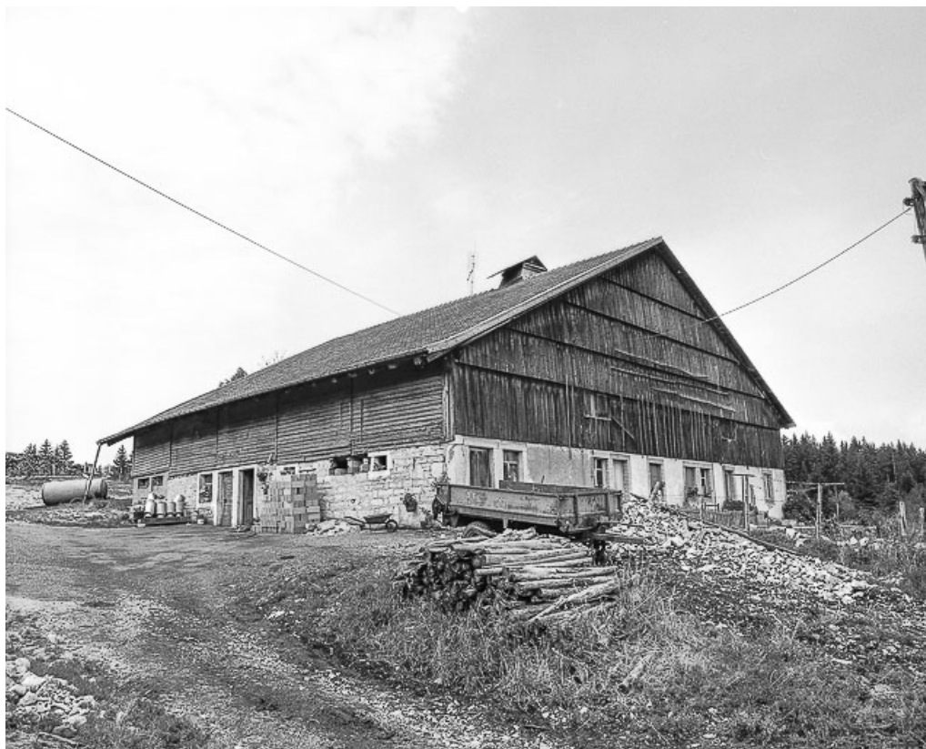
Façades antérieure et latérale. 25, Montlebon
