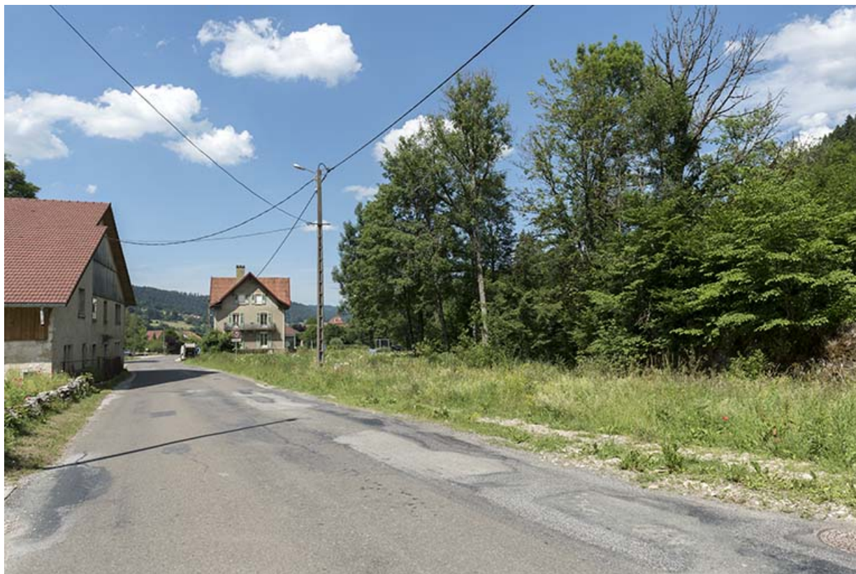
Vue d'ensemble depuis le sud : à gauche la ferme-atelier, à droite l'emplacement de la taillanderie Nicod (puis scierie Jacquet). 25, Les Gras, 3 rue le Dessus de la Fin, lieudit : le Dessus de la Fin
