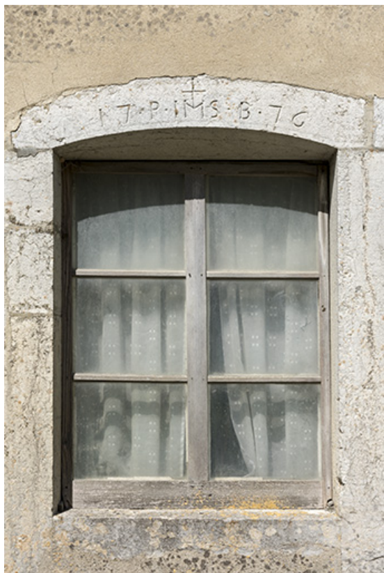
Façade est : fenêtre avec linteau daté 1776.
