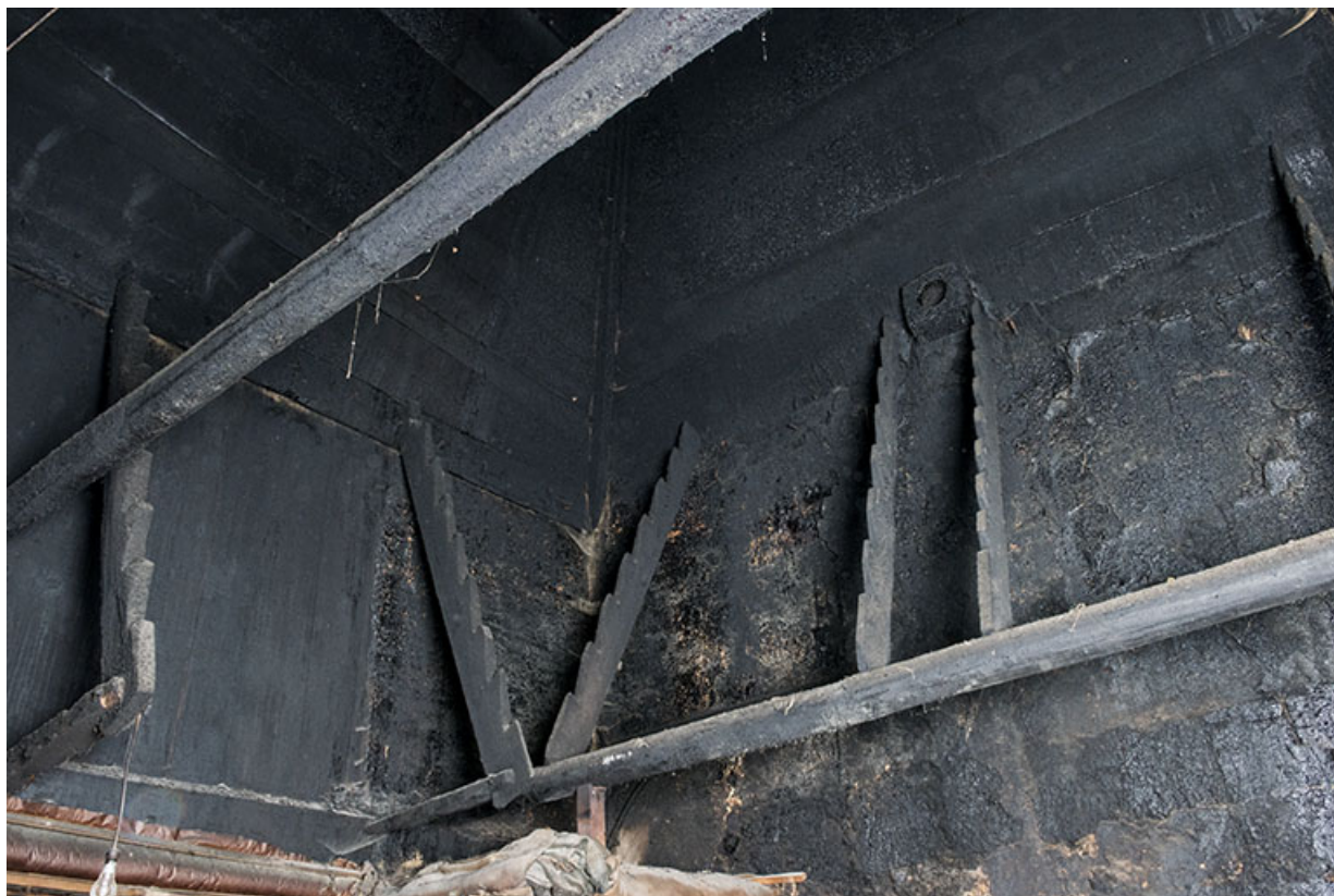
Grand tué : supports des perches auxquelles était fixée la viande à fumer.
