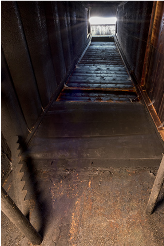
Grand tué : supports des perches et conduit.
