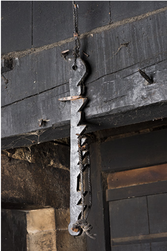
Grand tué : système de fermeture des volets.
