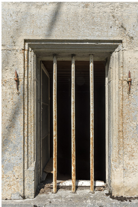
Façade est : fenêtre avec encadrement mouluré et barreaux.
