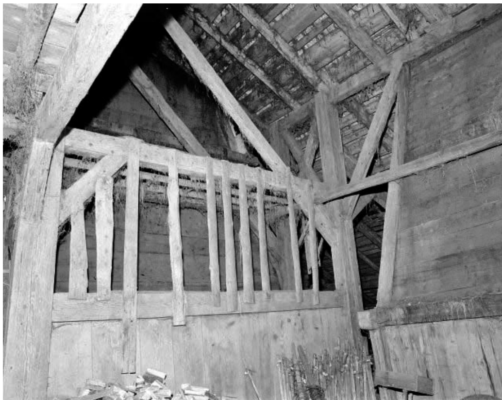
La charpente vue depuis la grange.
