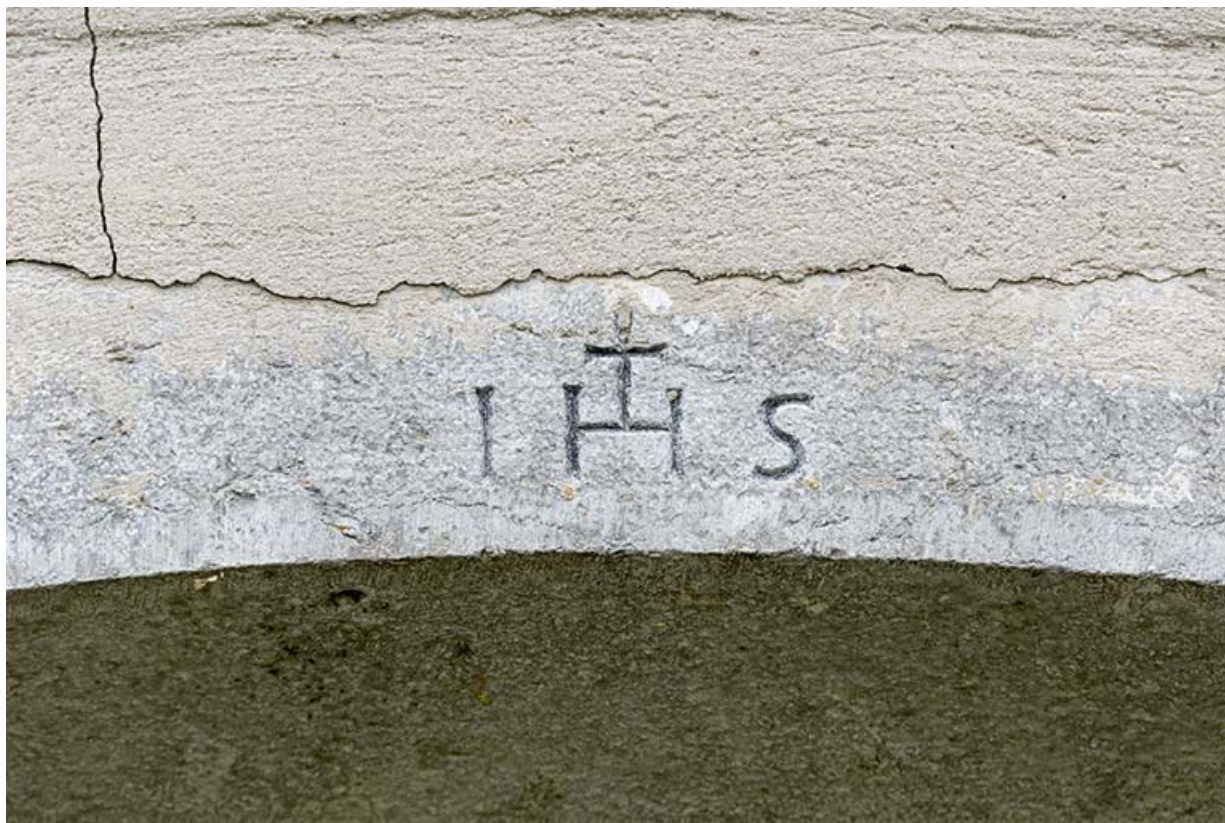
Façade nord : IHS gravé sur un linteau.
