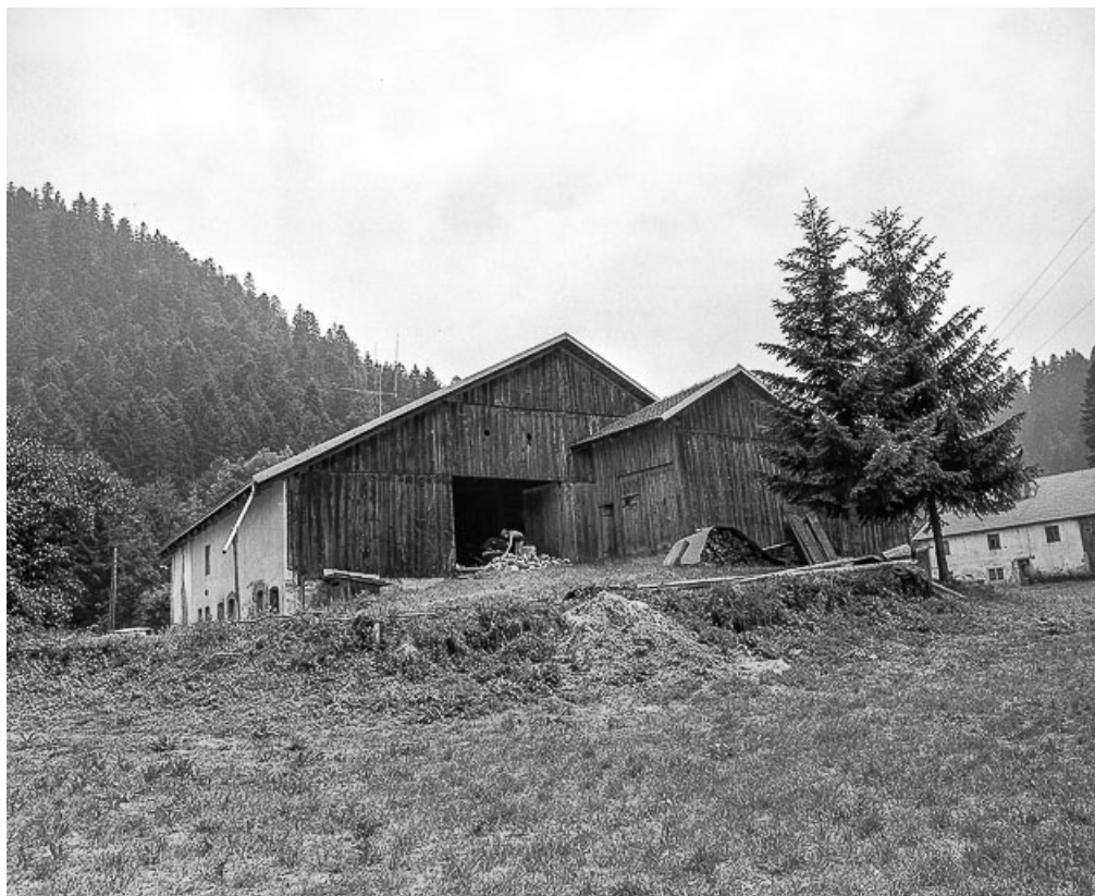
Façade ouest, en 1976.
