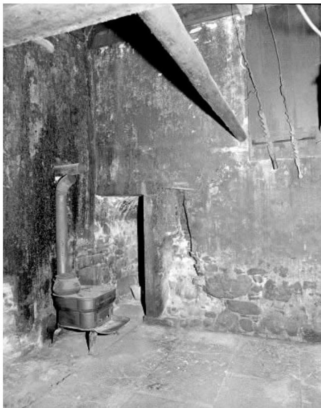
Intérieur : base du petit "tué" et bûcher.
