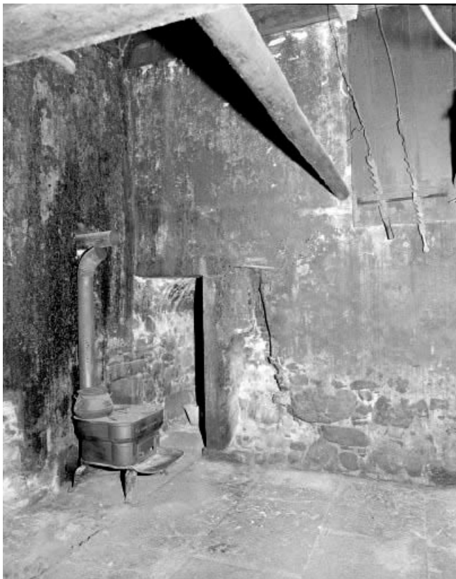
Intérieur : base du petit "tué" et bûcher.
