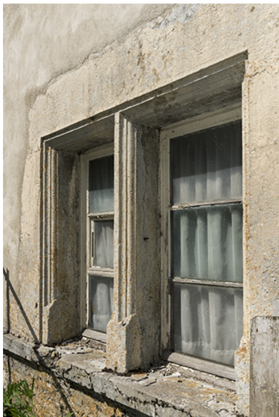
Façade est : fenêtres jumelées à encadrement mouluré.
