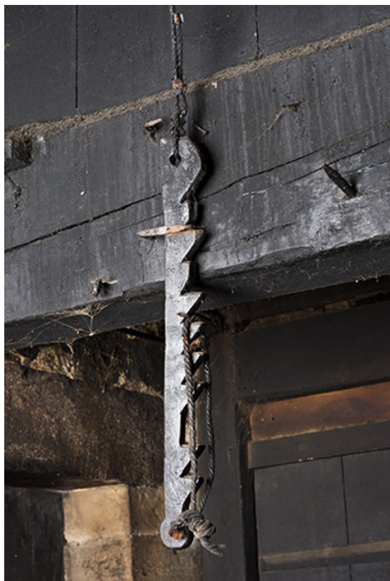
Grand tué : système de fermeture des volets.
