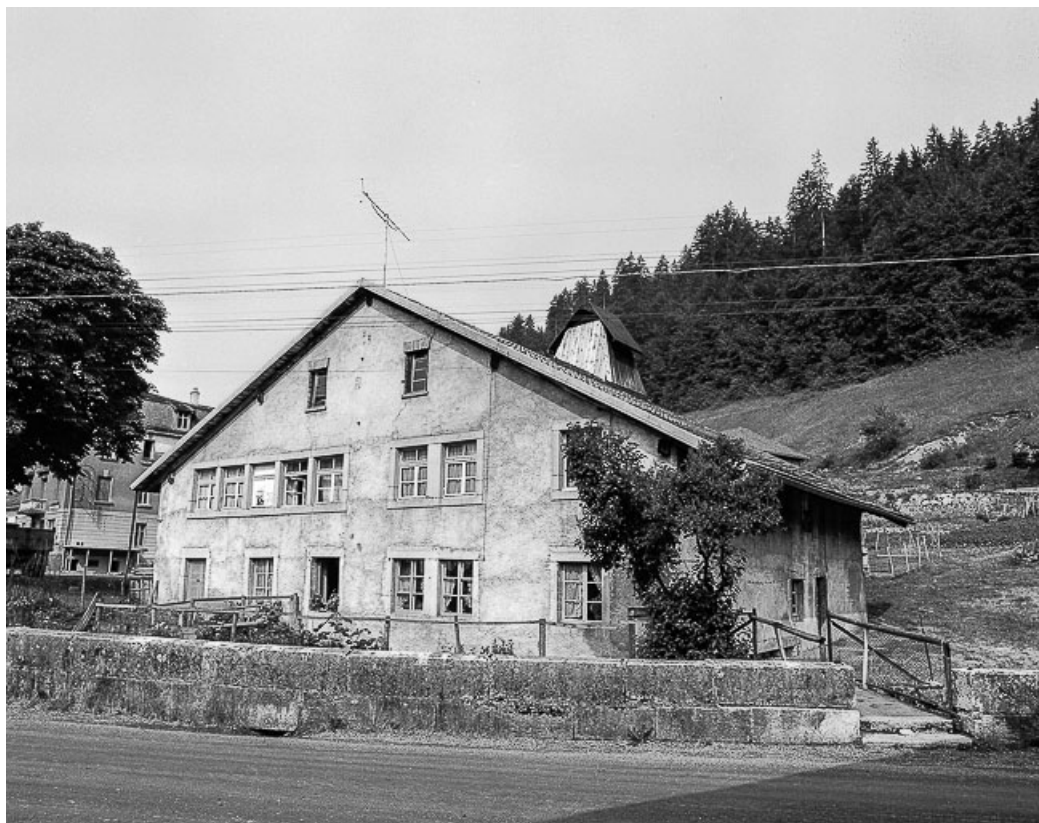
Ferme située1 Grande Rue : façades antérieure et latérale droite. 25, Les Gras
