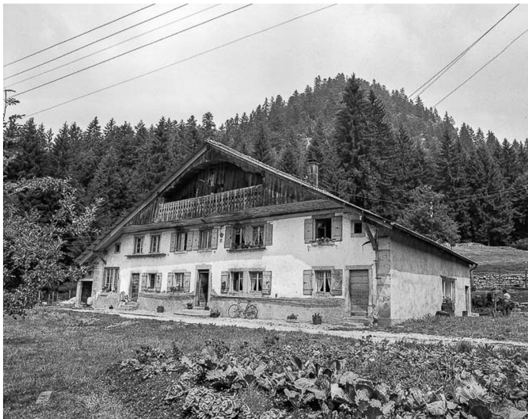
Ferme située au lieu-dit Le Dessus de la Fin, cadastrée B 1-6 : façades antérieure et latérale droite. 25, Les Gras
