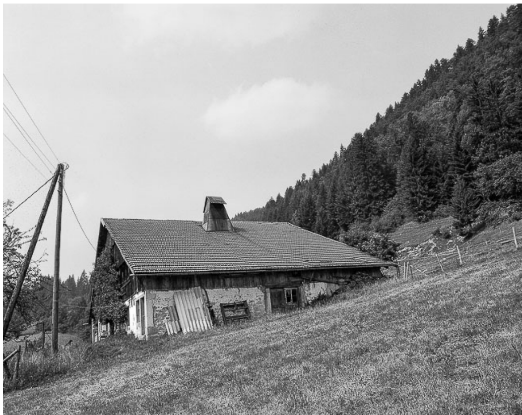
Ferme située au lieu-dit Champagne-Dessous, cadastrée ZA 4 : façades antérieure et latérale droite. 25, Les Gras
