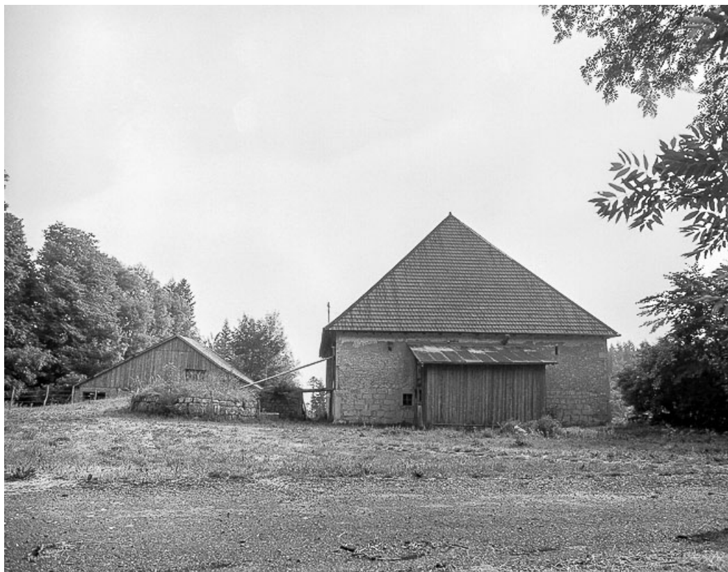
Ferme située au lieu-dit Champagne-Dessus, cadastrée ZL 1 : façade postérieure. 25, Les Gras
