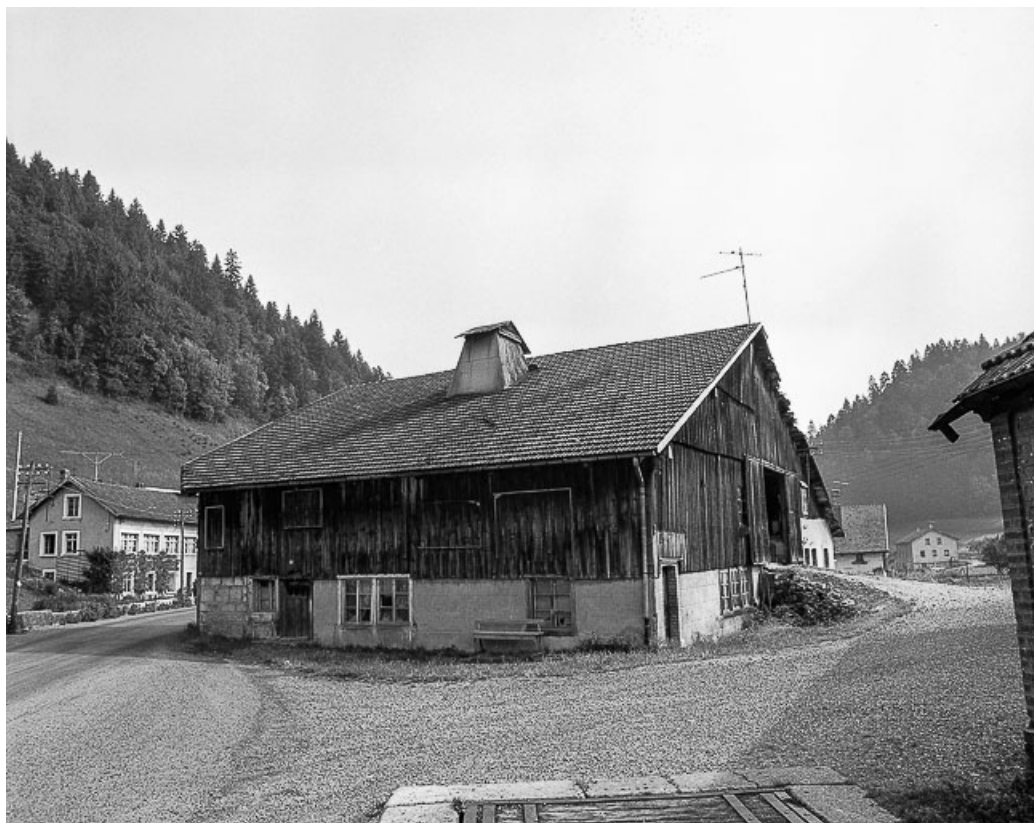
Ferme situé 6-8 Grande Rue : façades postérieure et latérale droite. 25, Les Gras
