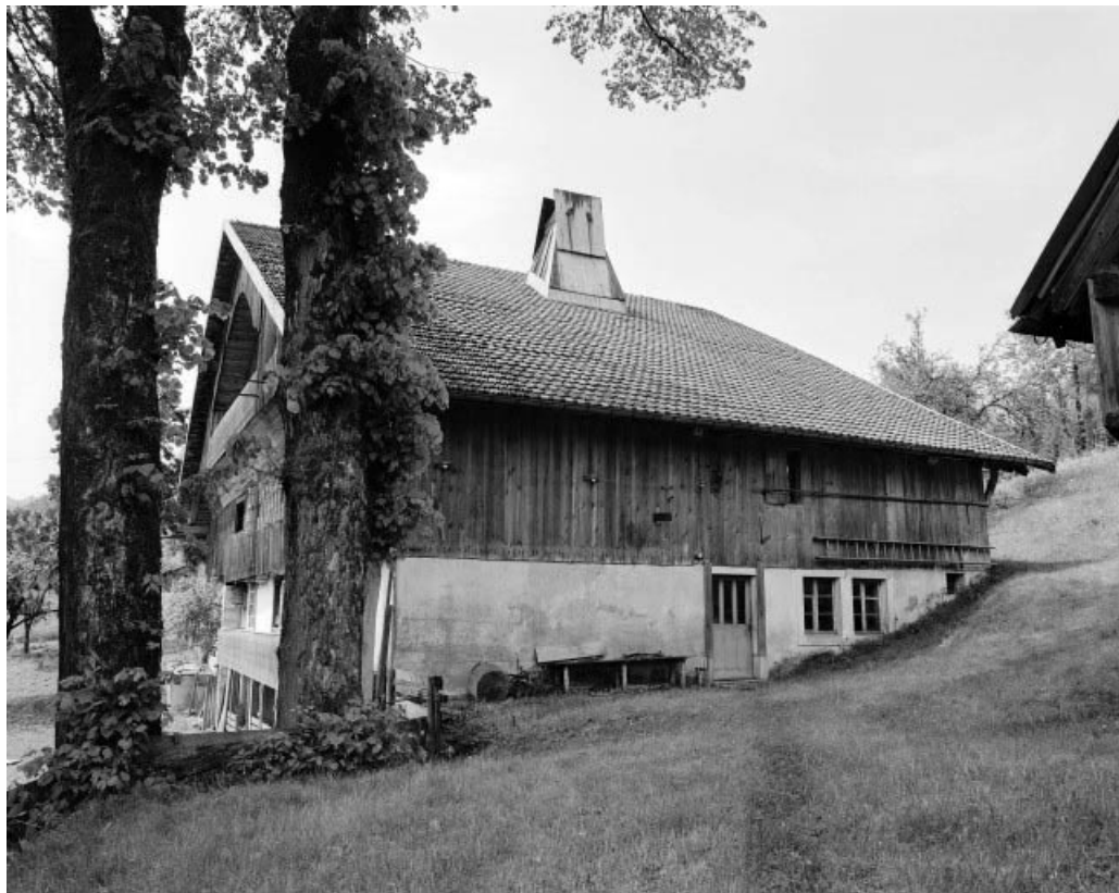
Extérieur : façades antérieure et latérale droite.
