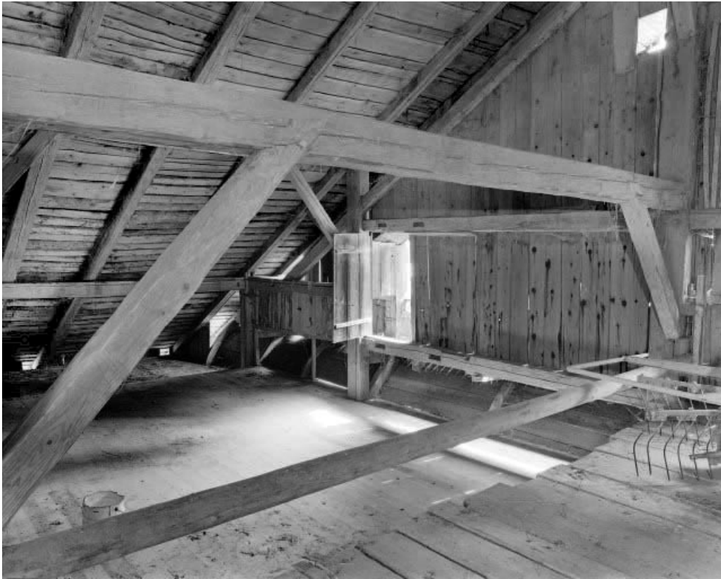
Charpente et lambreques antérieure à surplomb cintré.
