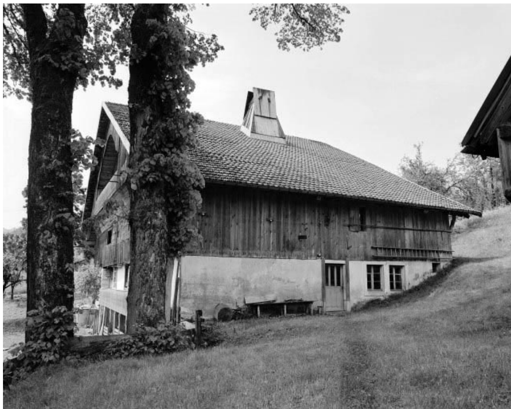
Extérieur : façades antérieure et latérale droite.
