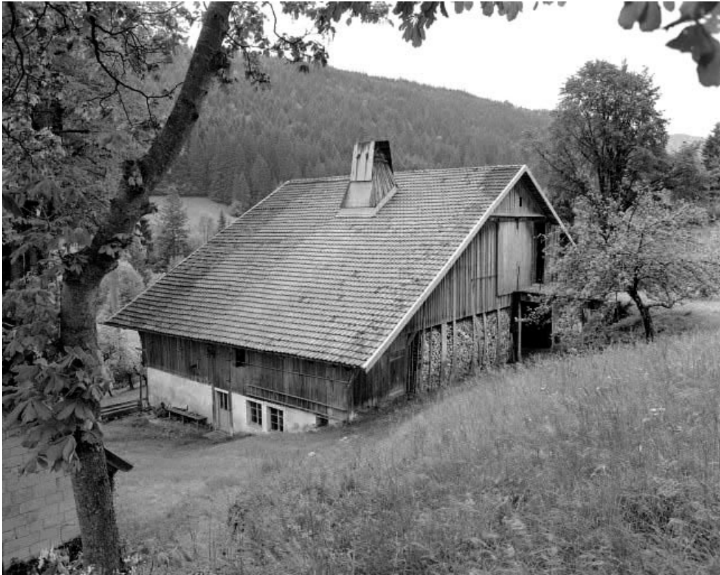
Extérieur : façades postérieure et latérale droite.
