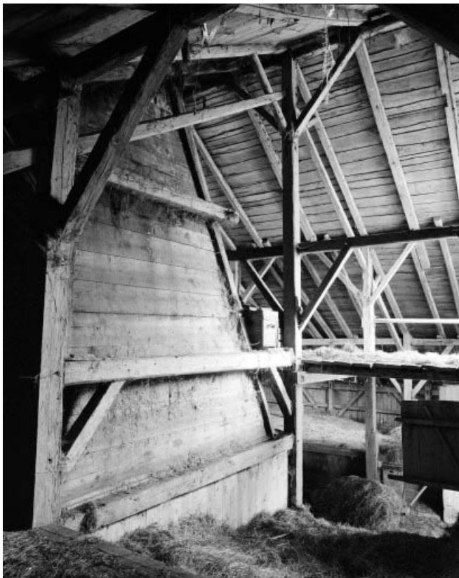
Charpente et tué.
