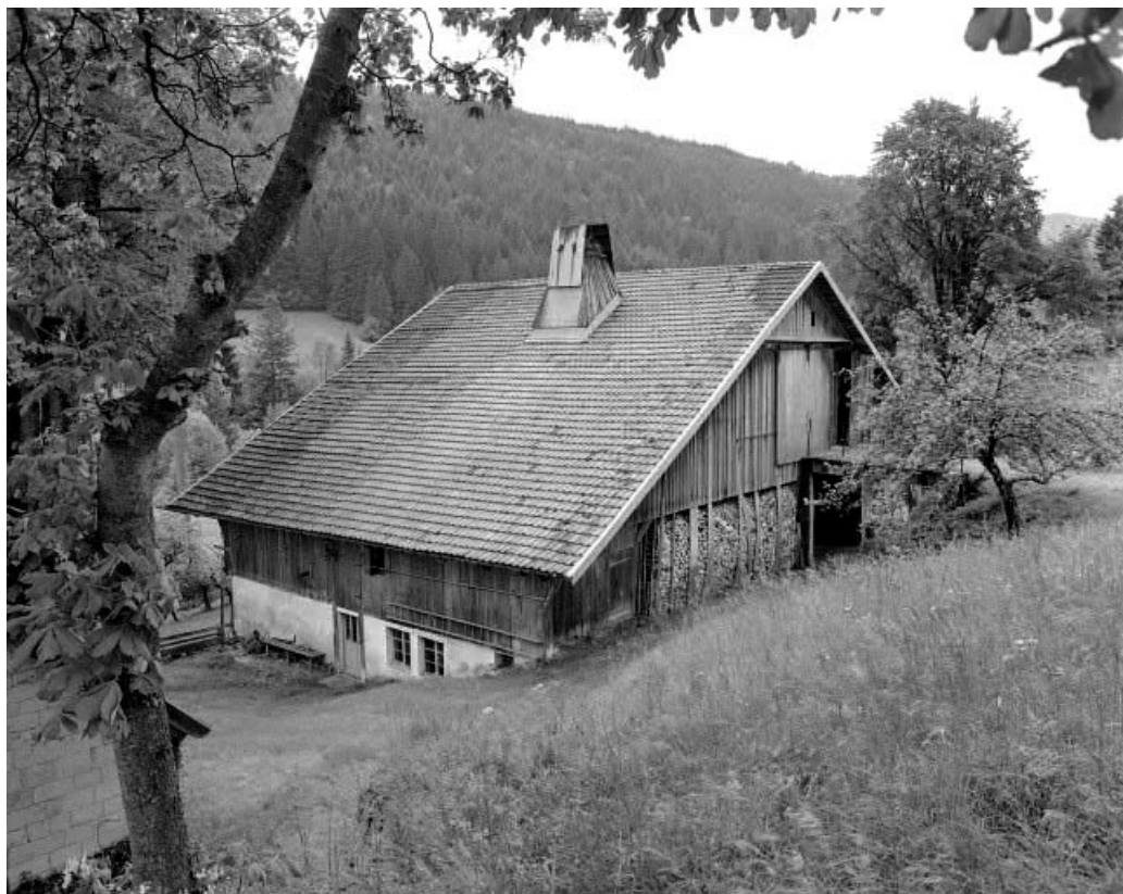
Extérieur : façades postérieure et latérale droite.
