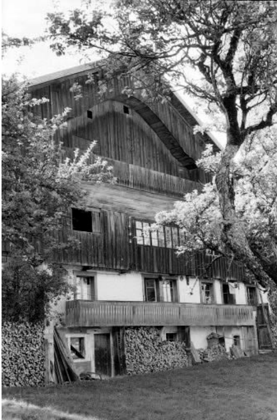
Extérieur : façade antérieure.
