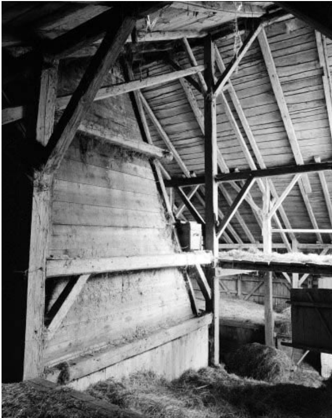
Charpente et tué.
