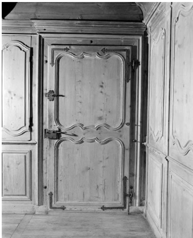
Intérieur : le "poêle", détail : une porte.
