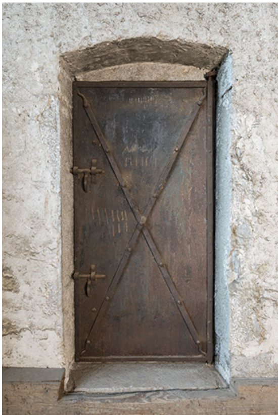
Intérieur, grange : porte métallique de la pièce à l'étage du corps sud-est. 25, Grand'Combe-Châteleu 3e ferme, lieudit : les Cordiers
