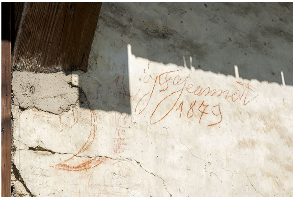
Façade est : inscriptions au crayon (J.F. Jeannot 1879). 25, Grand'Combe-Châteleu 3e ferme, lieudit : les Cordiers
