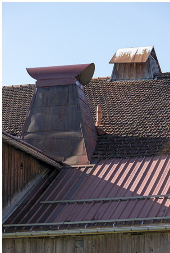
Pan de toiture nord, avec deux "tués".
