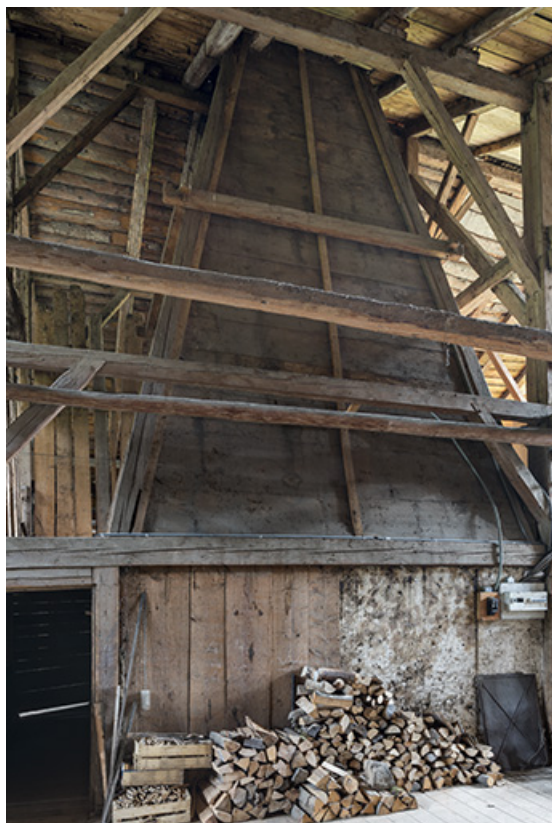
Intérieur, grange : hotte du "tué" central.
