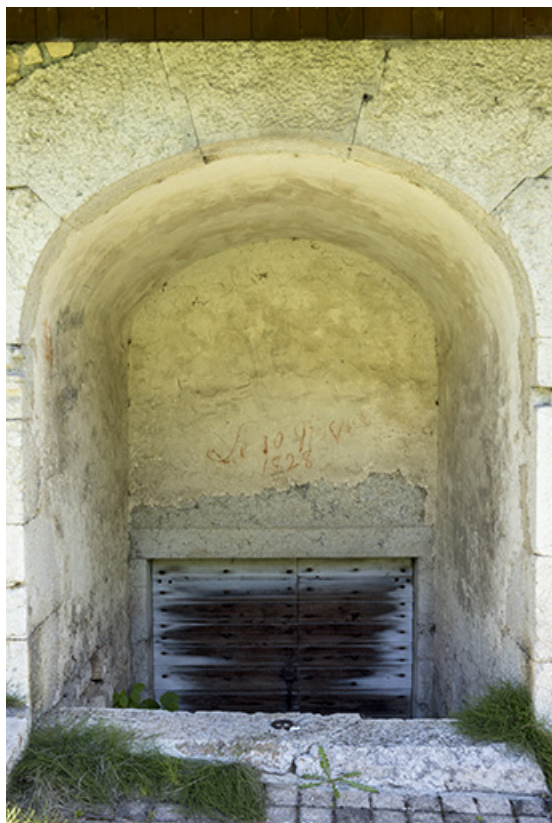
Façade sud : descente de cave et inscriptions.
