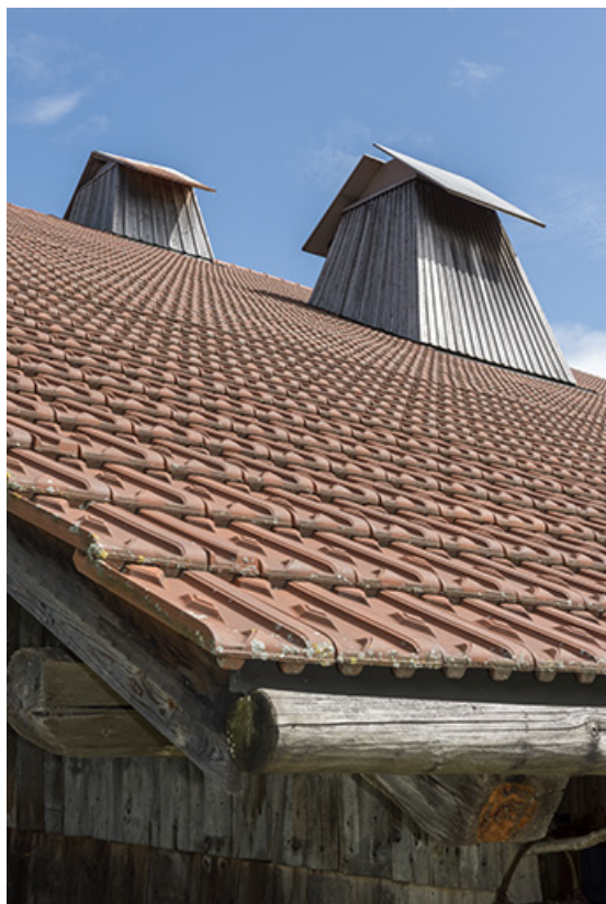
Pan de toiture sud, avec deux "tués".
