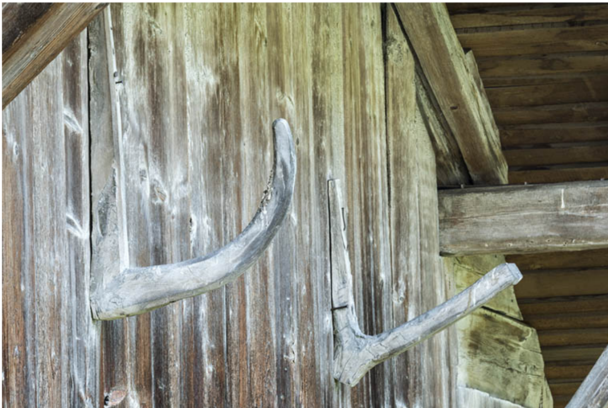
Façade ouest : crochets en bois (support d'échelle ou de faux ?).
