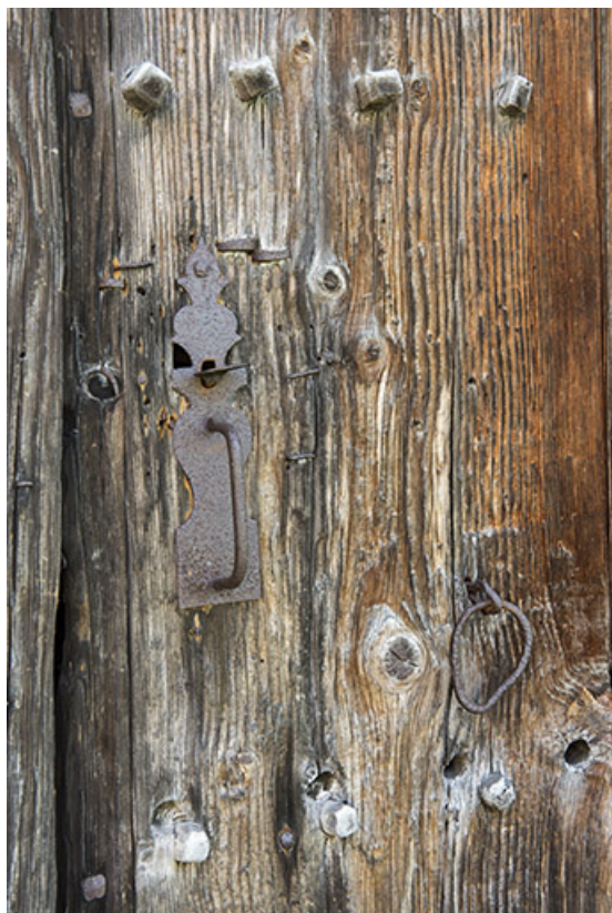
Façade ouest : détail d'une porte de grange.
