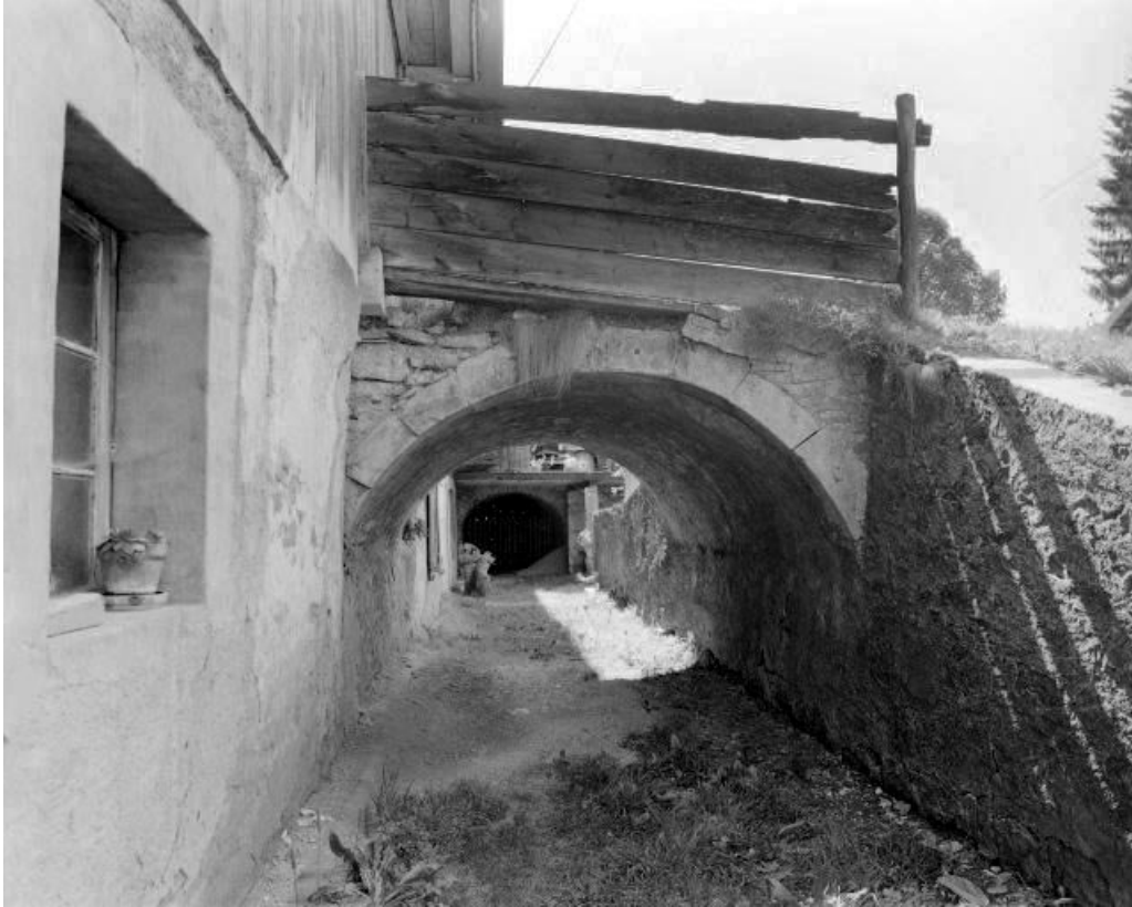
Façade antérieure : ponts de granges.
