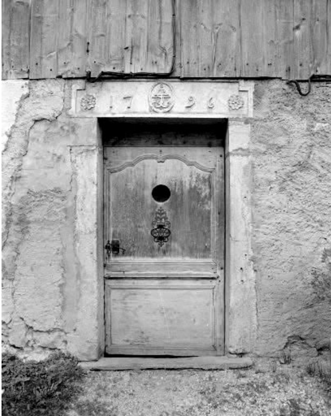
Façade antérieure : porte d'entrée.
