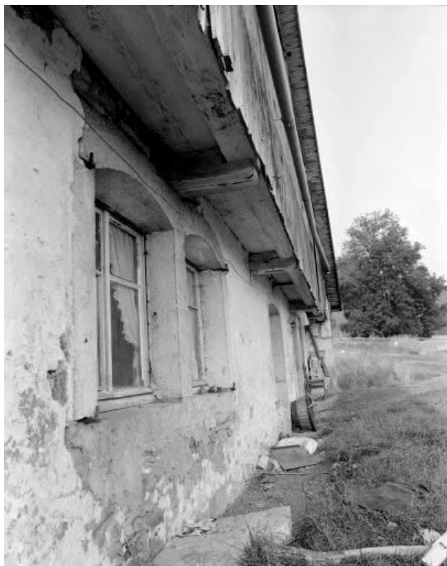
Extérieur : façade antérieure, détail : surplomb de la lambrequer.
