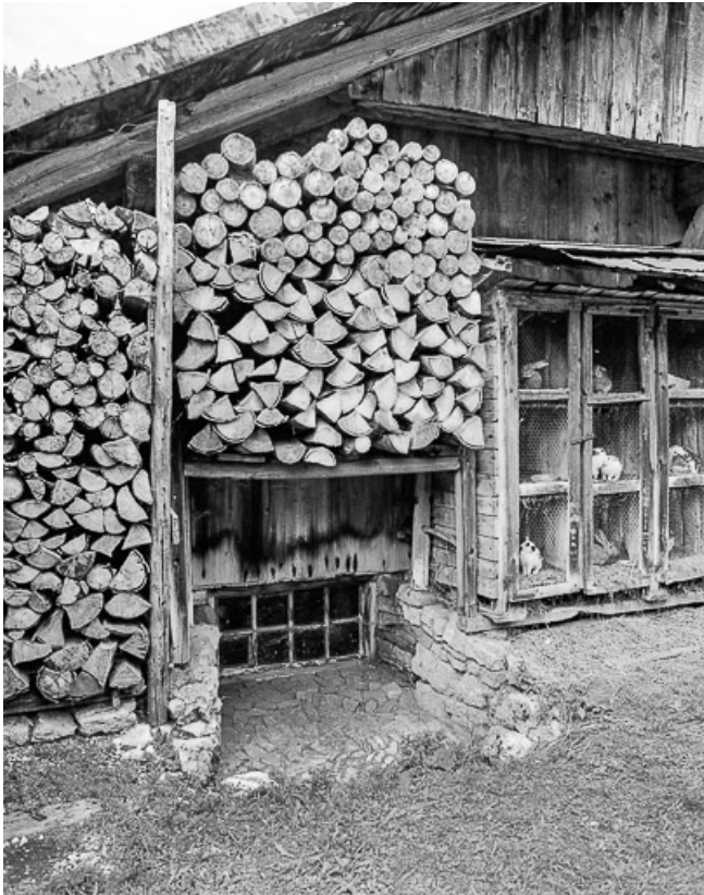
Détail : fenêtre de l'écurie.
