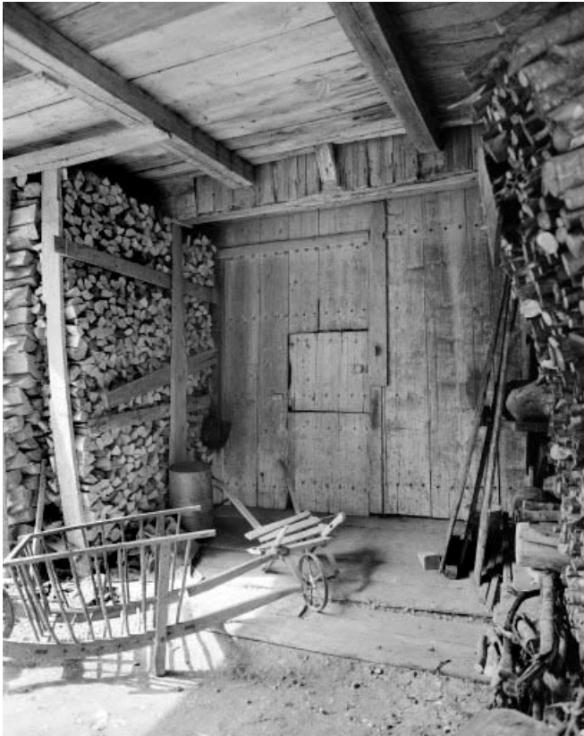
Façade postérieure : porte de grange.
