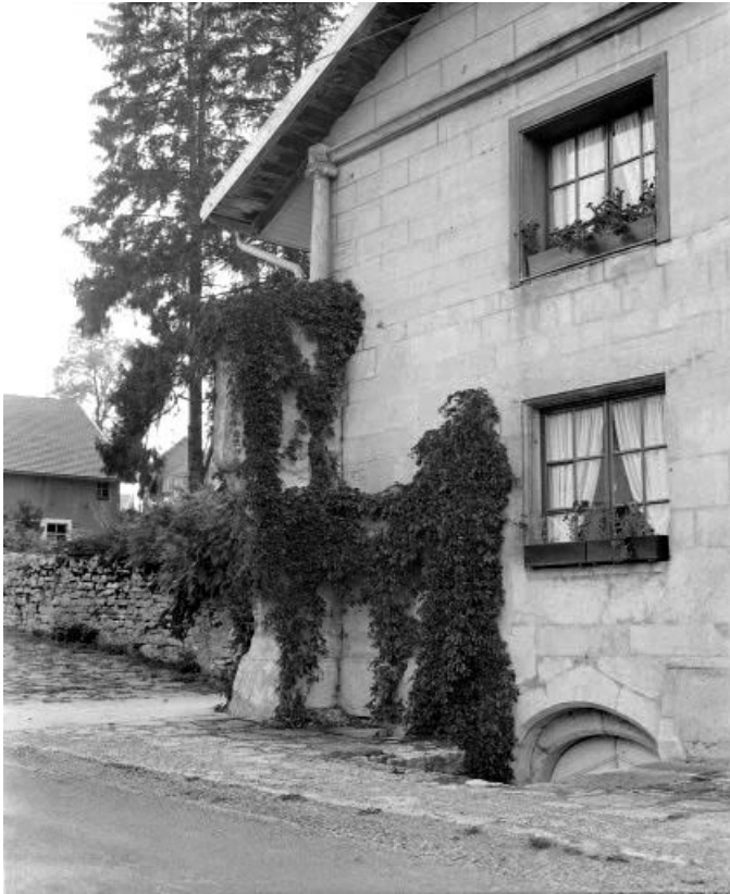
Façade antérieure : partie gauche avec contrefort et entrée de cave. 25, Grand'Combe-Châteleu, 10 Bas de Grand Combe
