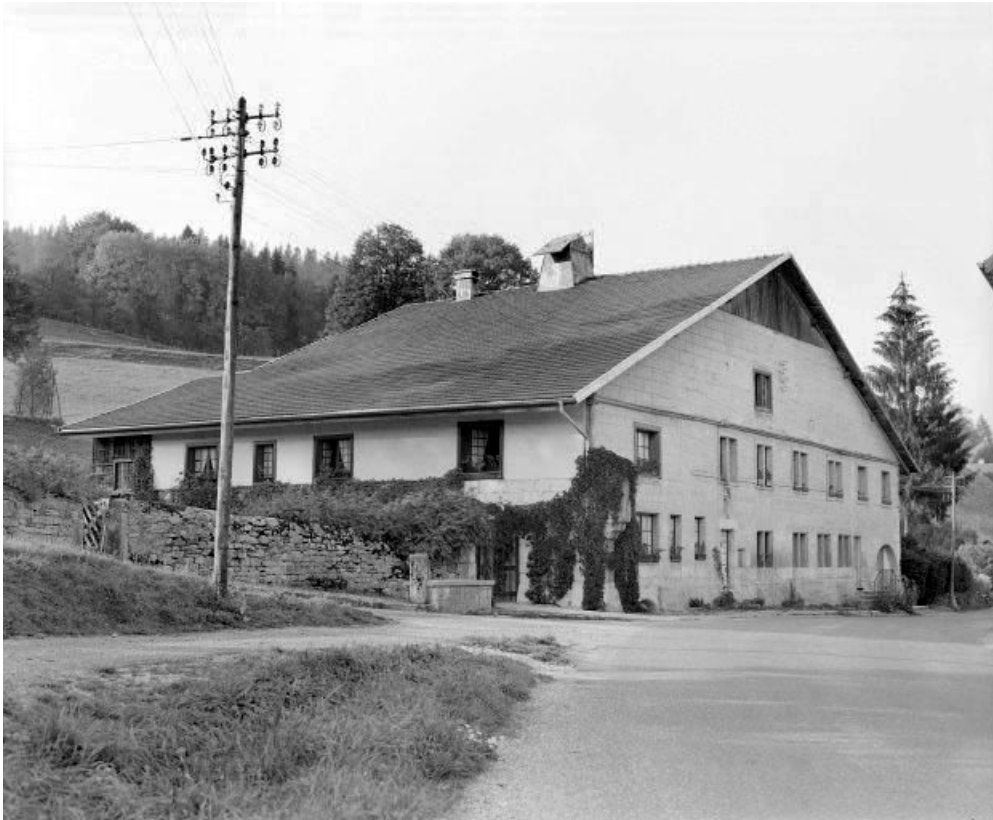
Façades antérieure et latérale gauche.
