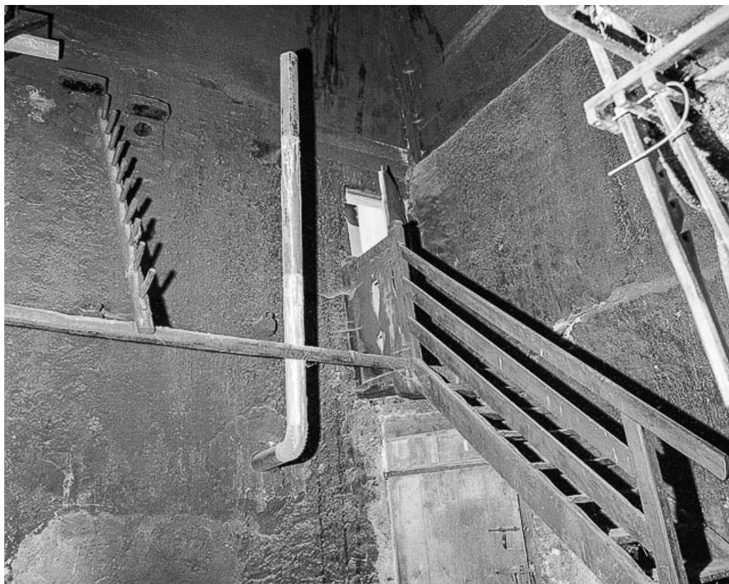
Intérieur : "tué" droit, escalier et entrée de la chambre haute.
