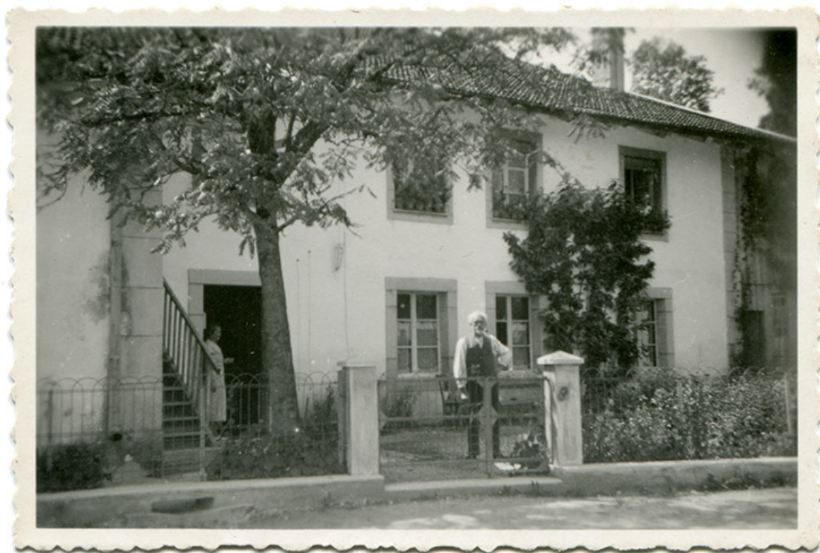
[Façade latérale droite du bâtiment, avec Jules Jacquet], 1er quart 20e siècle. 25, Grand'Combe-Châteleu, lieudit : Bas de Grand-Combe
