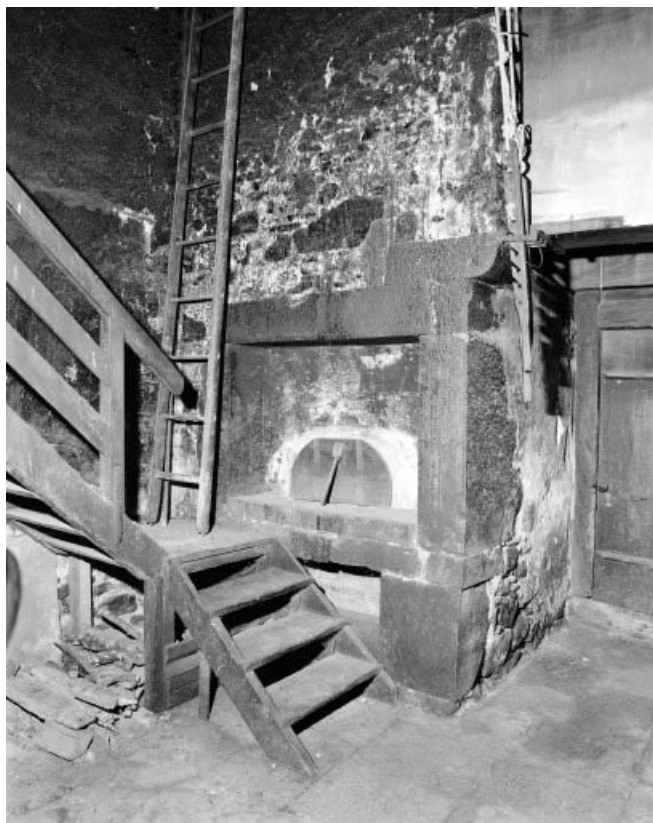
Intérieur : "tué" droit, four et départ de l'escalier.
