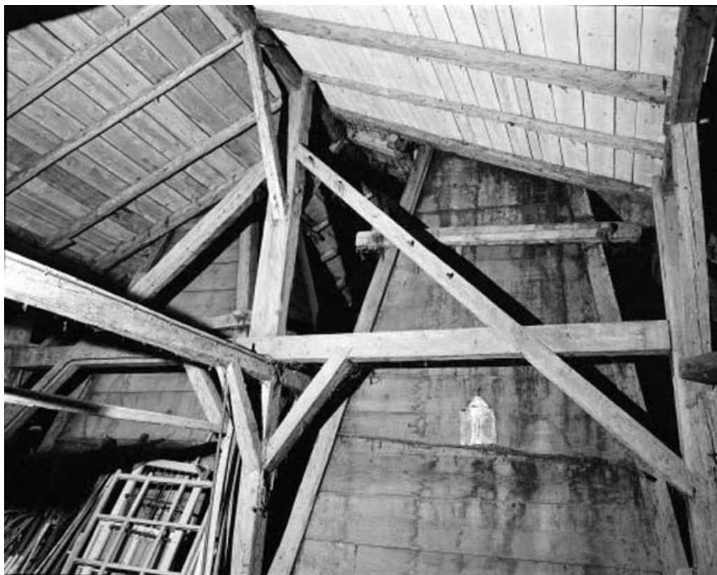
Intérieur : comble, fermes, charpente, hottes des "tués".
