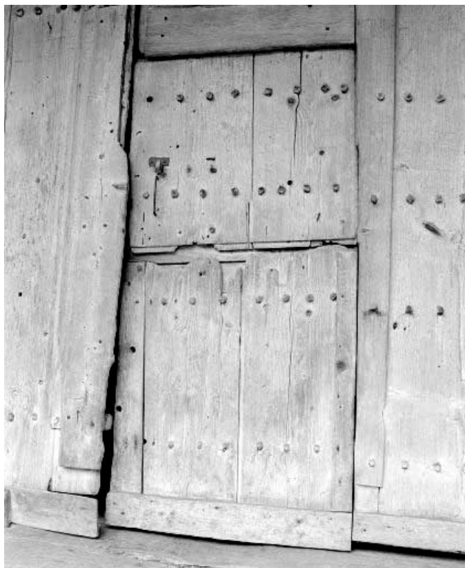
Détail : porte de grange droite, porte-guichet.
