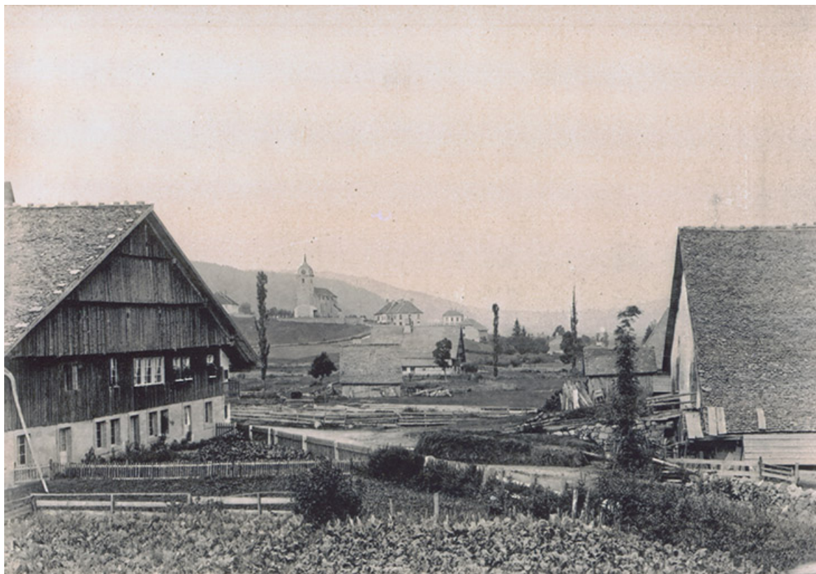
[Façade antérieure de la ferme, vue de trois quarts gauche], fin 19e siècle ou début 20e siècle [avant 1913]. 25, Grand'Combe-Châteleu, lieudit : Bas de Grand-Combe
