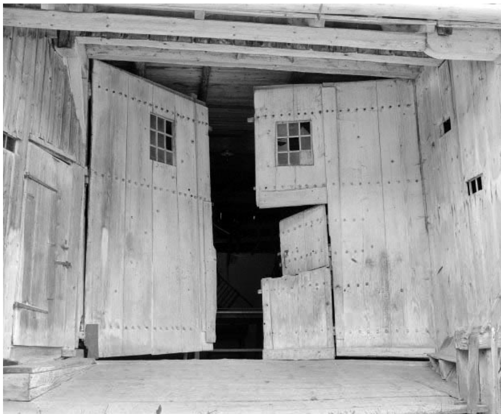
Détail : porte de grange droite, entrouverte.
