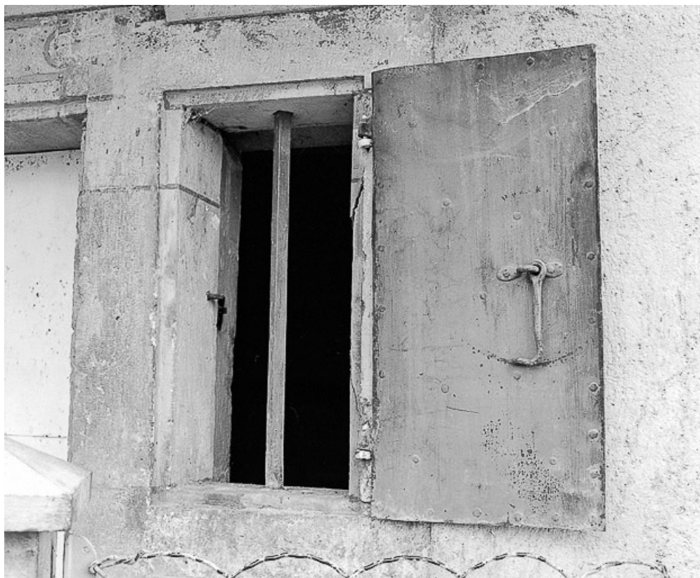
Façade antérieure : volet ouvert de la voûte.
