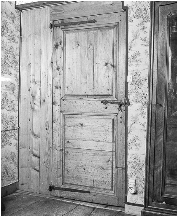
Intérieur : porte de chambre.
