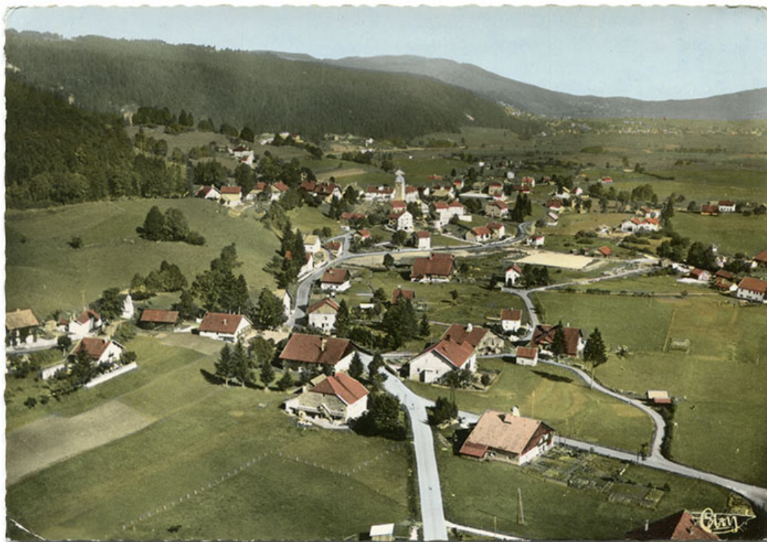
Grand'Combe-Châteleu (25. Doubs). Vue générale aérienne, 3e quart 20e siècle [avant 1970]. La ferme est visible au centre. 25, Grand'Combe-Châteleu, lieudit : Bas de Grand-Combe
