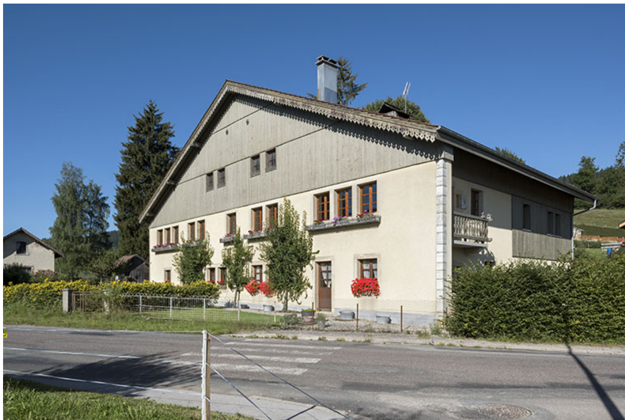
Vue d'ensemble en 2017 : façades antérieure et latérale droite.
