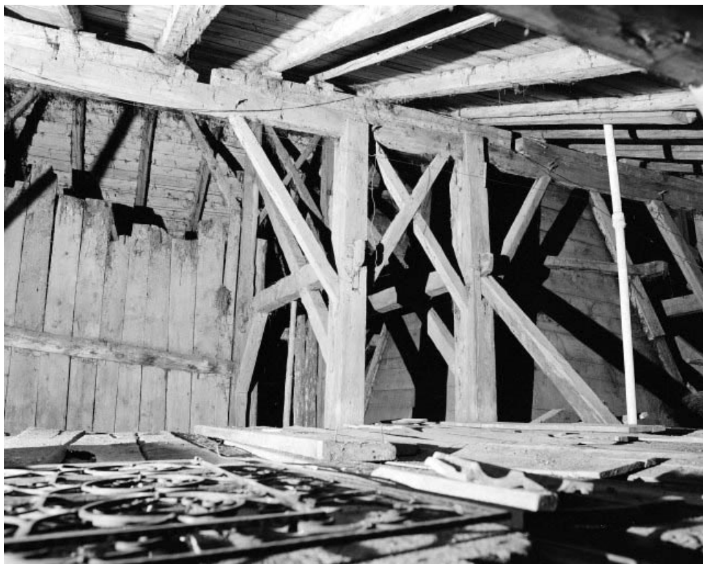
Intérieur : combles, fermes de charpente jumelées en arrière des "tués" au niveau d'une panne. 25, Grand'Combe-Châteleu, lieudit : Bas de Grand-Combe
