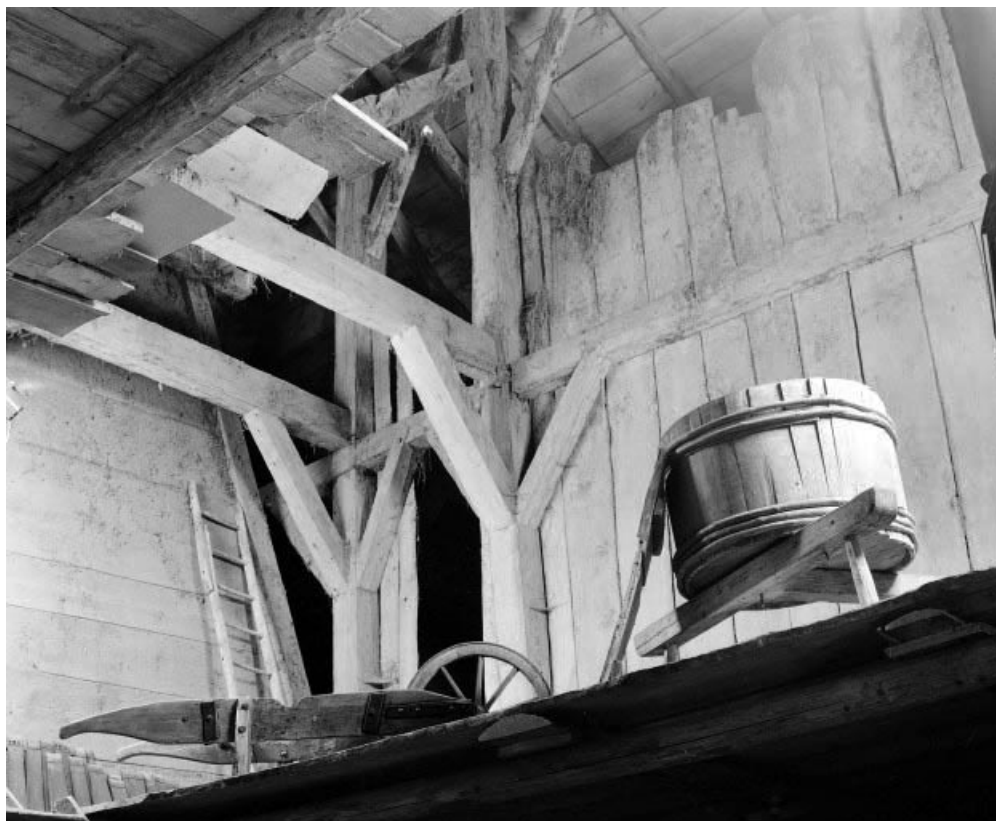
Intérieur : combles, fermes de charpente jumelées en arrière des "tués" au niveau de la faitière. 25, Grand'Combe-Châteleu, lieudit : Bas de Grand-Combe
