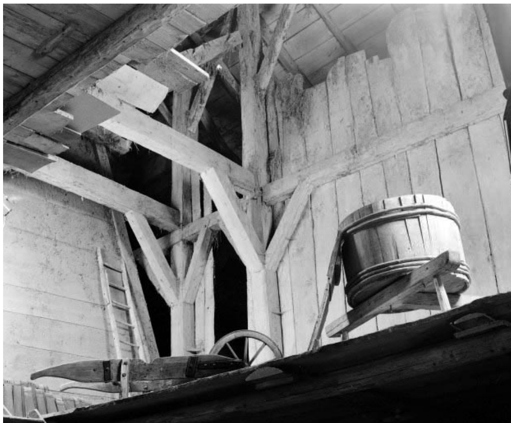
Intérieur : combles, fermes de charpente jumelées en arrière des "tués" au niveau de la faitière. 25, Grand'Combe-Châteleu, lieudit : Bas de Grand-Combe
