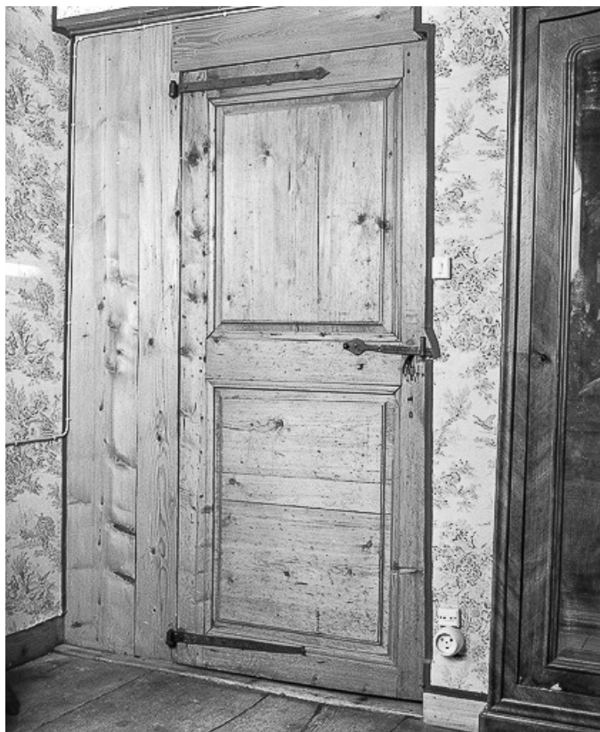
Intérieur : porte de chambre.
