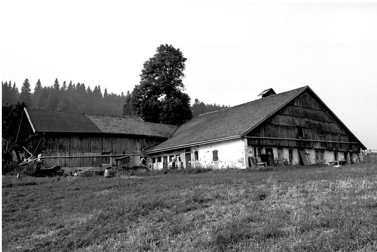
Vue d'ensemble, face nord.
