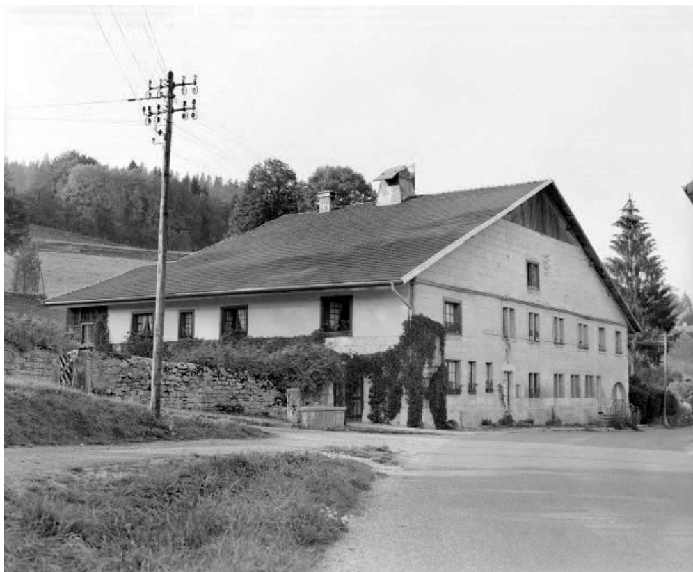
Façades antérieure et latérale gauche.
