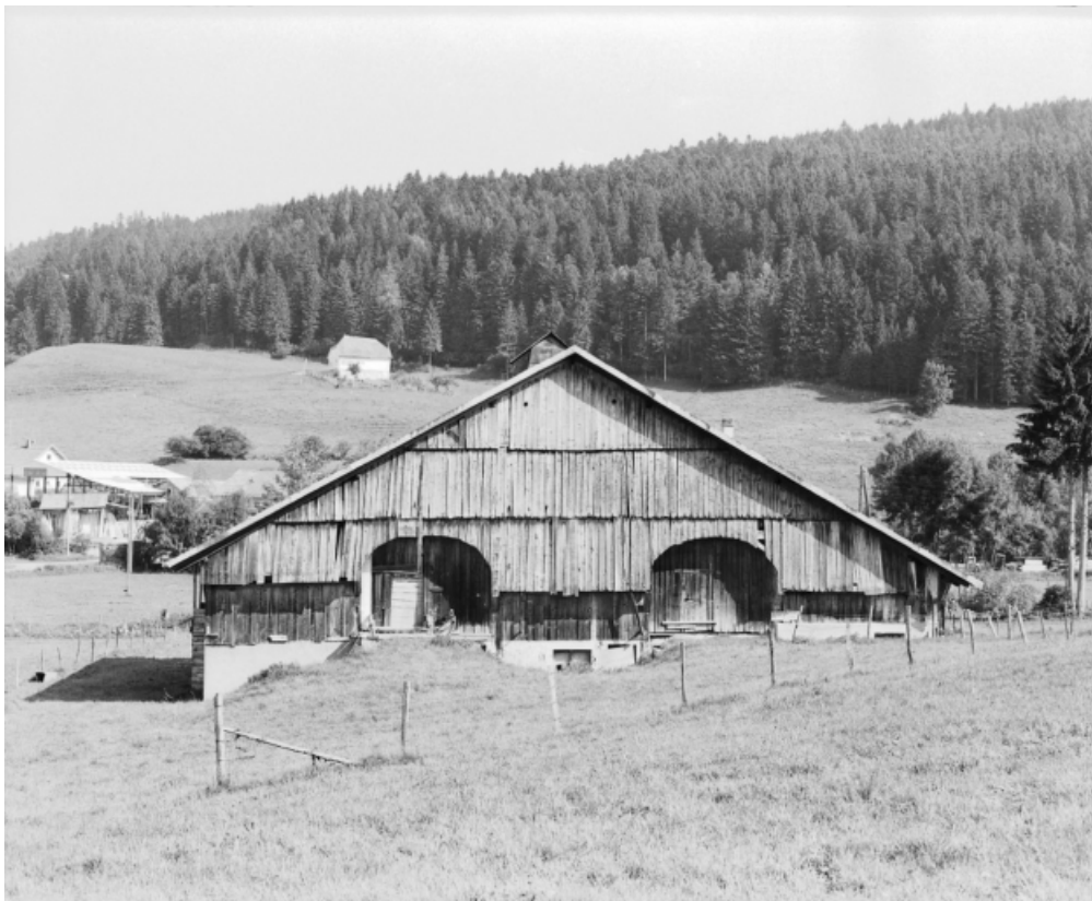
Façade postérieure : deux " levées de grange " et " lambréchure ". 25, Grand'Combe-Châteleu
