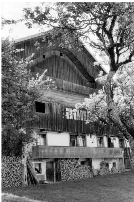
Extérieur : façade antérieure.
