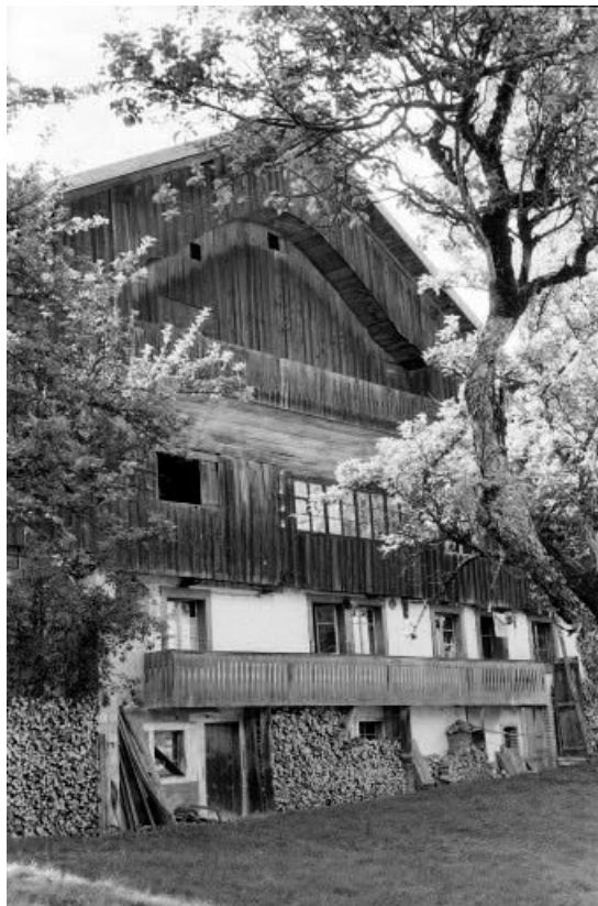
Extérieur : façade antérieure.
