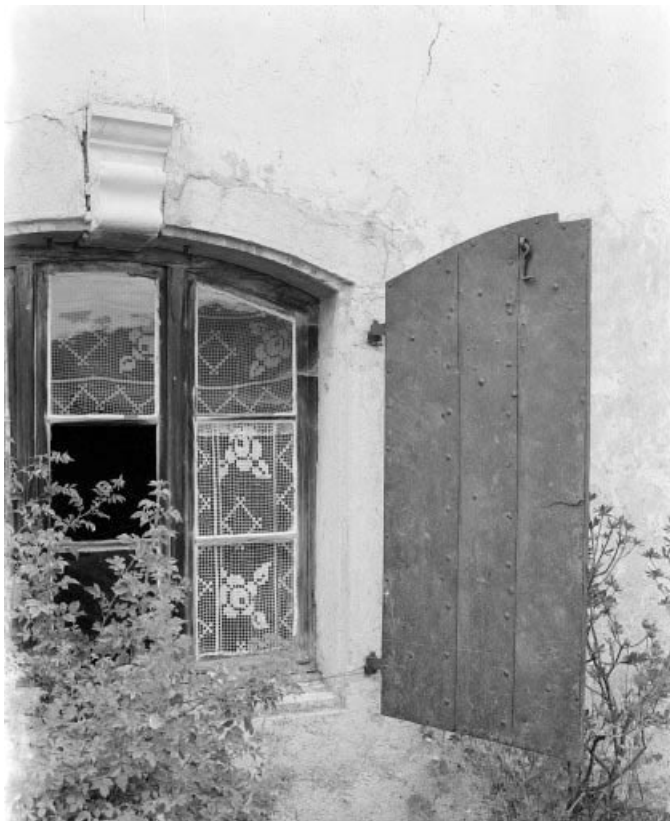
Fenêtre du "carré" : volet ouvert.
