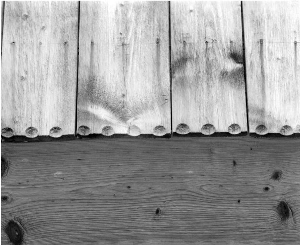
Détail : extrémité inférieure des planches de la lambreques de la façade.
