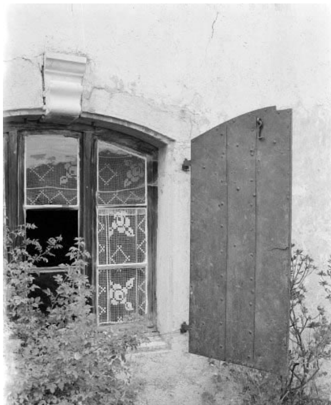
Fenêtre du "carré" : volet ouvert.
