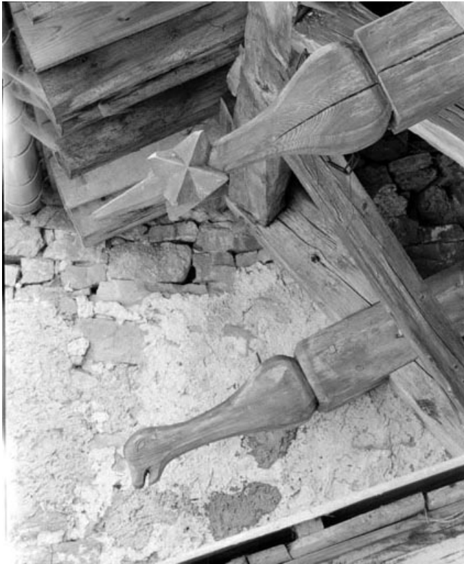
Détail : extrémité d'arbalétriers sculptés.
