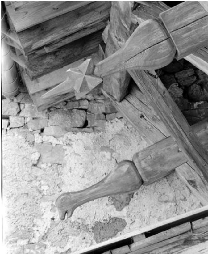
Détail : extrémité d'arbalétriers sculptés.
