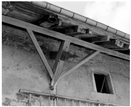
Détail: extrémité d'arbalétrier et assemblage de charpente.
