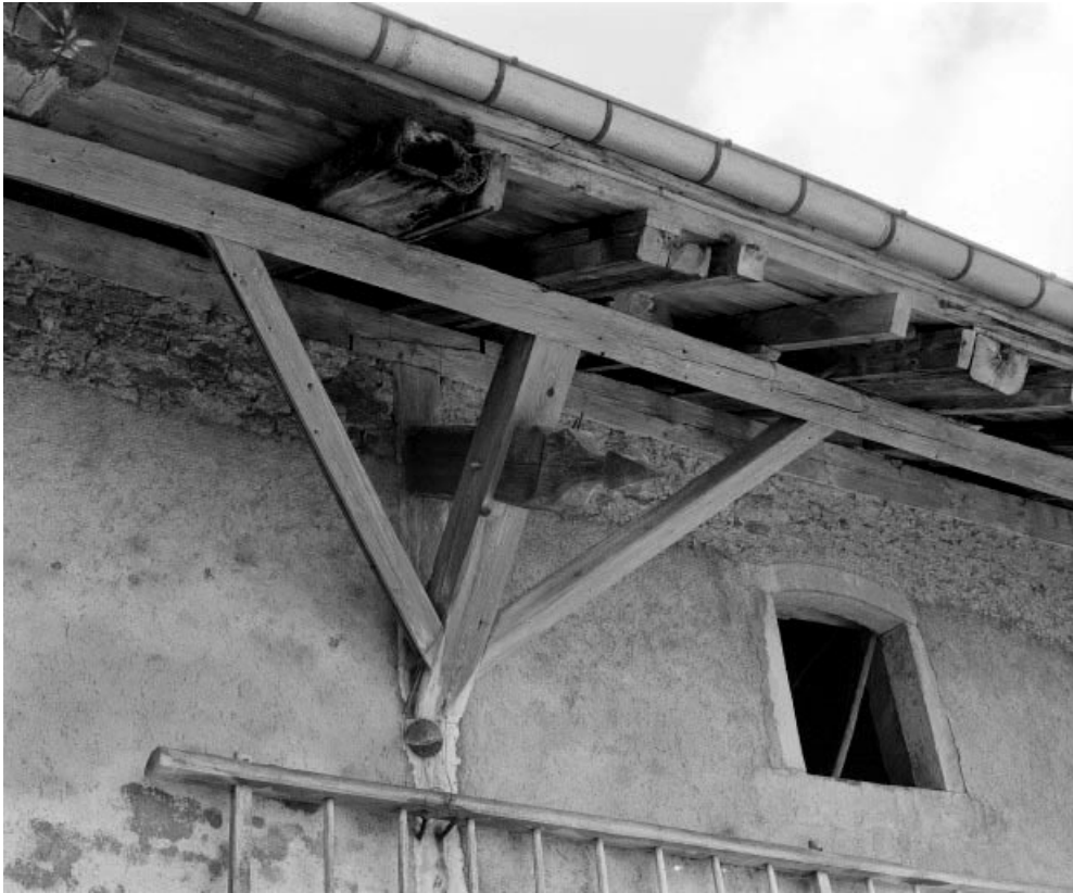
Détail: extrémité d'arbalétrier et assemblage de charpente.
