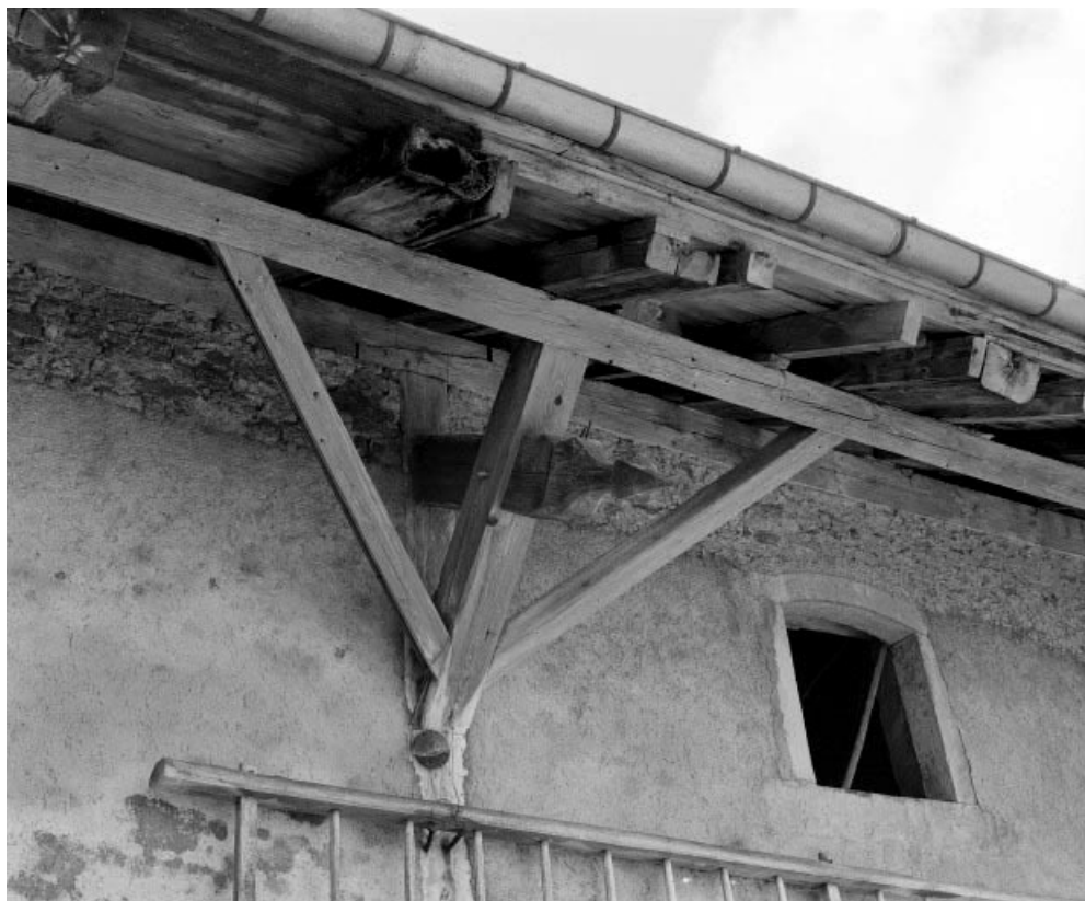
Détail: extrémité d'arbalétrier et assemblage de charpente.
