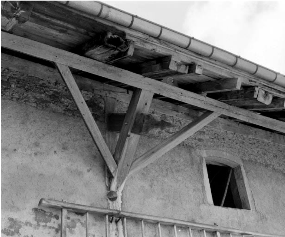
Détail: extrémité d'arbalétrier et assemblage de charpente.
