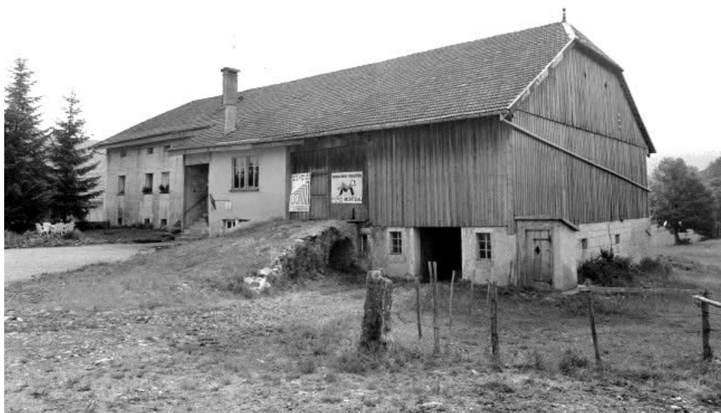
Façades postérieure et latérale gauche.
