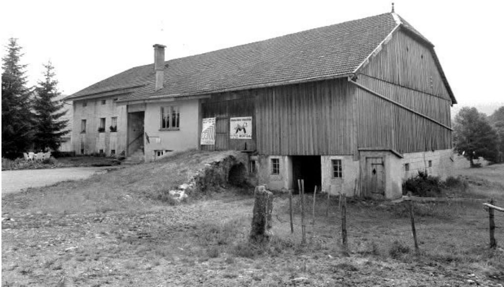
Façades postérieure et latérale gauche. 25, Les Combes
