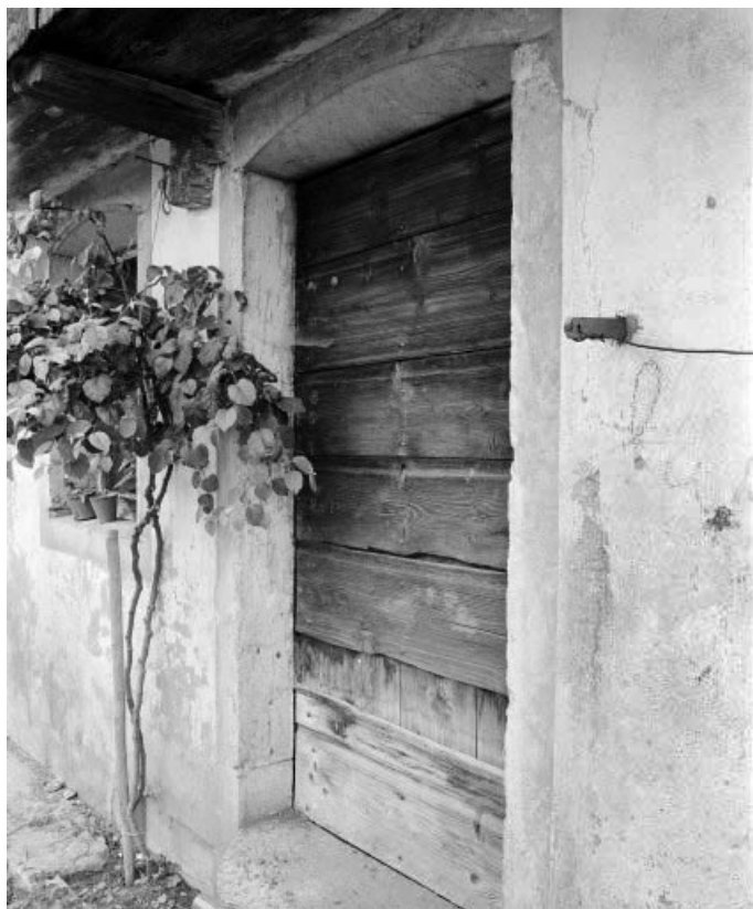
Détail de la porte d'entrée sur la facade antérieure.
