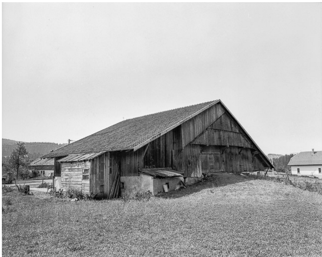
Ferme située au lieu-dit Colombière, cadastrée AB 75 : façade postérieure. 25, Les Combes
