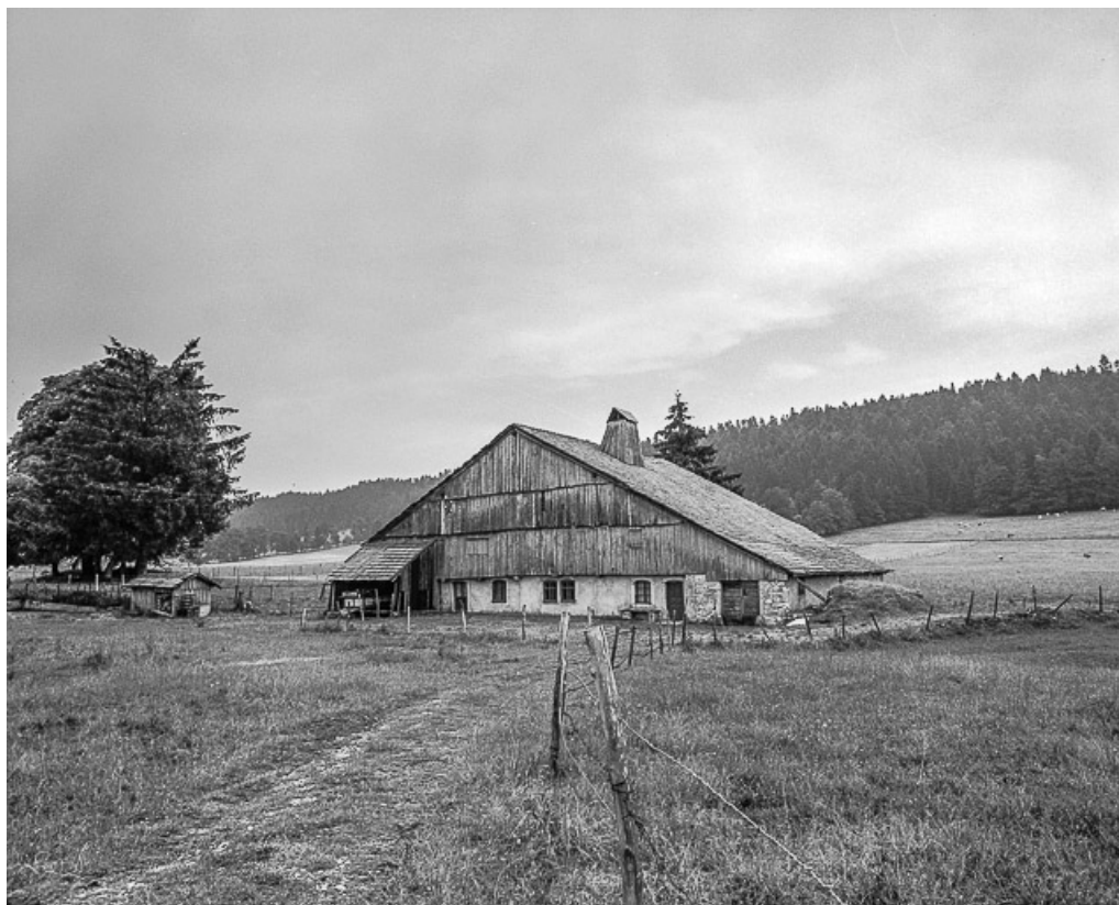
Ferme située au lieu-dit Combe d'Abondance, cadastrée B2 252 : vue d'ensemble. 25, Les Combes
