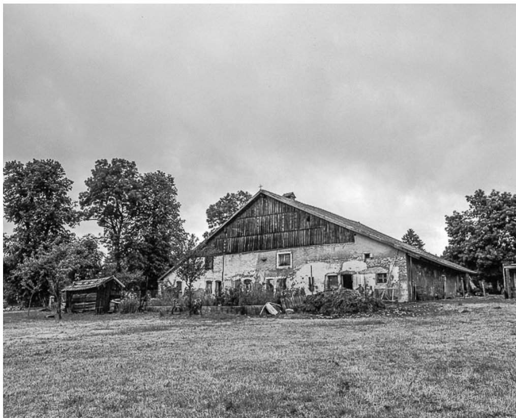
Ferme située au lieu-dit Pré Joly, cadastrée D1 16 : vue d'ensemble. 25, Les Combes
