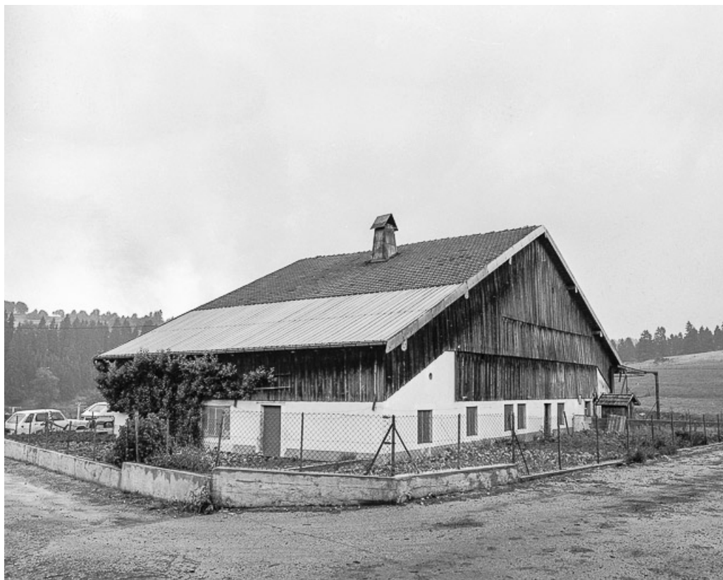
Ferme située au lieu-dit Remonot, cadastrée AC 48 : façades postérieure et latérale droite. 25, Les Combes
