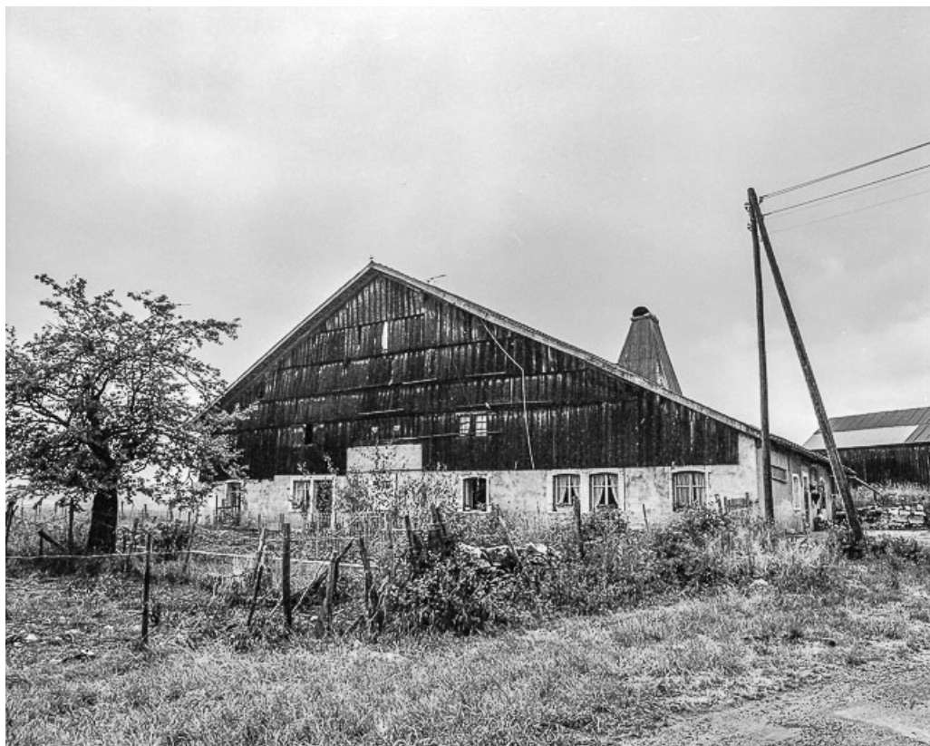
Ferme située au lieu-dit Combe d'Abondance, cadastrée B2 249 : vue d'ensemble. 25, Les Combes
