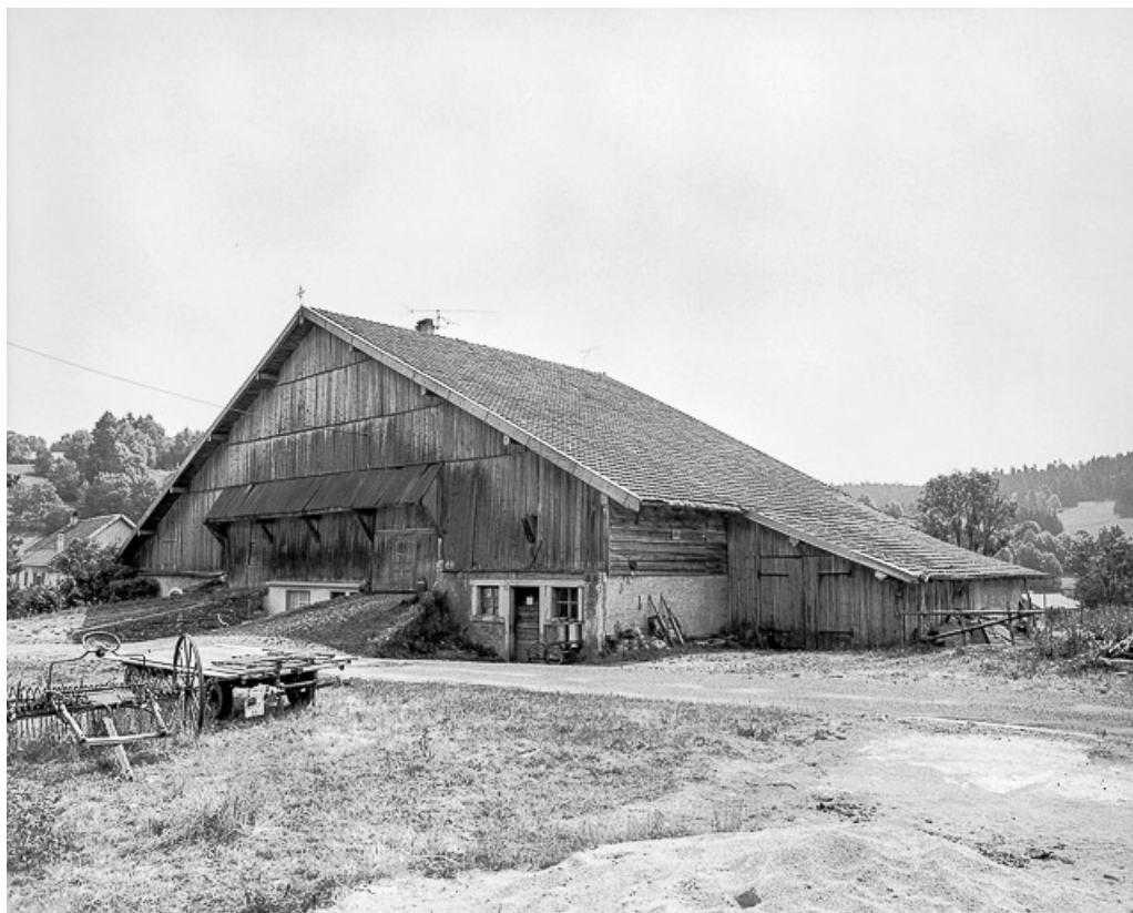
Ferme située au lieu-dit Colombière, cadastrée AB 82 : façade postérieure. 25, Les Combes
