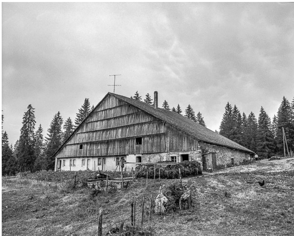
Ferme située au lieu-dit la Fontaine du Plane, cadastrée D1 197 : façade antérieure. 25, Les Combes
