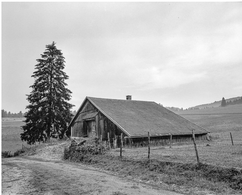
Ferme située au lieu-dit Remonot, cadastrée AC 44 : façades postérieure et latérale gauche. 25, Les Combes
