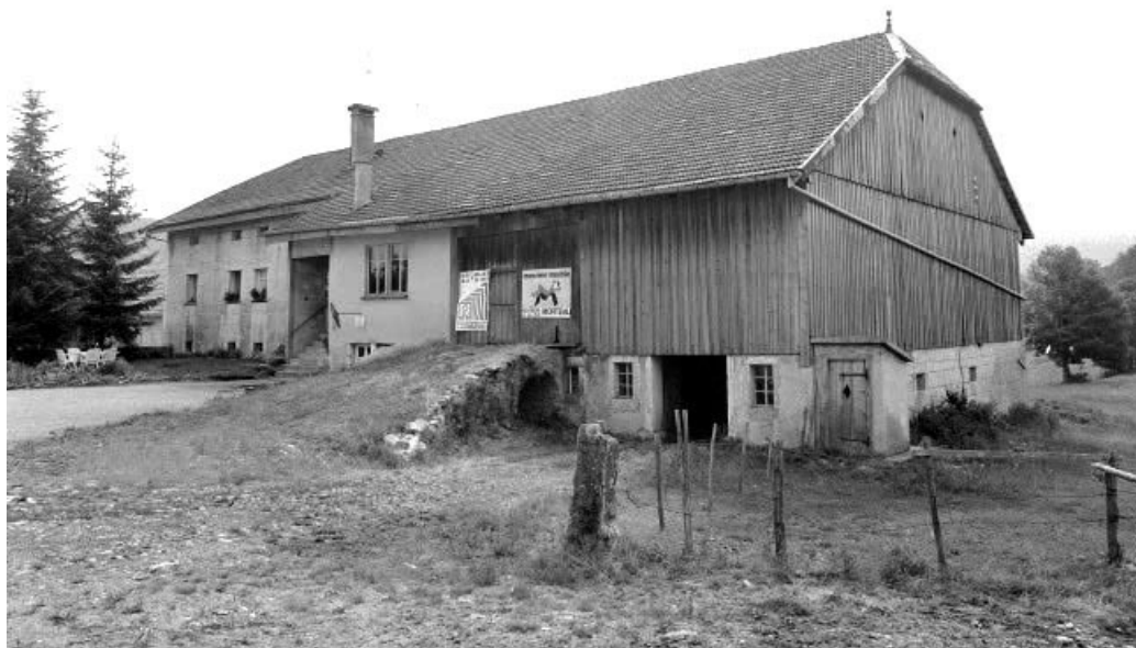
Façades postérieure et latérale gauche. 25, Les Combes
