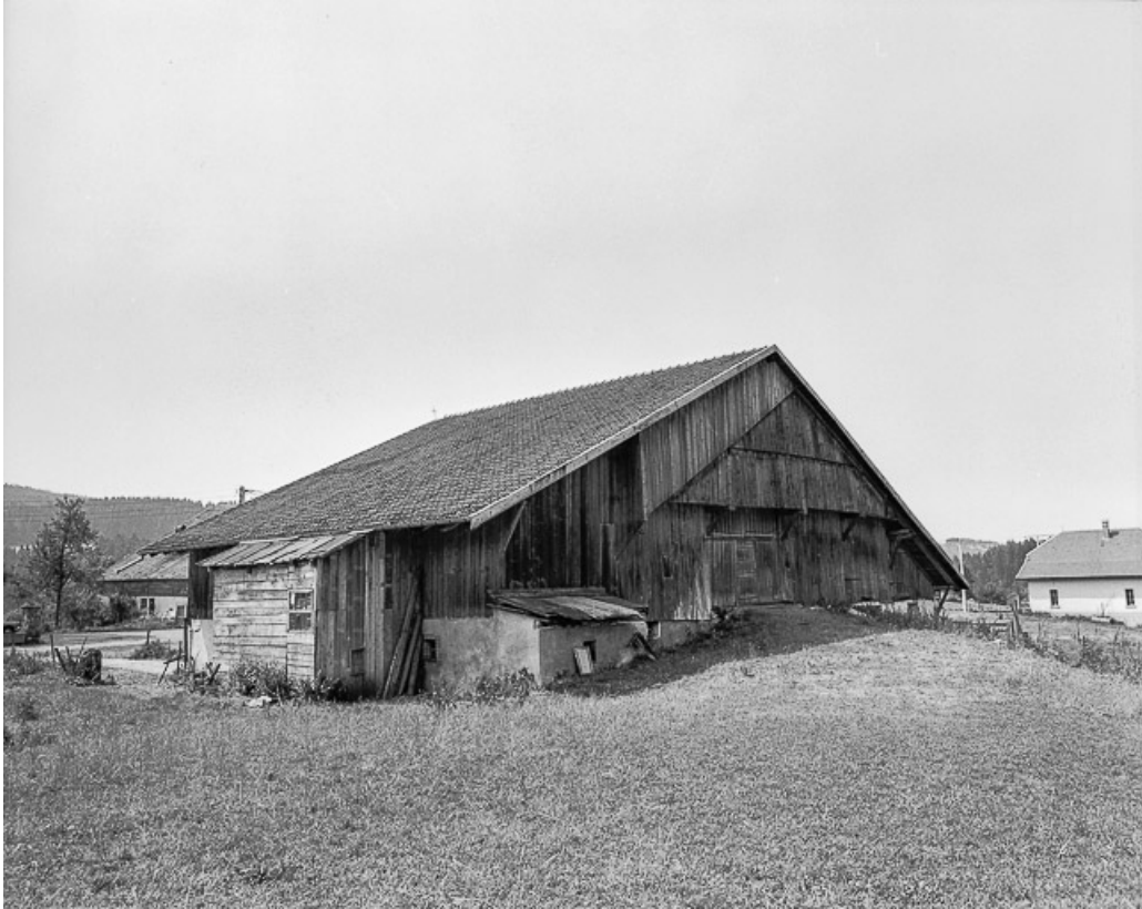
Ferme située au lieu-dit Colombière, cadastrée AB 75 : façade postérieure. 25, Les Combes
