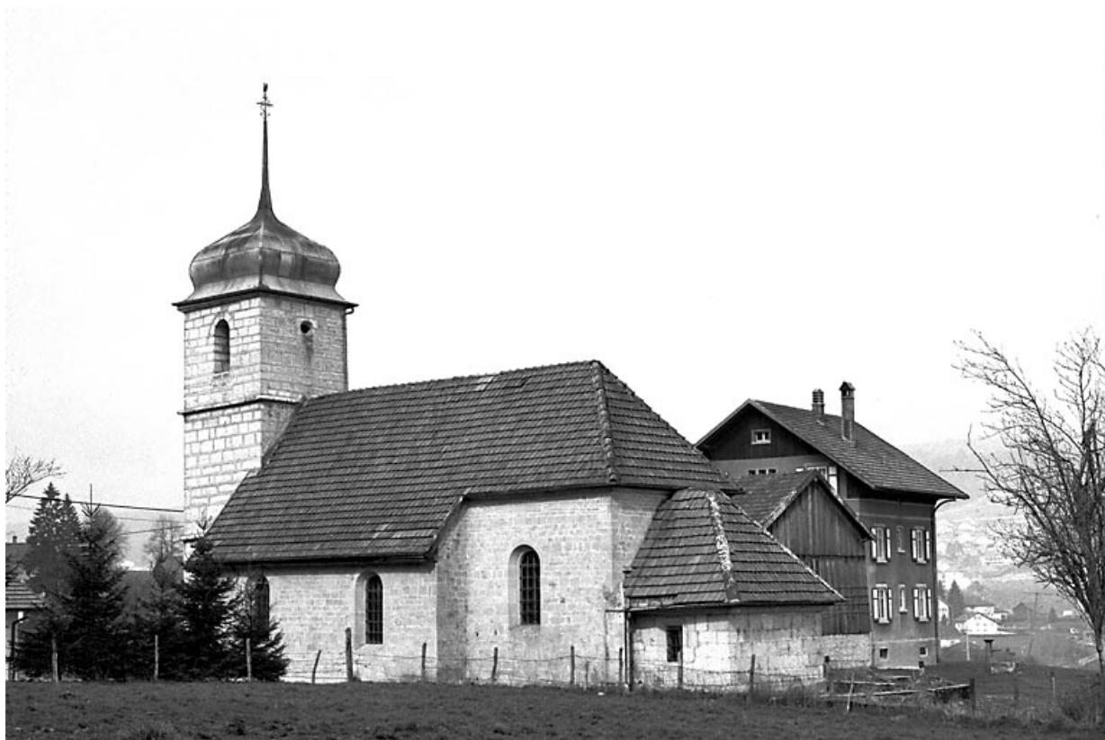
Face latérale droite vue depuis le sud-est.
