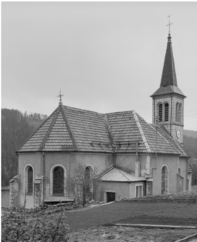
Façades postérieure et face latérale gauche.
