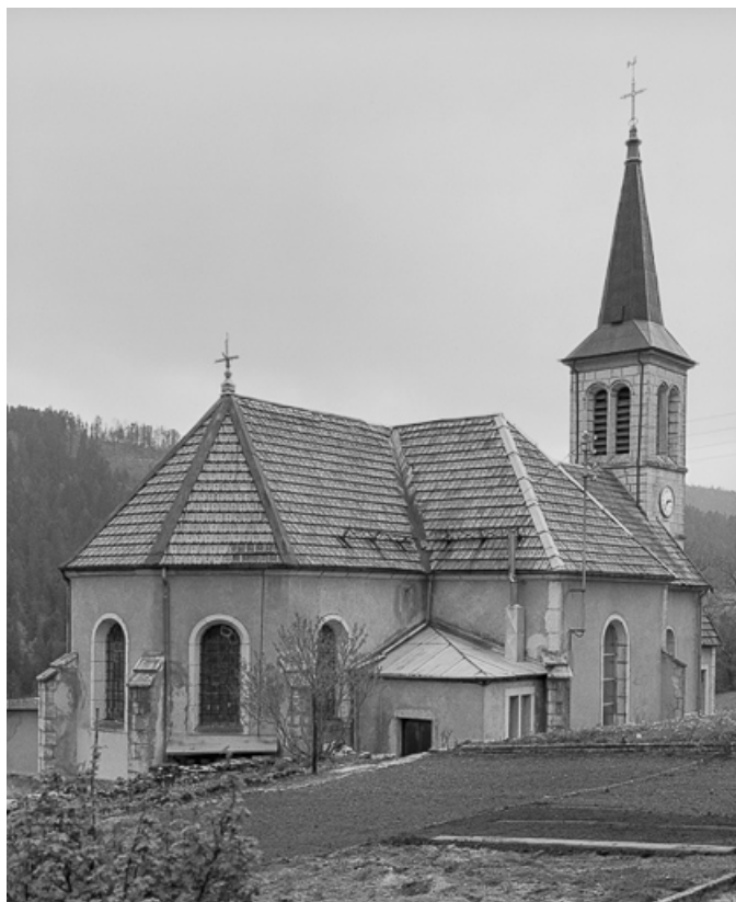
Façades postérieure et face latérale gauche.
