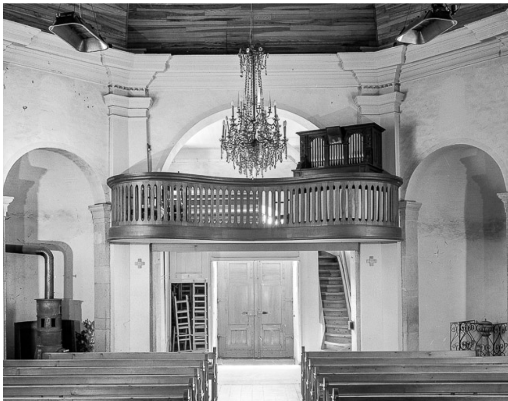
Intérieur : vue d'ensemble depuis le chœur.
