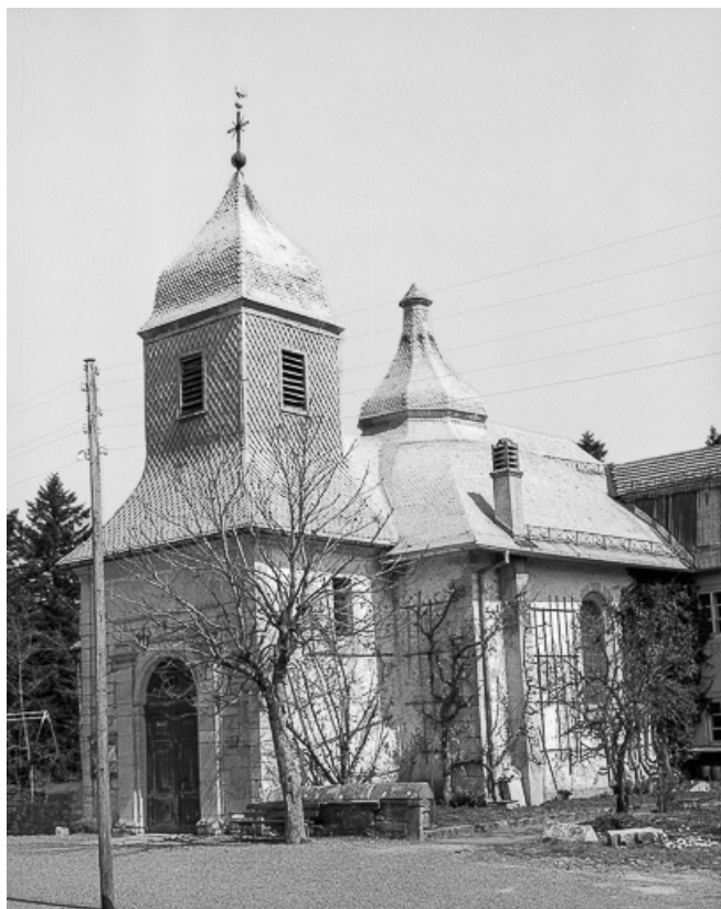
Face antérieure et face latérale droite.
