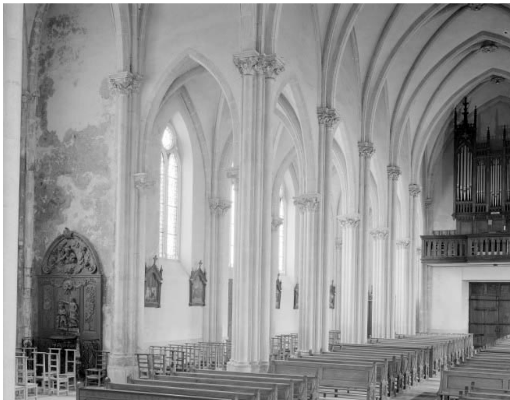
Collatéral droit vu depuis le transept. 25, Villers-le-Lac
