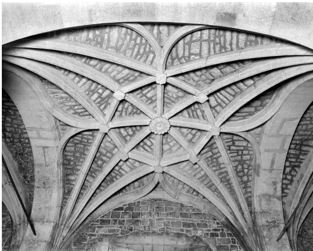
Intérieur : second collatéral gauche, voûtement de la 4ème travée. 25, Morteau rue du Sauron
