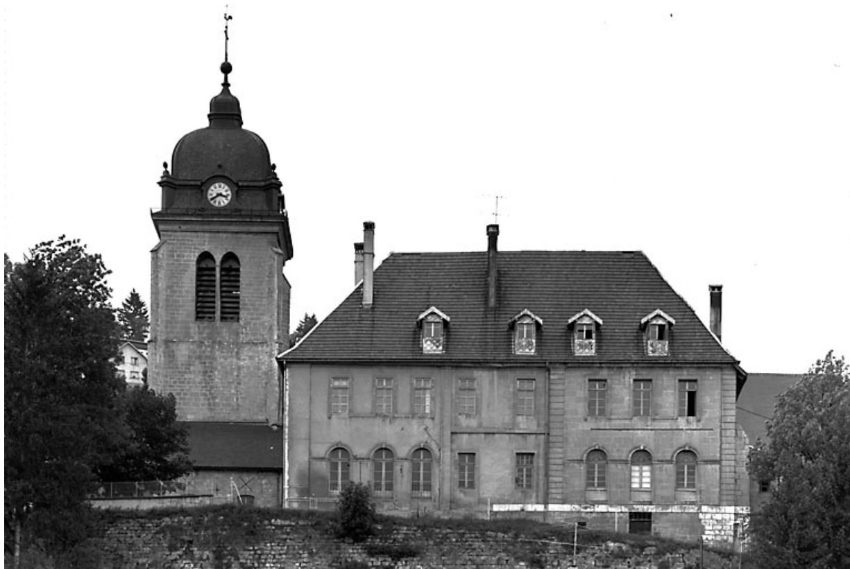
Aile sud du couvent et clocher de l'église.
