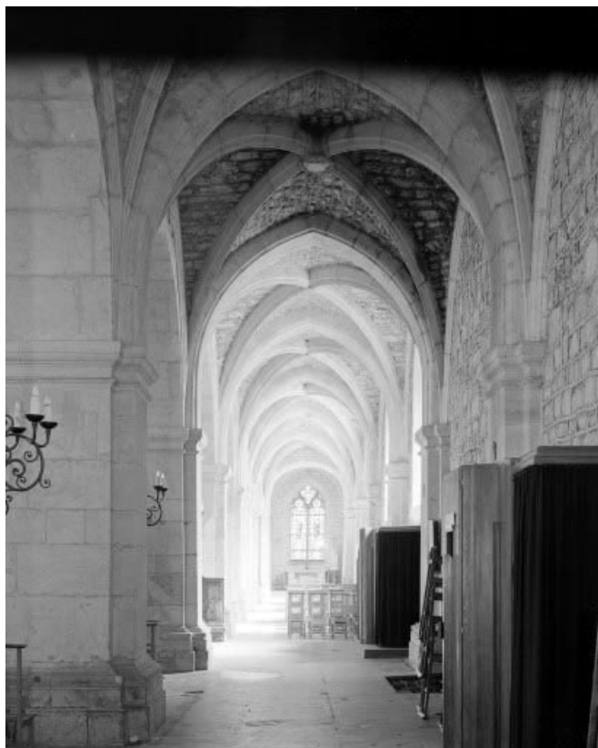
Intérieur : collatéral droit vu depuis l'ouest.
