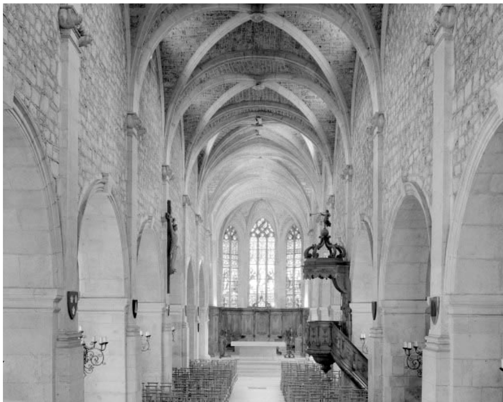
Intérieur : la nef vue depuis le clocher.
