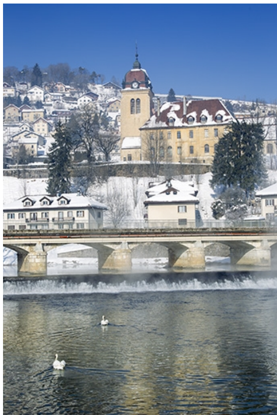
L'église en hiver, depuis les berges du Doubs en aval du pont. 25, Morteau rue du Sauron
