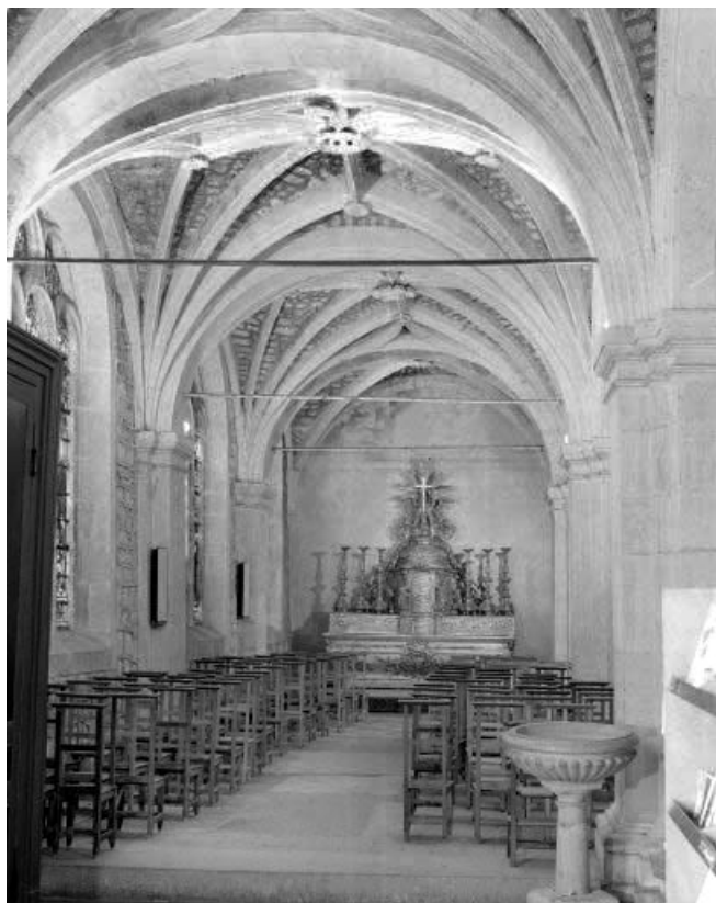
Intérieur : second collatéral gauche vu des trois travées.
