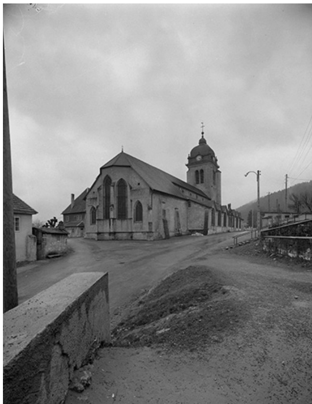
Façade postérieure et face latérale droite. 25, Morteau rue du Sauron
