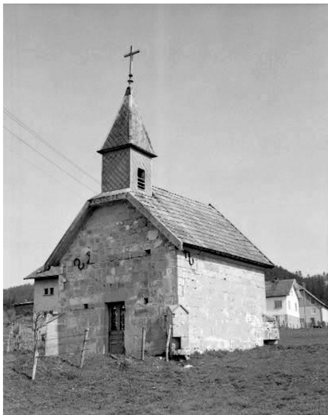
Extérieur : face antérieure et face latérale droite.
