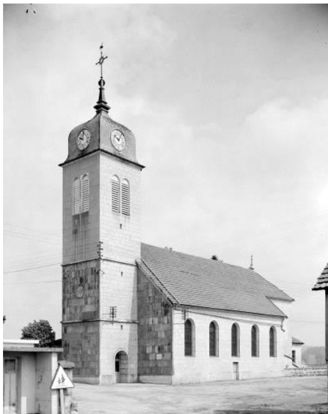
Façade latérale droite.
