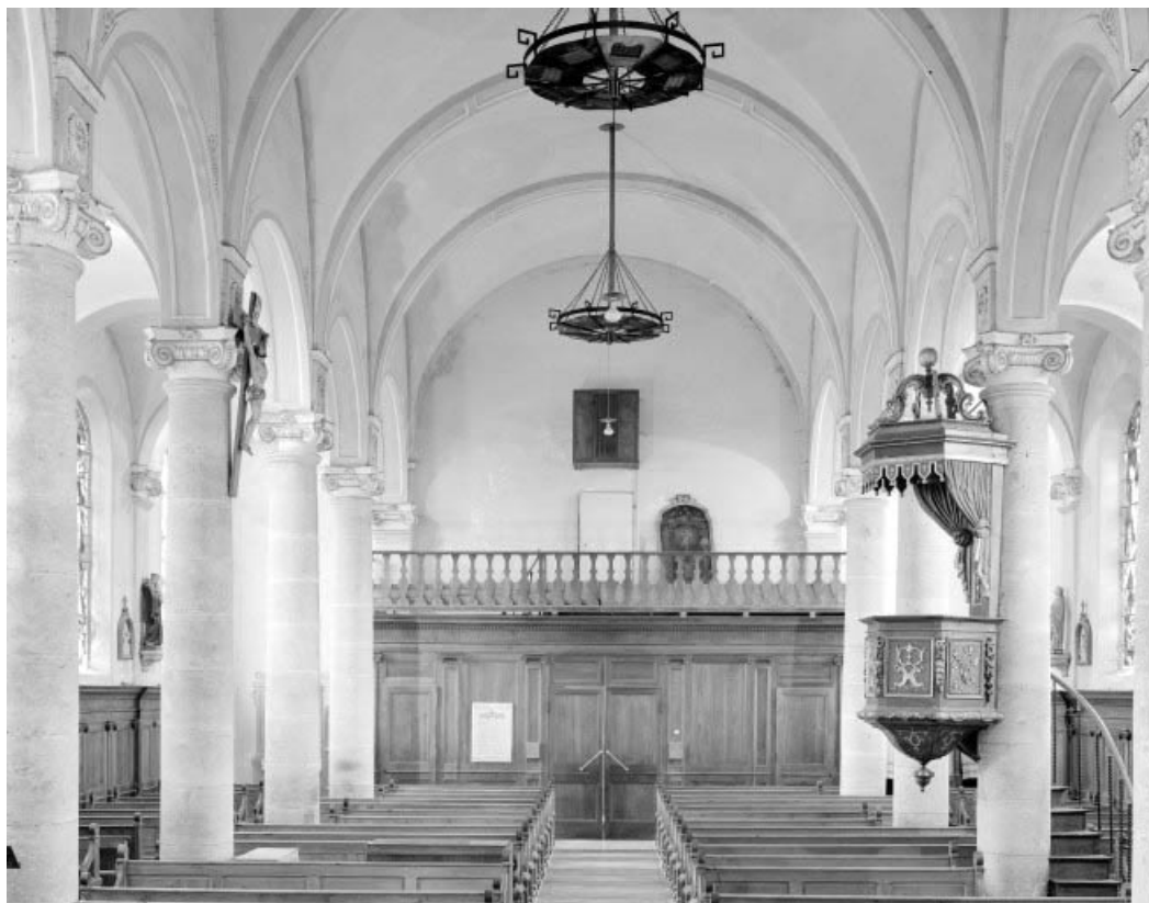
Vue d'ensemble depuis le chœur.
