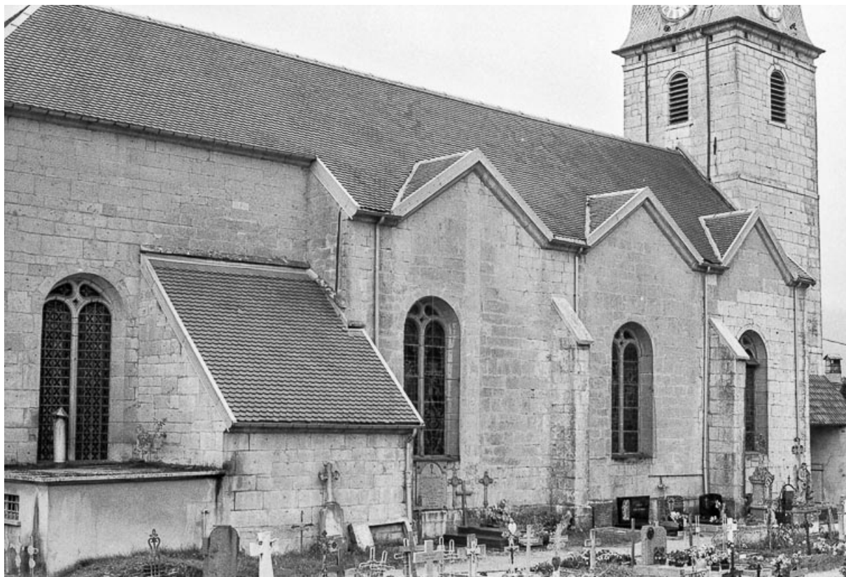
Façade latérale gauche, vue du nord-est. 25, Grand'Combe-Châteleu
