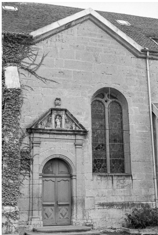
Face latérale droite, troisième travée de la nef. 25, Grand'Combe-Châteleu
