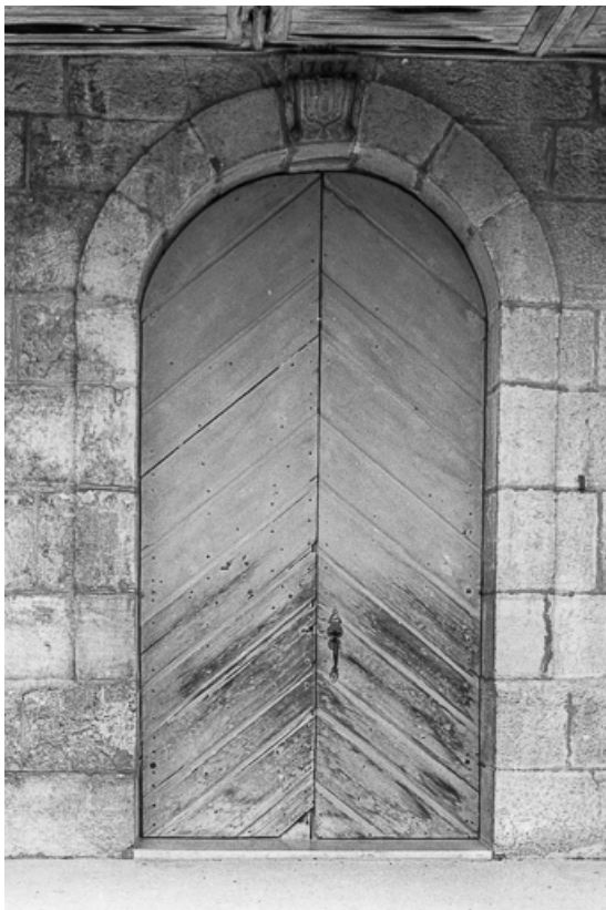
Portail latéral donnant dans le vestibule.
