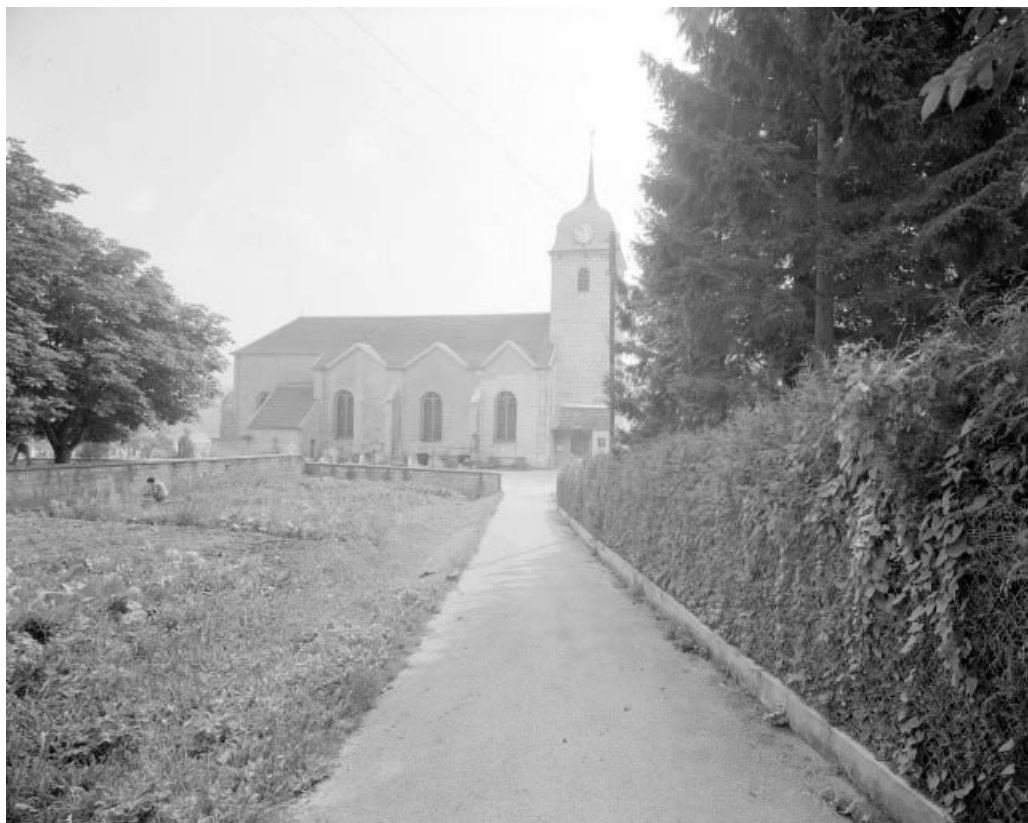
Façade latérale droite.
