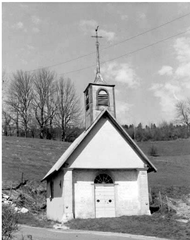
Face antérieure et face latérale droite.
