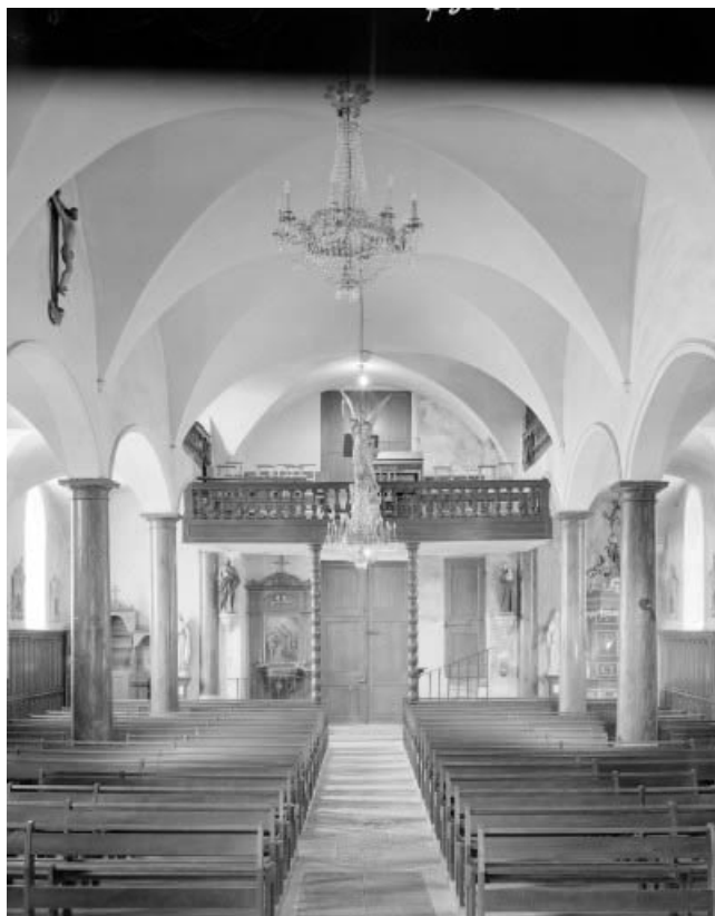
Intérieur : vue d'ensemble depuis le chœur.
