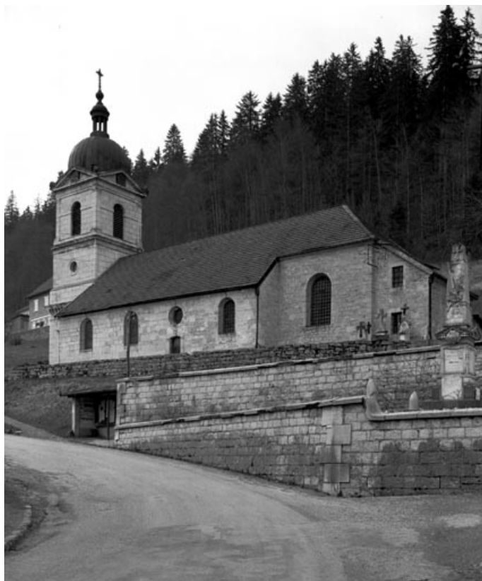
Façade latérale sud.
