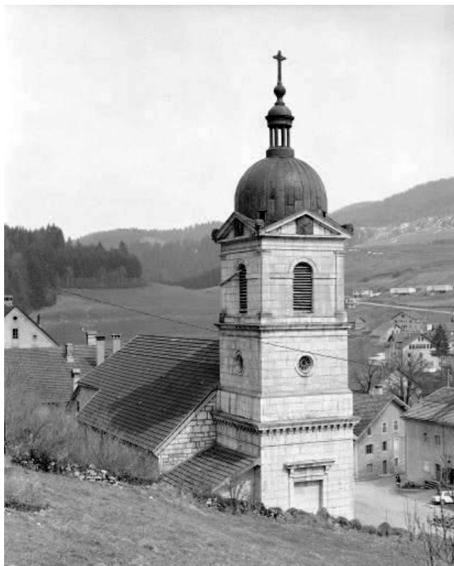
Extérieur : façade antérieure.
