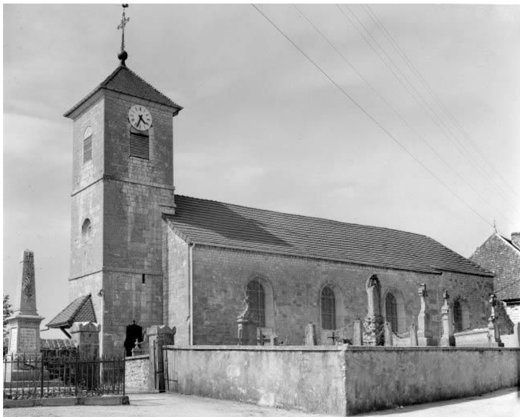
Façades antérieure et latérale droite. 25, Saint-Gorgon-Main
