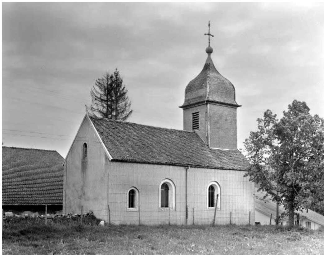
Façades postérieure et latérale gauche. 25, Montflovin
