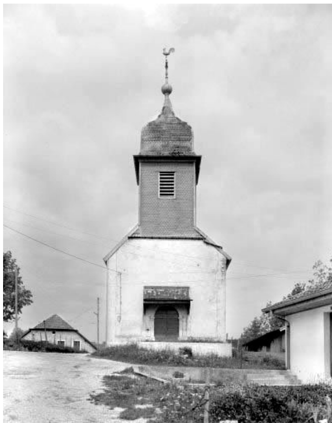
Façade antérieure. 25, Montflovin
