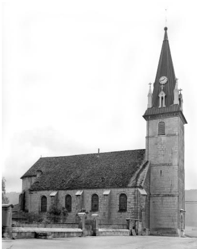
Façade laérale gauche.
