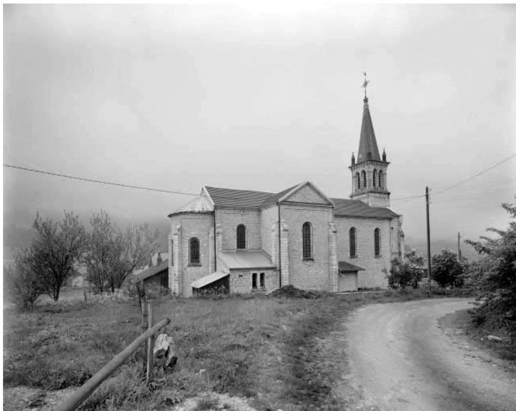
Façade latérale gauche et chevet de l'église.
